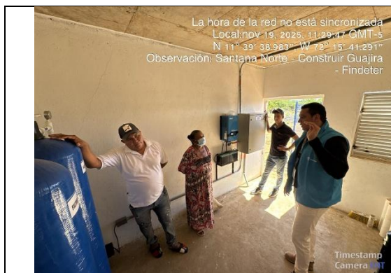
Fotografía 1. Inducción de capacidades en la operación del sistema de tratamiento de agua en la comunidad de Santana Norte.
