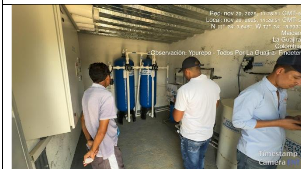
Fotografía 3. Verificación de estado de componentes en la comunidad de Yourepo
