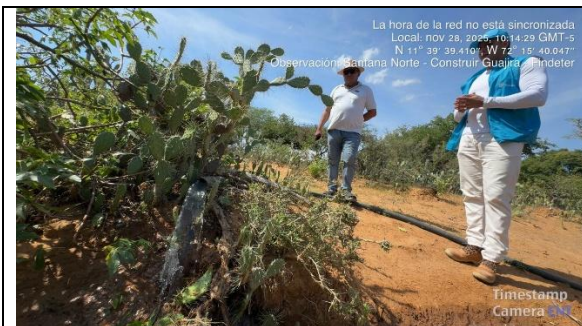
Fotografía 5. Verificación de agua de rechazo al momento de retrolavado.
