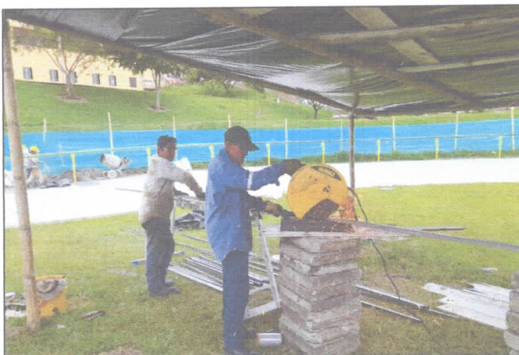
15. Construcción de Baranda
