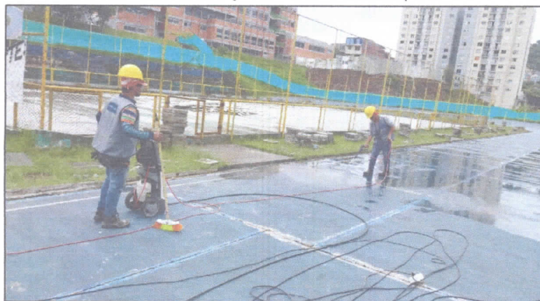
8. Lavada y descontaminada de pista.
