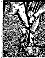
03 Reinstalación de estacas
