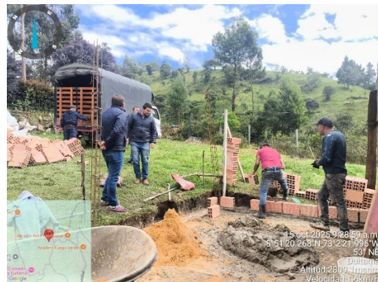
Revisión de cantidades con personal de obra
