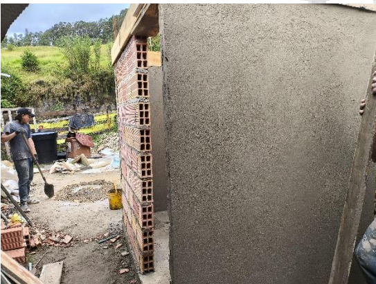
Elevación de muro y pañete
