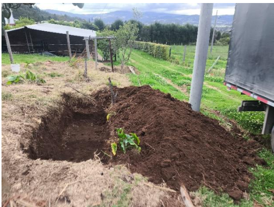
Excavación manual para pozo séptico.
