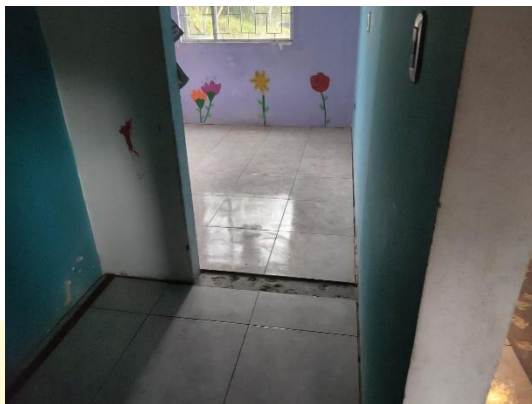
Picado de piso e instalación de enchape
