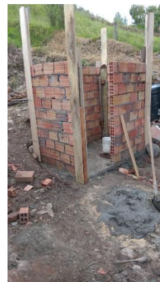
Elevación de muros de unidad sanitaria.
