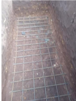
Acero de placa de contrapiso.
