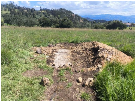
Instalación de tapas de pozo séptico.
