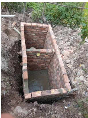
Elevación de muros de pozo séptico
