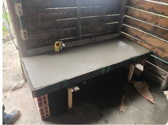
Muros en bloque y bandeja de mesón.
