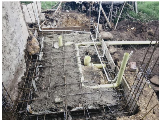
Instalación de redes para unidad sanitaria.
