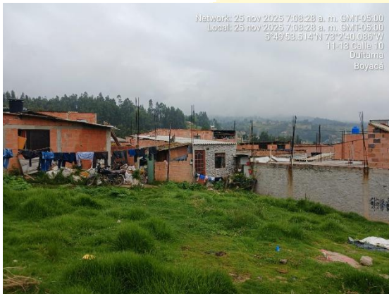
Instalación de cubierta
