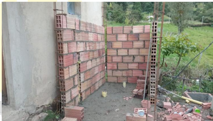
Elevación de muros para unidad sanitaria
