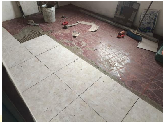
Enchape de piso habitaciones
