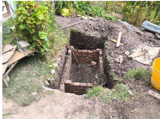
Muros de pozo séptico.
