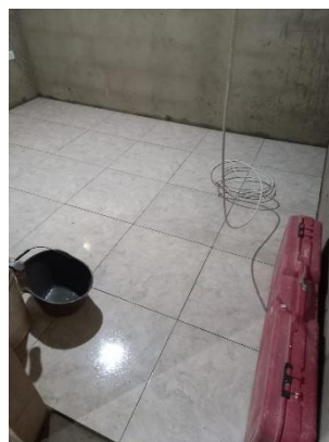
Enchape de piso habitaciones
