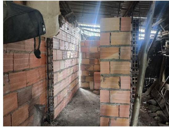
Elevación de muros en bloque
