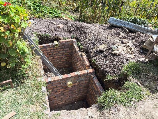
Elevación de muros e instalación de accesorios de pozo séptico
