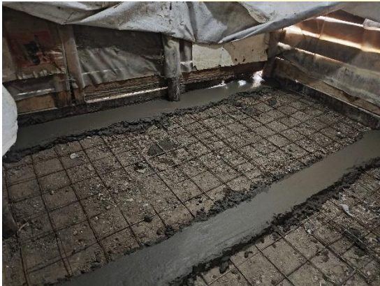
Instalación de malla electrosoldada y fundición de maestras para placa.
