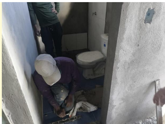
Instalación de accesorios y enchape de piso y pared.
