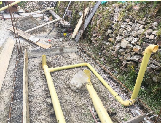
Instalación de red hidrosanitaria
