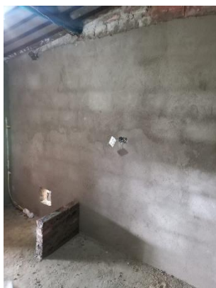
Pañete de muros y muro para meson
