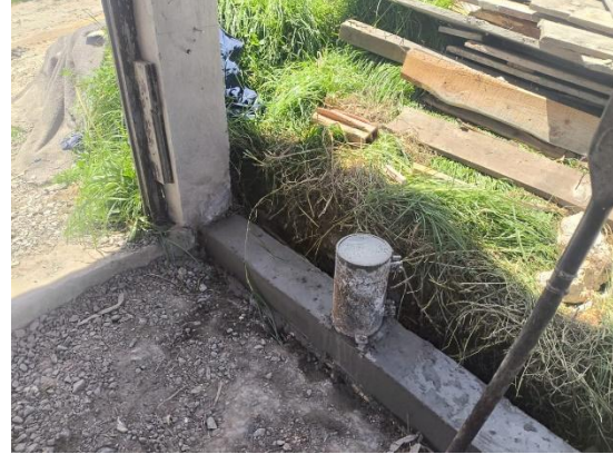
Toma de muestras de concreto para evaluación de resistencia.
