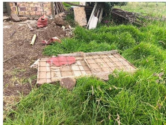
Acero para función de tapas de pozo séptico
