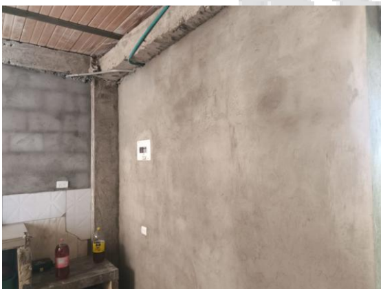
Pañete de muros internos
