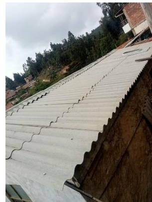
Instalación de cubierta
