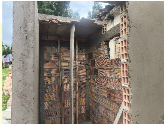
Fundición de placa de tanques.
