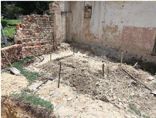
Replanteo de unidad sanitaria
