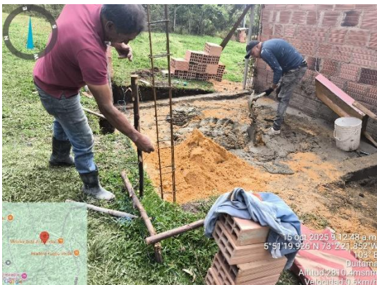
Amarre de acero de columnas
