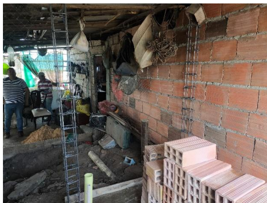
Amarre de acero de columnas
