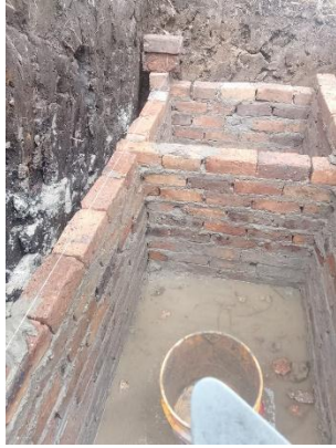
Realización de pozo séptico
