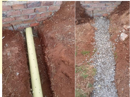
Instalación de lecho filtrante
