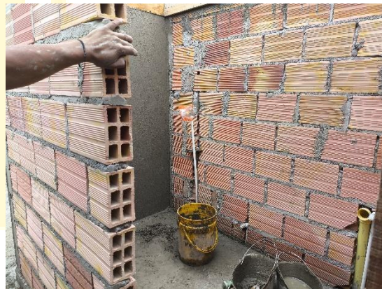
Instalación de red hidráulica
