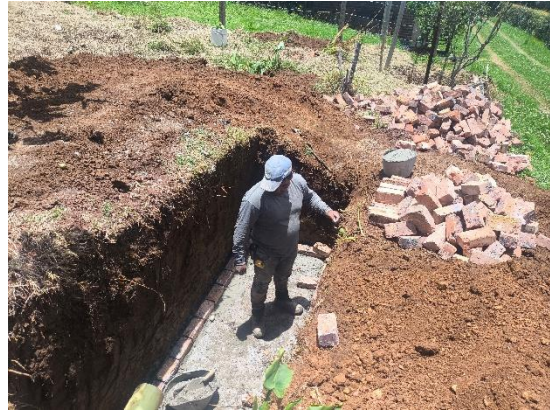
elevación de muros de pozo séptico.
