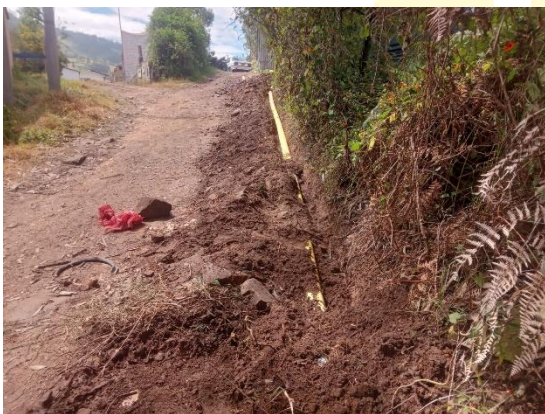
Instalación de tubería de 4"
