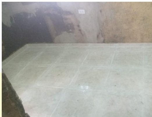
Enchape de piso de cocina
