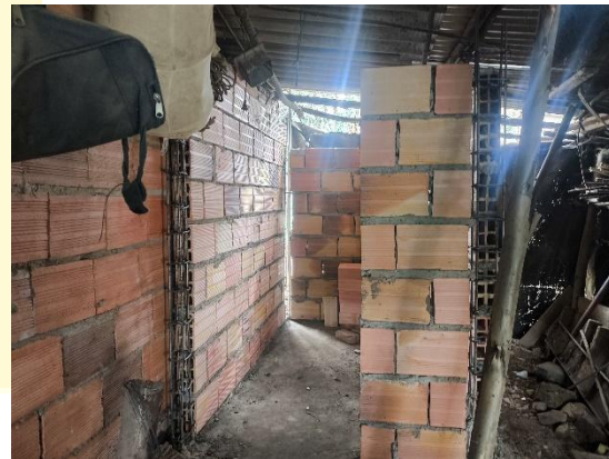
Elevación de muros en bloque
