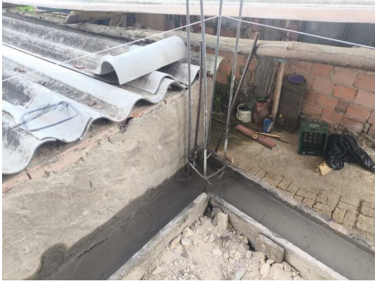
Fundición de viga de cimentación y anclaje para columnas.
