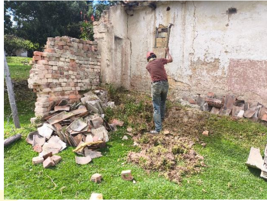
Nivelación de terreno
