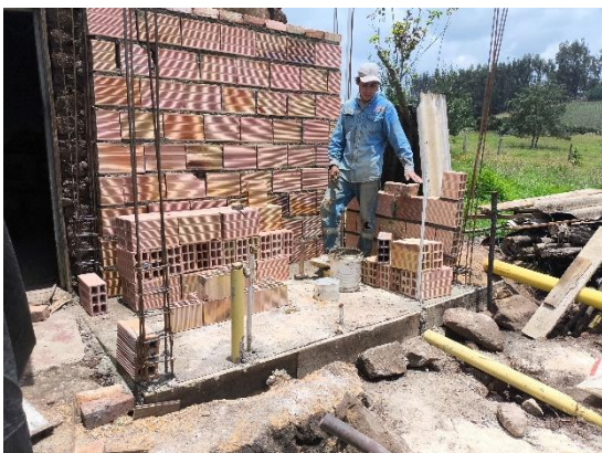
Amarre de acero de columnas y elevación de muro en bloque.
