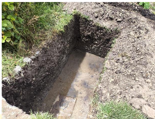
Excavación para pozo séptico.
