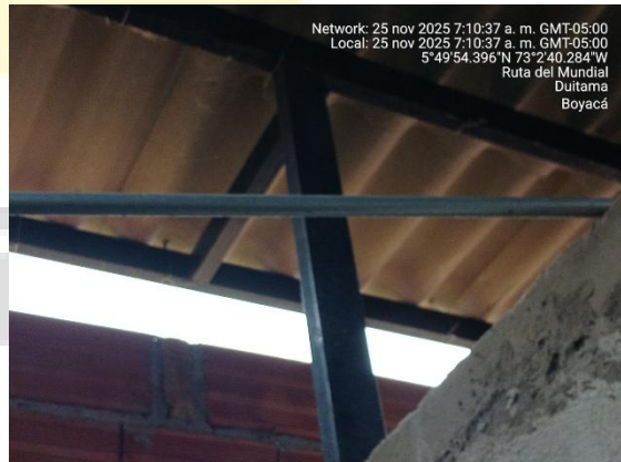
Instalación de perfilera para cubierta
