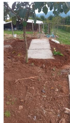
Adecuación de terreno.
