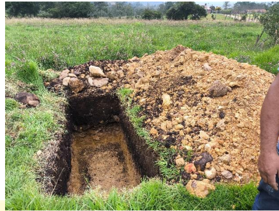
Excavación manual para pozo séptico
