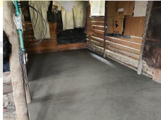
Placa de concreto sellada.
