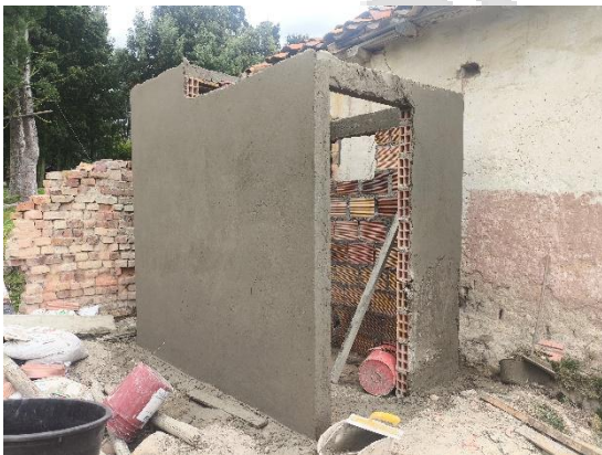
Pañete de muros en bloque
