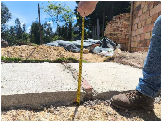
Verificación de espesores de placas de concreto.
