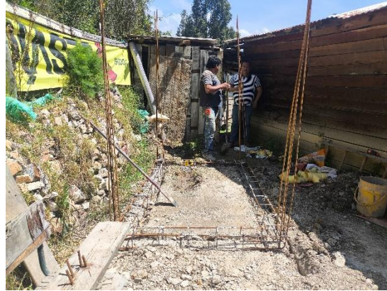
Amarre de acero para viga y columnas.
