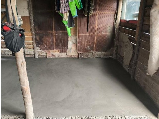
Placa de concreto sellada.
