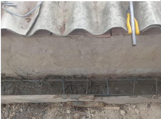
Solado y amarre de acero.
