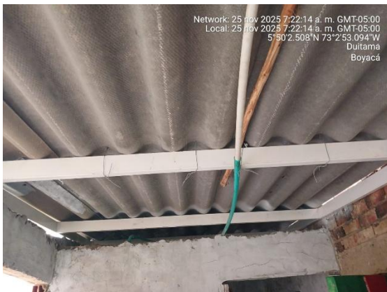
Instalación de cubierta
