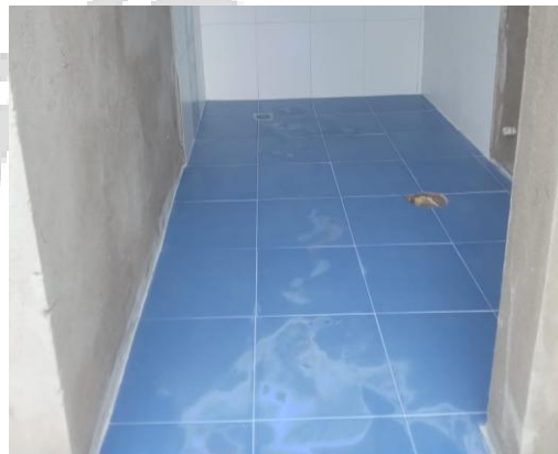
Instalación de enchape de piso y pared
