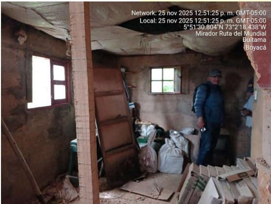
Demolición de muro existente
