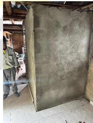
Enchape de piso y construcción de unidad sanitaria
