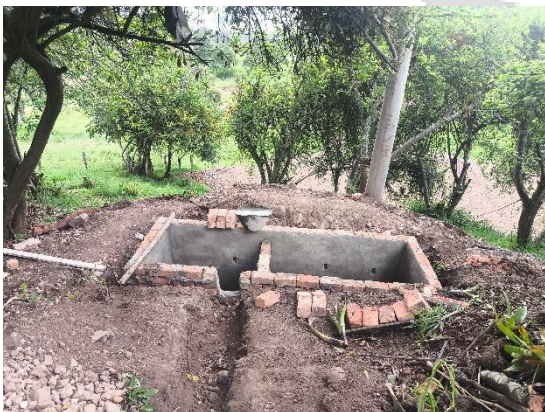
Elevación de muros de pozo séptico
