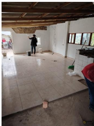
Pintura de muros y enchape de piso
