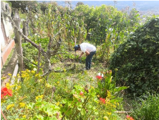
Replanteo de excavación para pozo.
