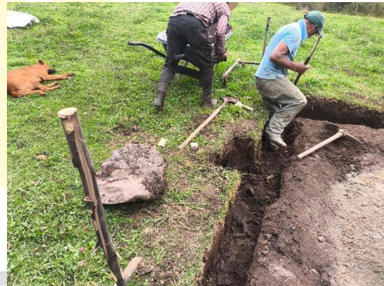
Excavación manual para cimentación
