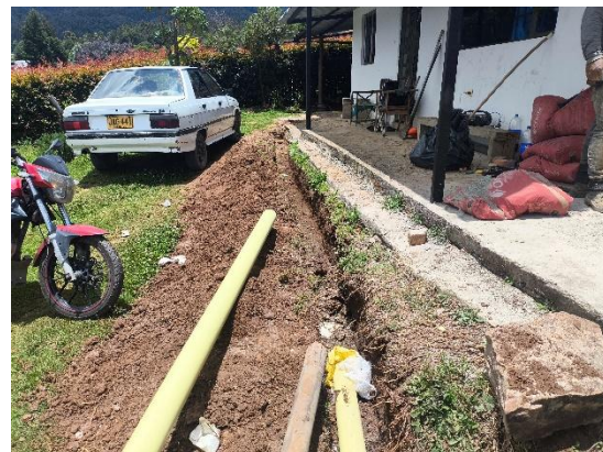
Excavación para instalación de tubería.
