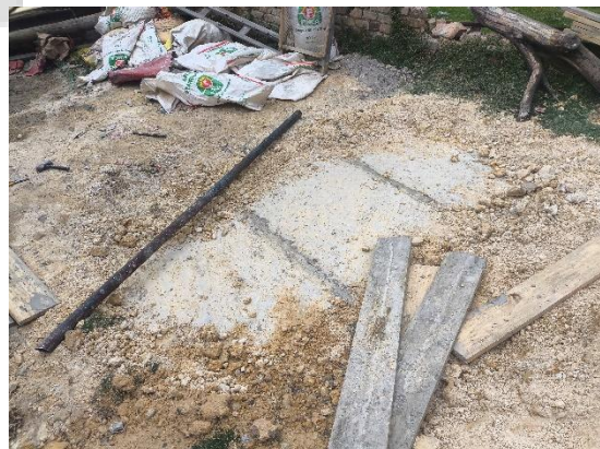
Instalación de tapas de pozo séptico.
