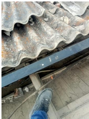
Desmante de teja e instalación de perfilera metálica
