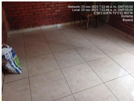
Instalación de enchape de piso
