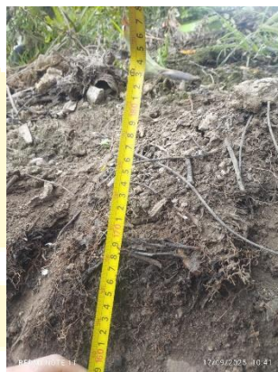
Revisión de niveles de excavación.
