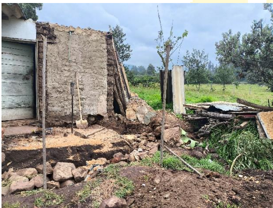
Replanteo de vigas y placa de cimentación.
