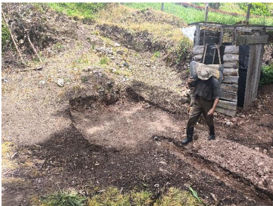
Nivelación y replanteo de terreno.
