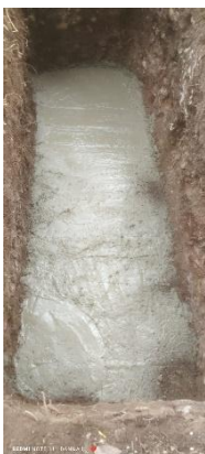
Placa de contrapiso de pozo séptico.
