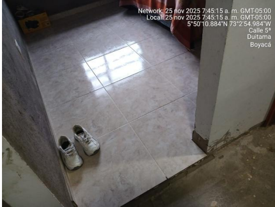
Enchape de piso
