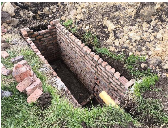
Elevación de muros de pozo séptico.
