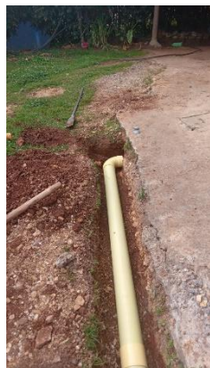
Conexión de tubería a la vivienda
