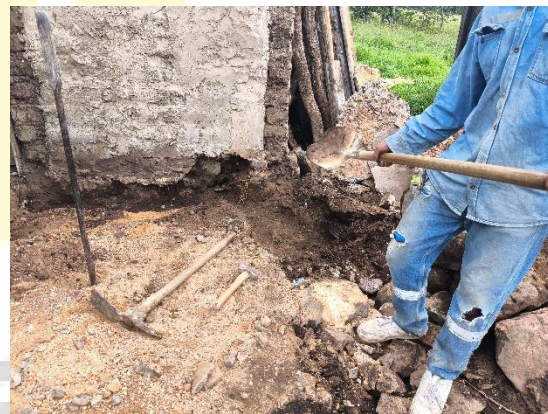
Excavación manual de vigas de cimentación.
