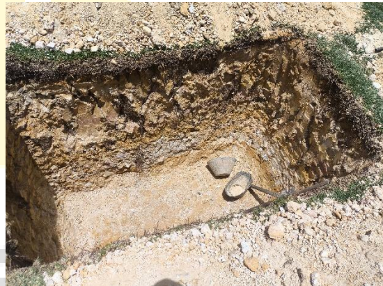
Excavación de pozo séptico.
