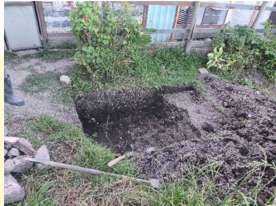
Excavación para pozo séptico.
