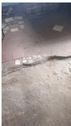
Demolición de piso existente
