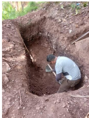
Excavación manual para pozo séptico.
