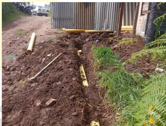
Ajuste de entierro de tubería
