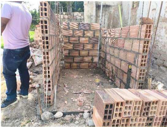
Elevación de muros en bloque
