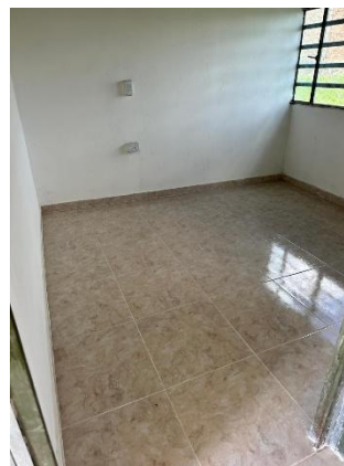
Enchape de piso y pintura de muros
