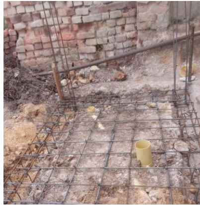
Amarre de acero de unidad sanitaria.
