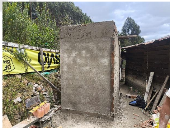
Fundición de placa de tanques.
