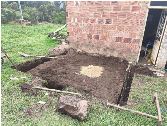
Localización y nivelación de terreno
