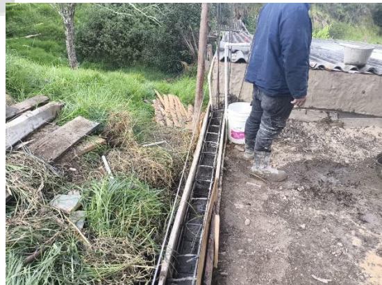
Trazo de niveles para fundición de viga de cimentación.
