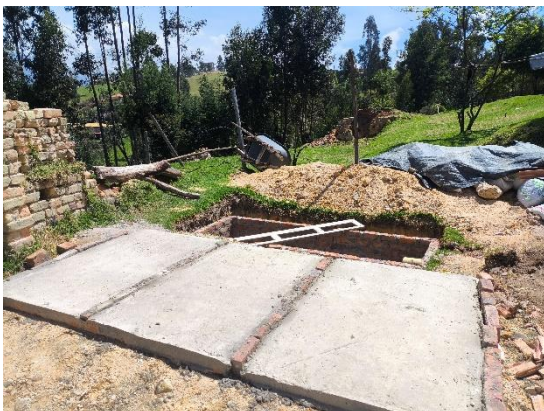
Fundición de tapas y elevación de muros de pozo séptico.
