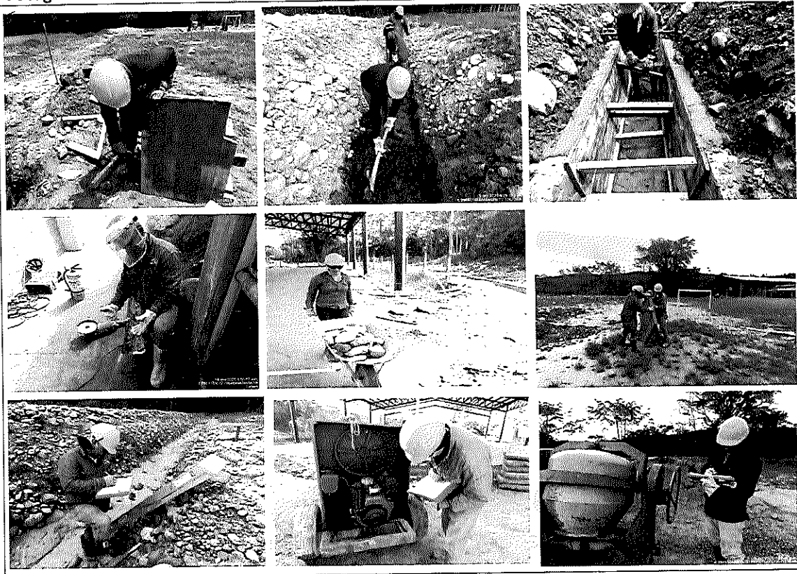
Fotografía 3. Uso de EPP riesgo mecánico e inspecciones de maquinas, herramienta menor y equipos
