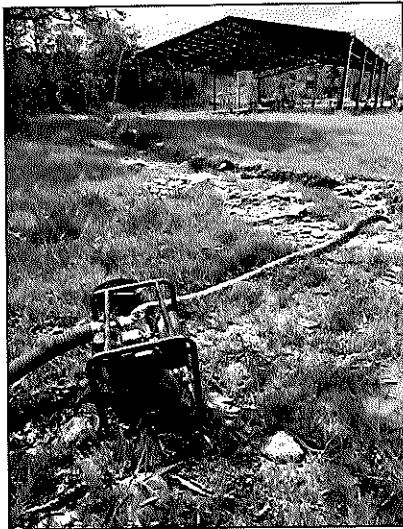
FIGURA 11 EVACUACIÓN DE AGUAS LLUVIAS SOBRE CANAL PERIMETRAL
