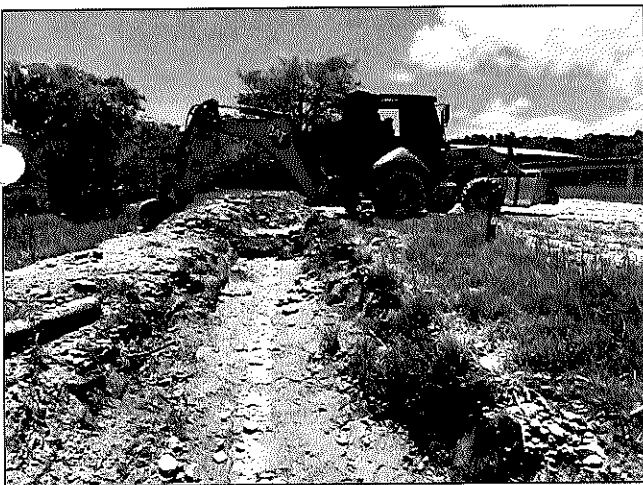
FIGURA 12 SOBRE EXCAVACIÓN DE CANAL PERIMETRAL
