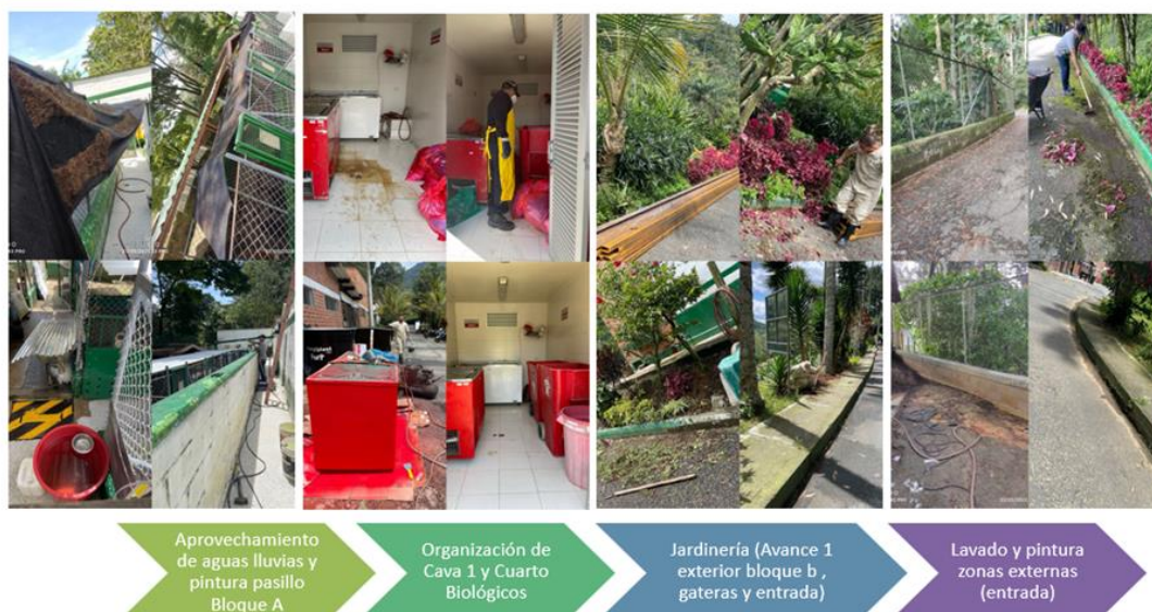
Fotografía 2. Mantenimiento locativo, parte 1. Mayo de 2025.
