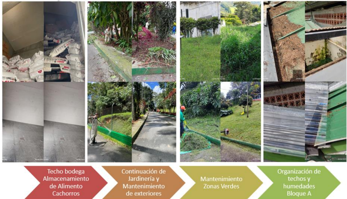
Fotografía 5. Mantenimiento locativo, parte 4. Mayo de 2025.
