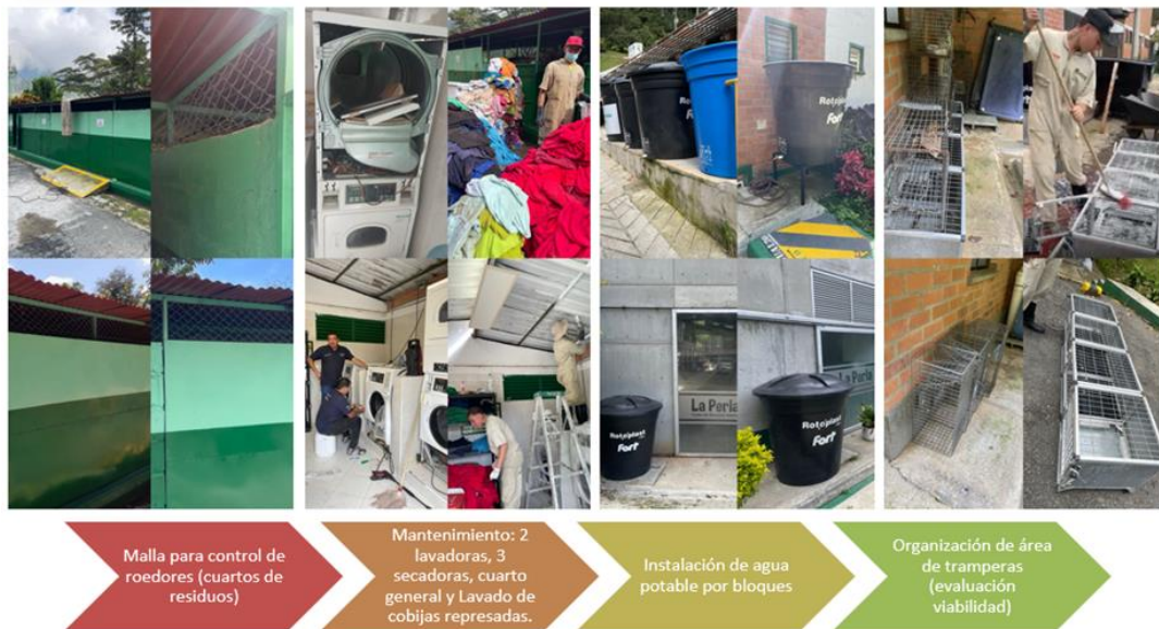
Fotografía 3. Mantenimiento locativo, parte 2. Mayo de 2025.
