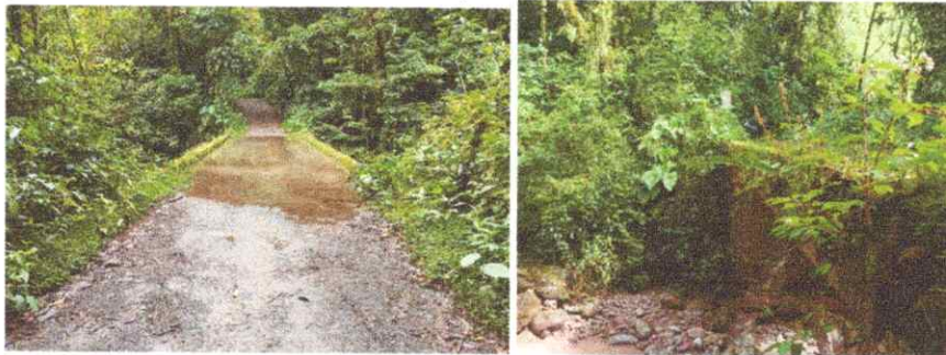
Ilustración 18. Visita de Inspección Ocular cuarto puente
