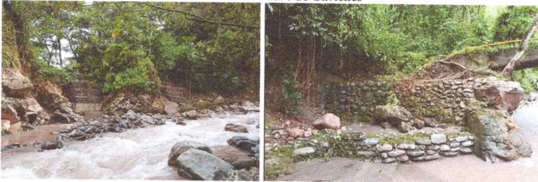
Ilustración 13 Muro de Gaviones
