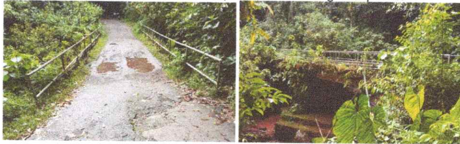
Ilustración 14. . Visita de Inspección Ocular segundo puente
