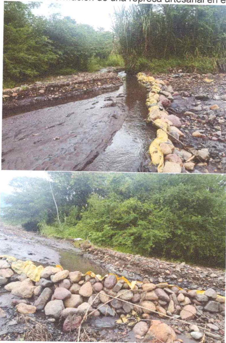
Ilustración 7. Formación de una represa artesanal en el río
