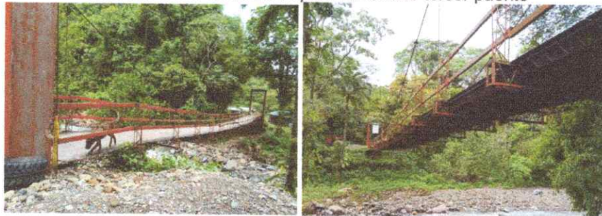
Ilustración 16. Visita de Inspección Ocular tercer puente
