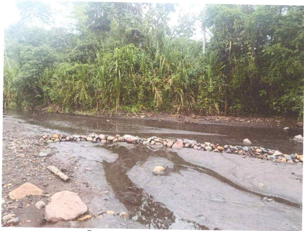
Ilustración 5. Construcción longitudinal con piedras y sacos
