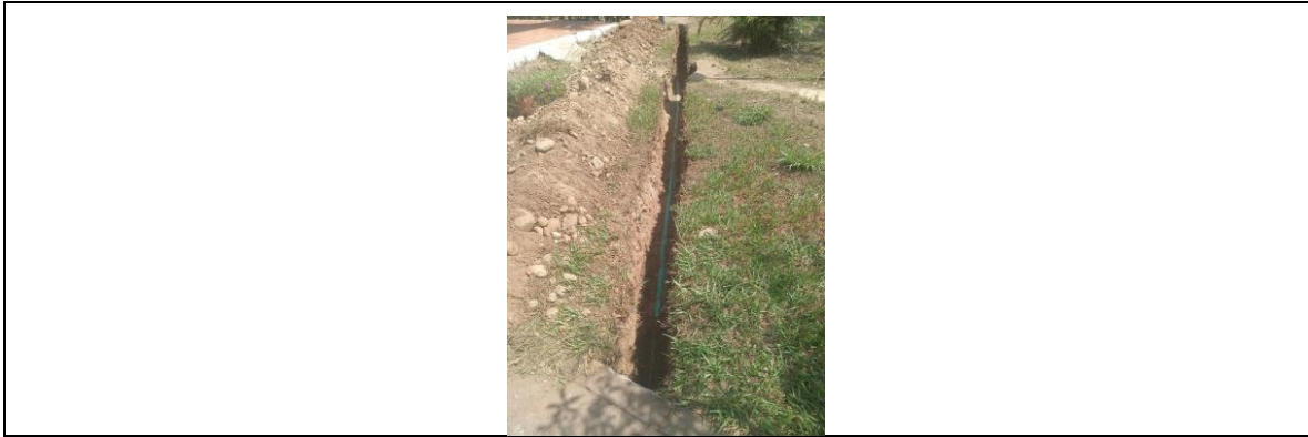
Reg. Fot. No. 9, Instalación Encamado tubería con arena apisonada (arena sucia de río)
