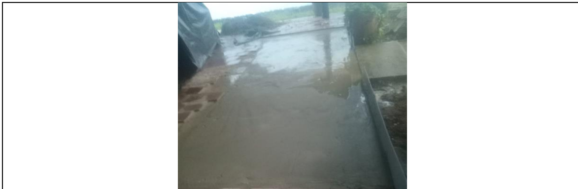
Reg. Fot. No. 31, Alistado endurecido mortero 1:3 H=4
