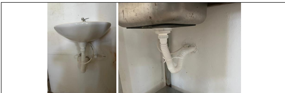
Reg. Fot. No. 21, Salida sanitaria pvc-s/paral 2"
