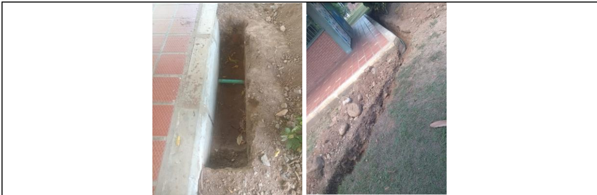
Reg. Fot. No. 8, de Excavación manual zanja en tierra h=1.0 m
