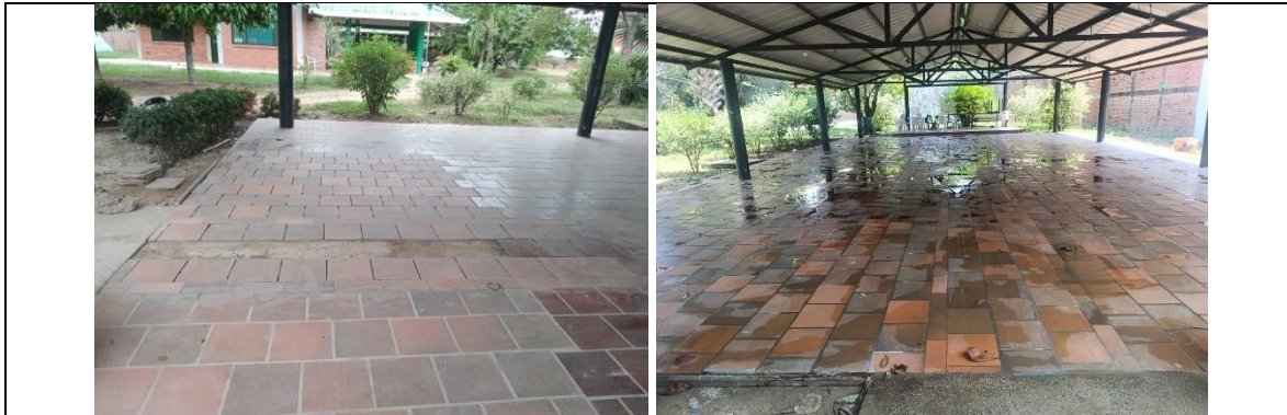
Reg. Fot. No. 32, Tableta gres liso de 33 x 33 mortero 1:4
