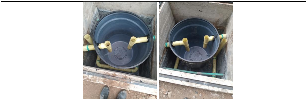
Reg. Fot. No. 5, instalación de Tanque Plástico 1000 Lt en trampa de grasas
