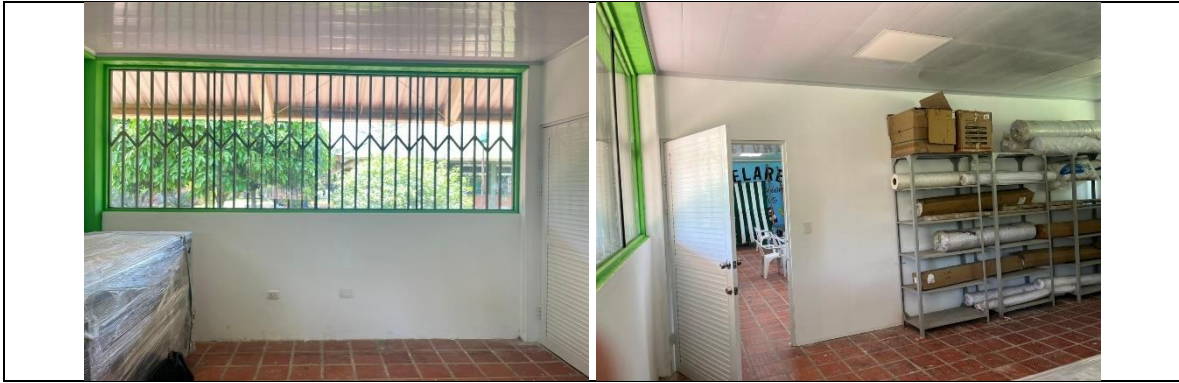
Reg. Fot. No. 13, pintura sobre muros existentes interiores incluye resanes con o sin estuco
