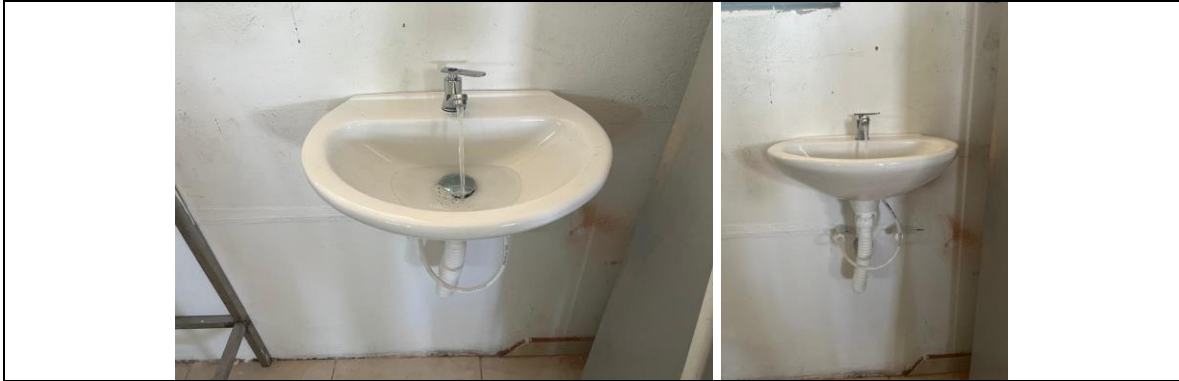
Reg. Fot. No. 28, instalación lavamanos existente o reutilizado tipo cerámico
