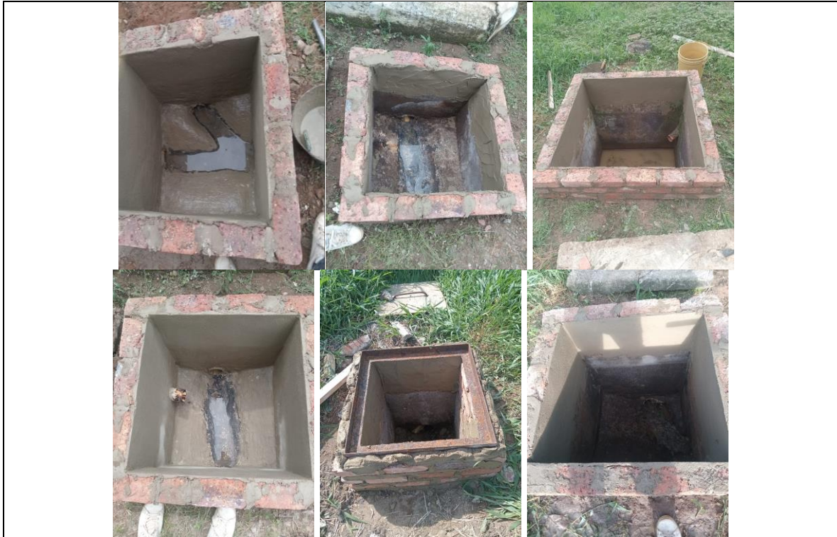
Reg. Fot. No. 6, instalación de Pañete Liso Sobre Muros 1:4
