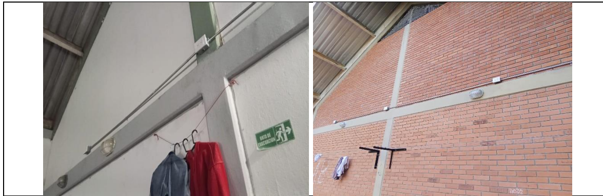
Reg. Fot. No 13, instalación de tubería unidad de 3 metros EMT 1/2"
