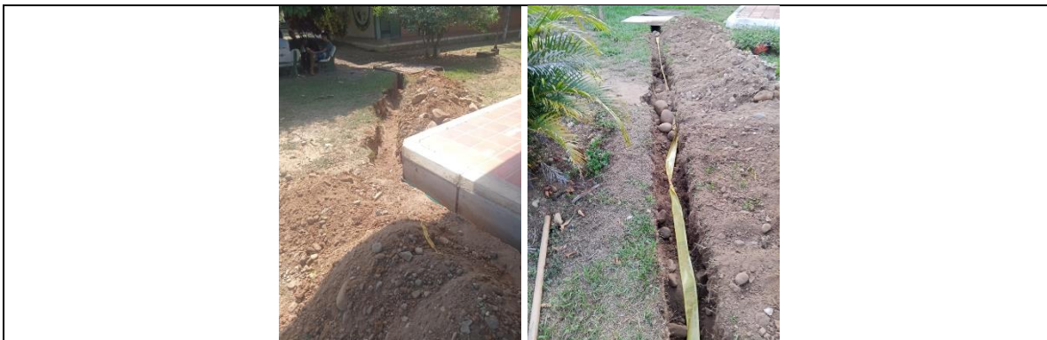
Reg. Fot. No. 10, aplicación de Relleno con material seleccionado
