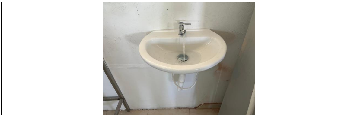
Reg. Fot. No. 26, Instalación de grifería para lavamanos tipo monocontrol.
