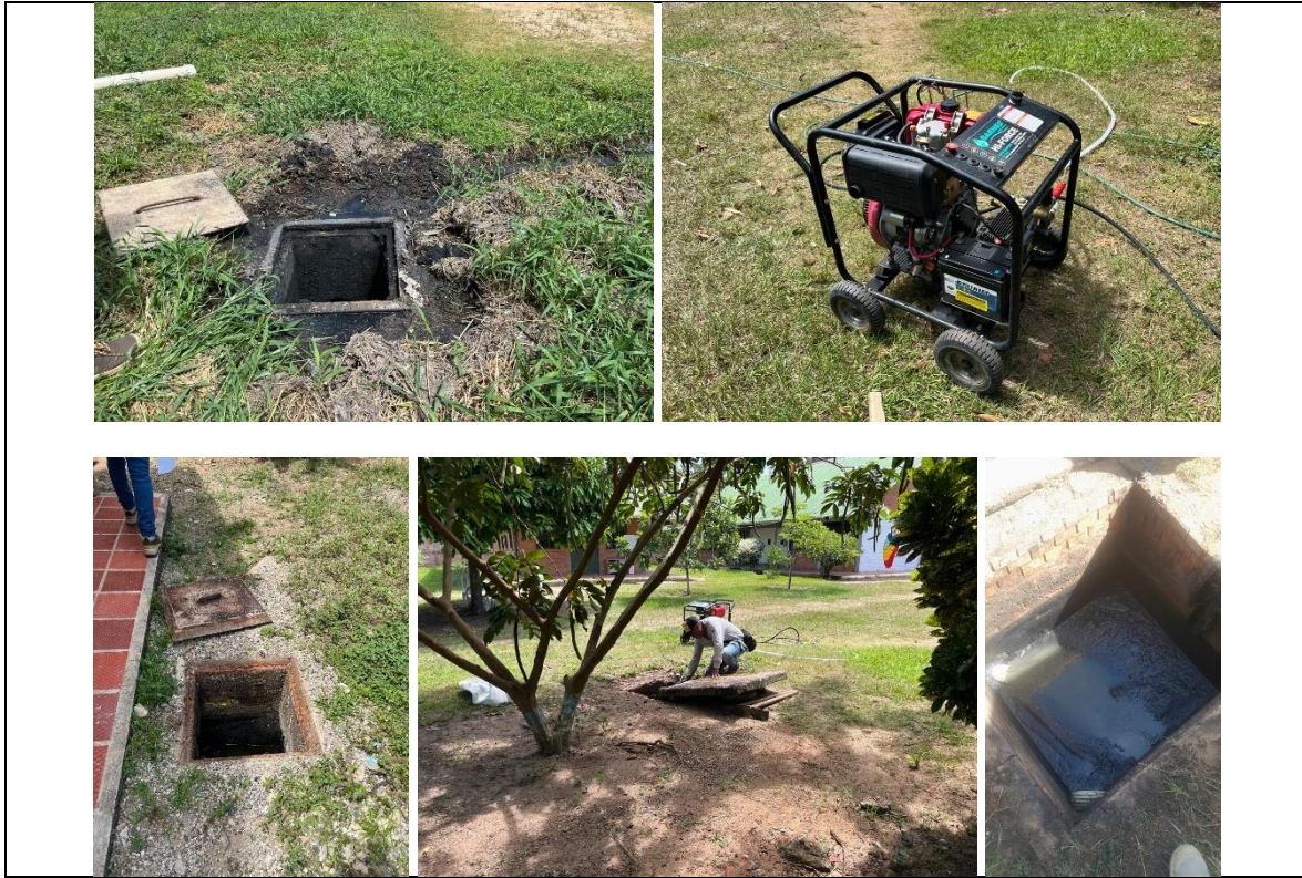
Reg. Fot. No. 10, Limpieza cajas de inspección
