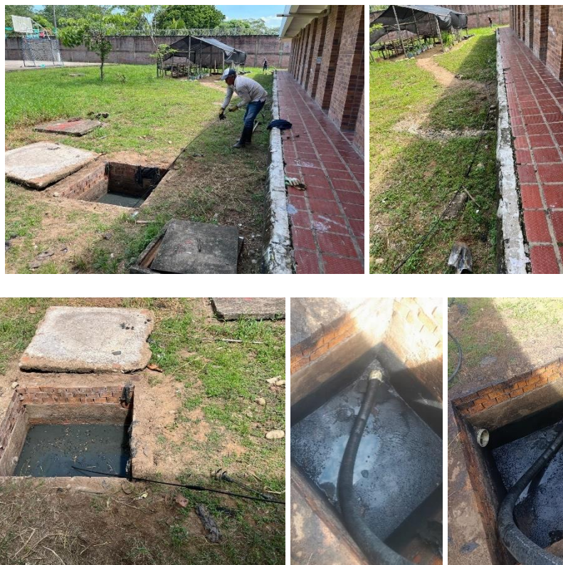
Reg. Fot. No. 09, limpieza de redes sanitarias con sonda eléctrica.
