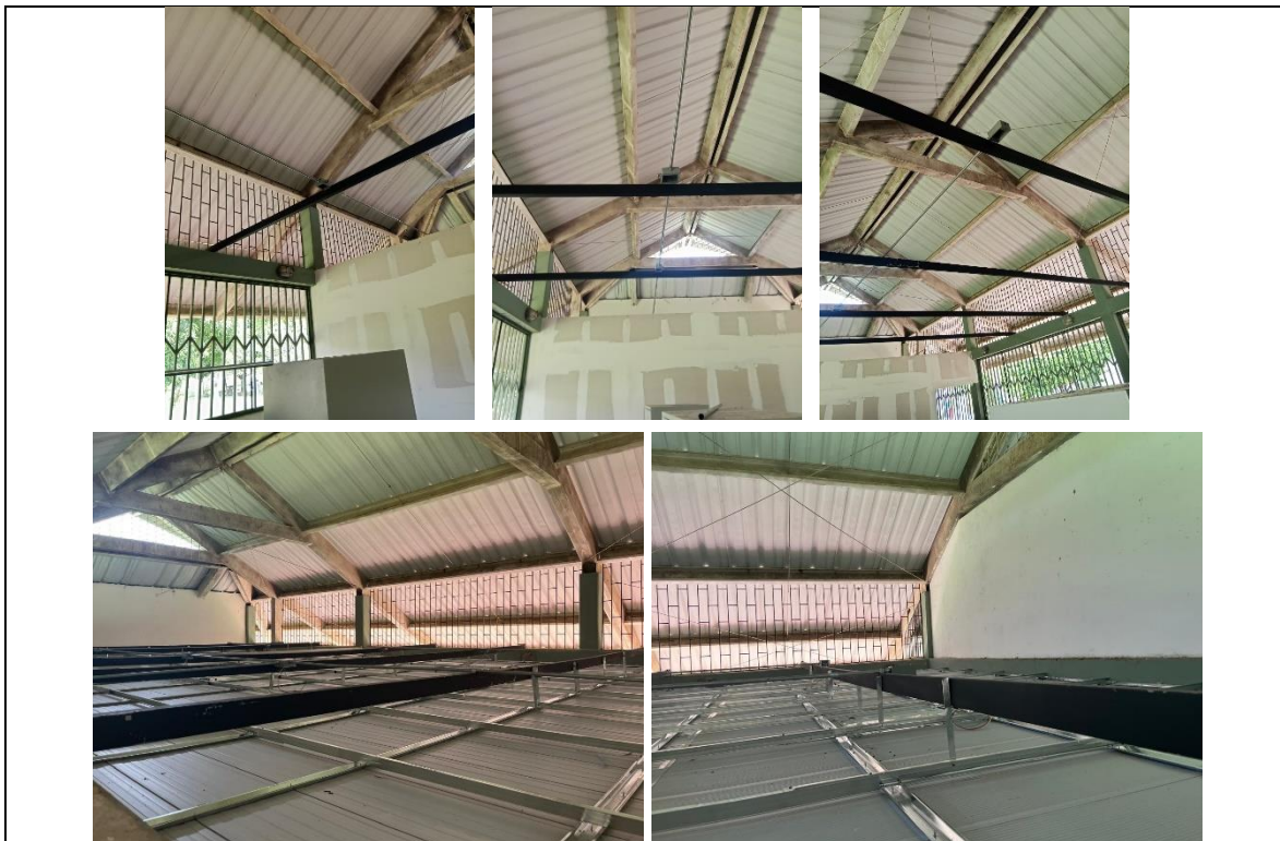
Reg. Fot. No. 12, instalación de estructura metálica para cubierta
