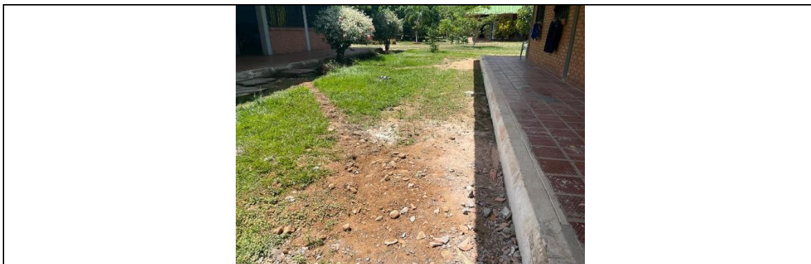
Reg. Fot. No. 24, Excavación manual zanja en tierra h=1.0 m
