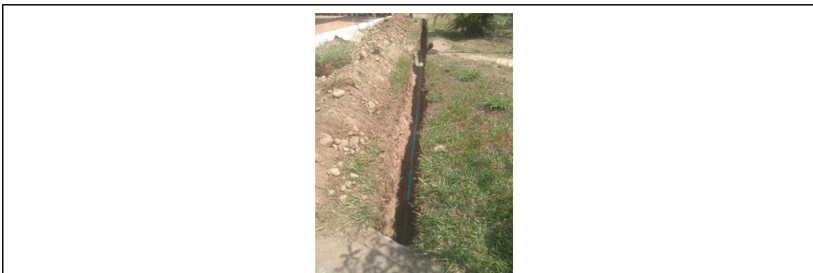
Reg. Fot. No. 9, Instalación Encamado tubería con arena apisonada (arena suciade rio)
