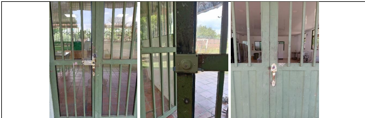
Reg. Fot. No. 5, instalación de Chapa Yale L 370 (embutir)
