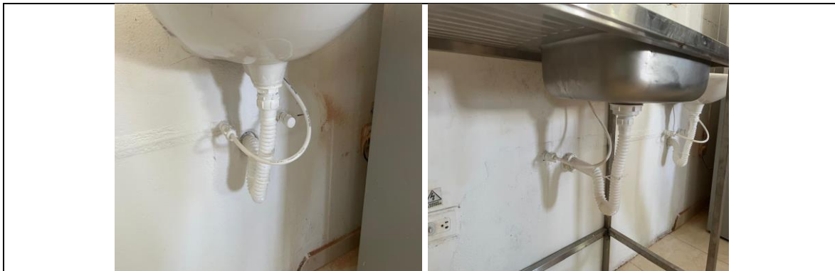
Reg. Fot. No. 20, Punto hidráulico pvc-p/paral 1/2"
