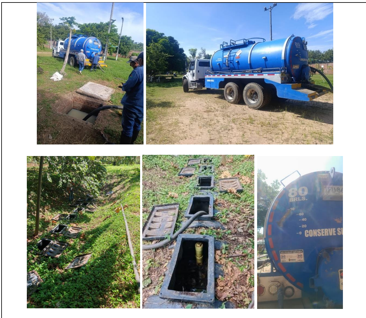
Reg. Fot. No. 08 , succión con vector por medio de camión de vacío de cap. 80 bls, a estructura de PTAR.
