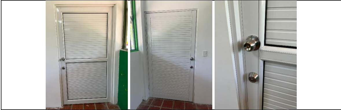
Reg. Fot. No. 16, instalación de Puerta y marco enchapada a una cara en aluminio, marcos en aluminio.
