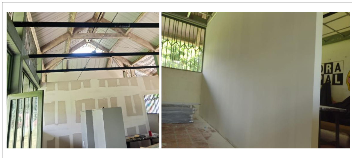
Reg. Fot. No. 05, instalación de Muro drywall doble cara 0.10 m - (incluye estructura, accesorios, anclaje, cinta y pintura)
