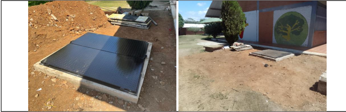
Reg. Fot. No. 7, construcción e instalación de tapa en lamina alfajor
