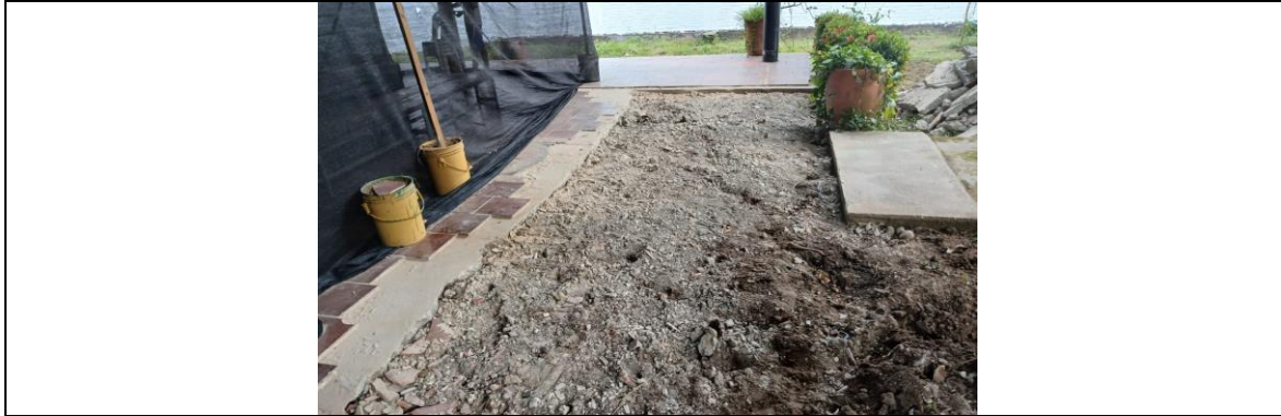
Reg. Fot. No. 30, Demolición placa piso 0.20 m
