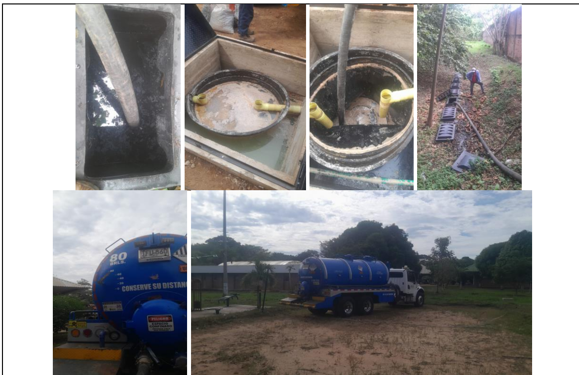
Reg. Fot. No. 01 , succión con vactor por medio de camión de vacío de cap. 80 bls, a estructura de PTAR.
