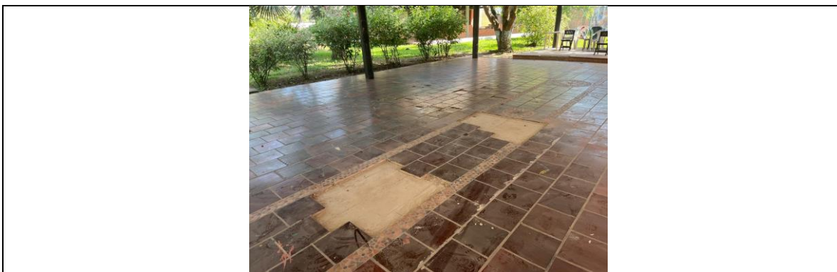
Reg. Fot. No. 29, Localización y replanteo
