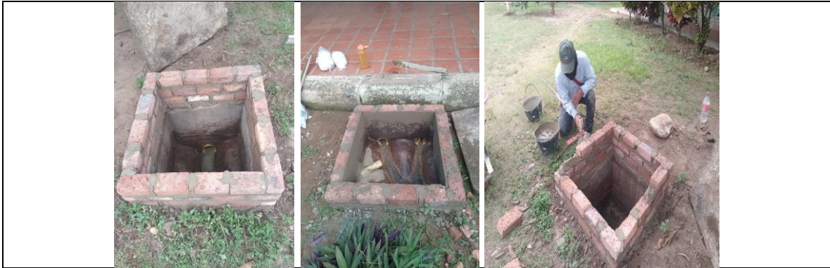
Reg. Fot. No. 4, Confinamiento En Ladrillo Prensado Liviano Para Pisos Exteriores
