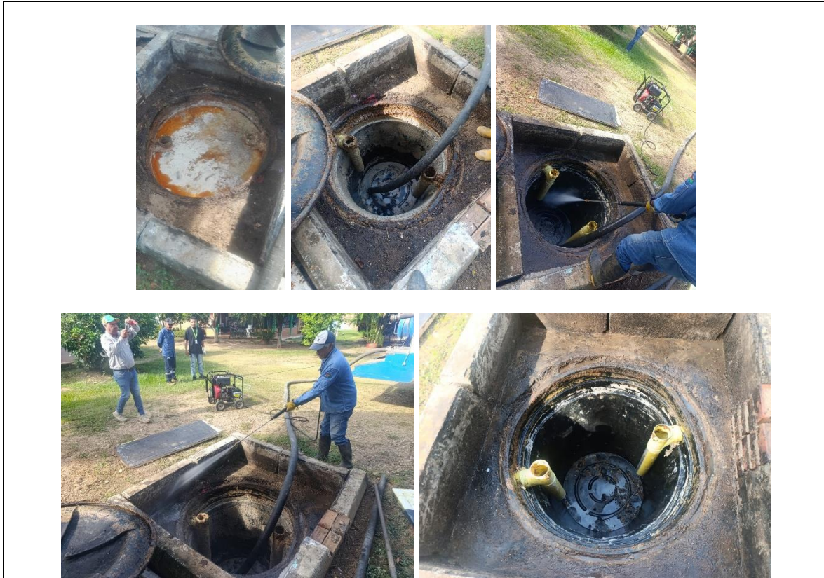
Reg. Fot. No. 07, mantenimiento preventivo le la trampa de grasas de 250 - 500 LT
