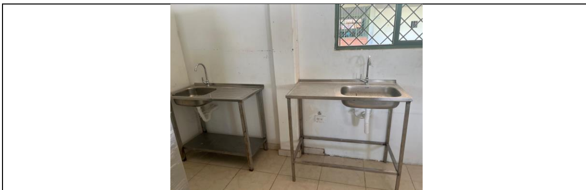
Reg. Fot. No. 25, lavaplatos una poceta (35 x 50 cms) en acero inoxidable de empotrar
