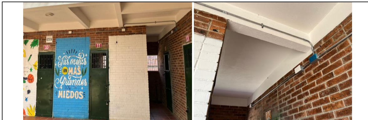
Reg. Fot. No 35 , instalación de tubería unidad de 3 metros EMT 1/2",
