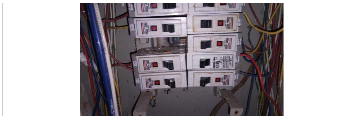
Reg. Fot. No 12, Instalación De Interruptor Termomagnético Unipolar 1x20 A
