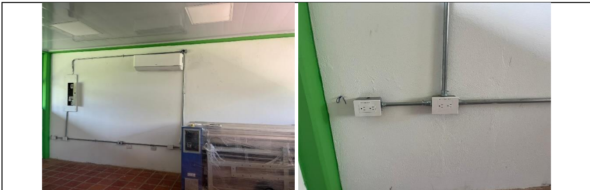
Reg. Fot. No. 14, tomacorriente con polo a tierra color marfil o similar deben cumplir normas ul 498 15a 120 vac
