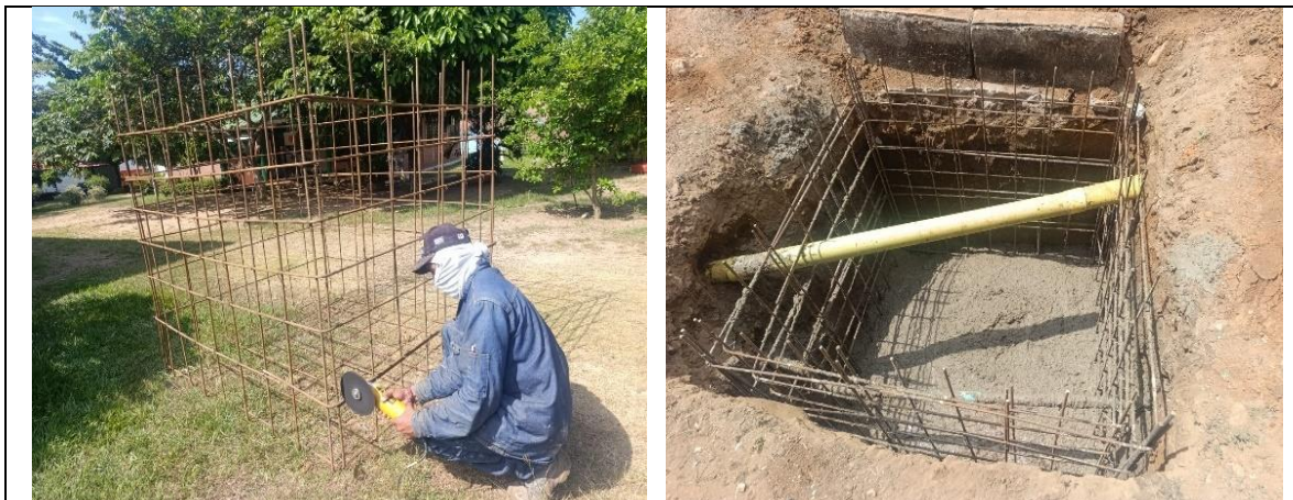
Reg. Fot. No. 03, Acero figurado.
