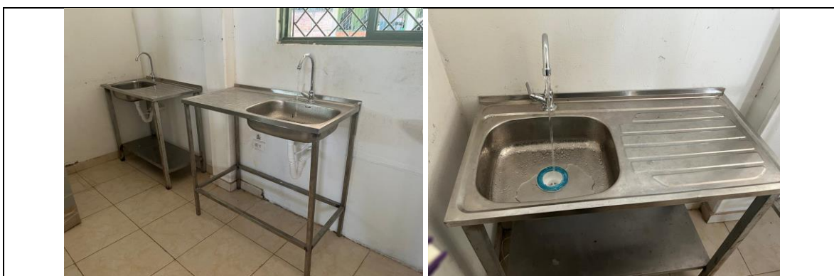
Reg. Fot. No. 27, Instalación De Grifería Para Lavaplatos Tipo Monocontrol
