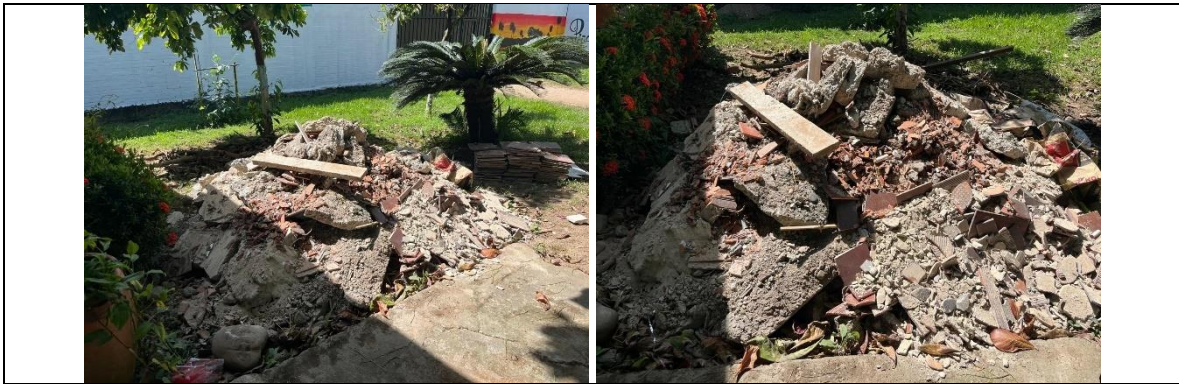
Reg. Fot. No. 18, Retiro de sobrantes, cargue, transporte y disposición final de escombros a sitio autorizado.
