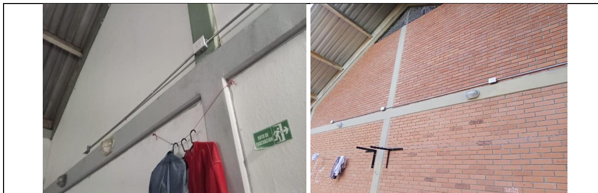
Reg. Fot. No 13, instalación de tubería unidad de 3 metros EMT 1/2"
