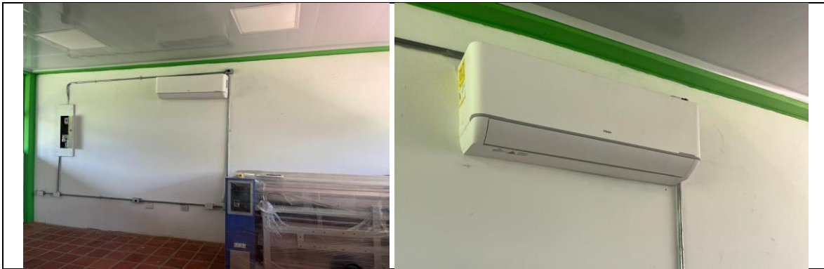
Reg. Fot. No. 11, instalación de aire acondicionado MINI SPLIT.
