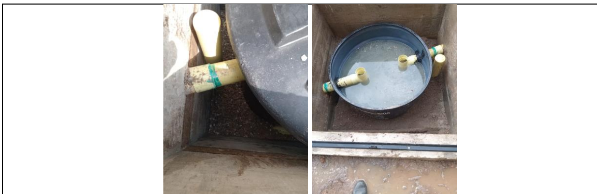
Reg. Fot. No. 2 , de instalación de base arena cemento en trampa de grasas
