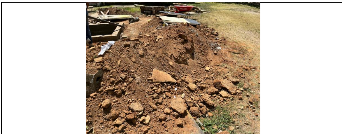
Reg. Fot. No. 01, Retiro de sobrantes, cargue, transporte y disposición final de escombros a sitio autorizado.
