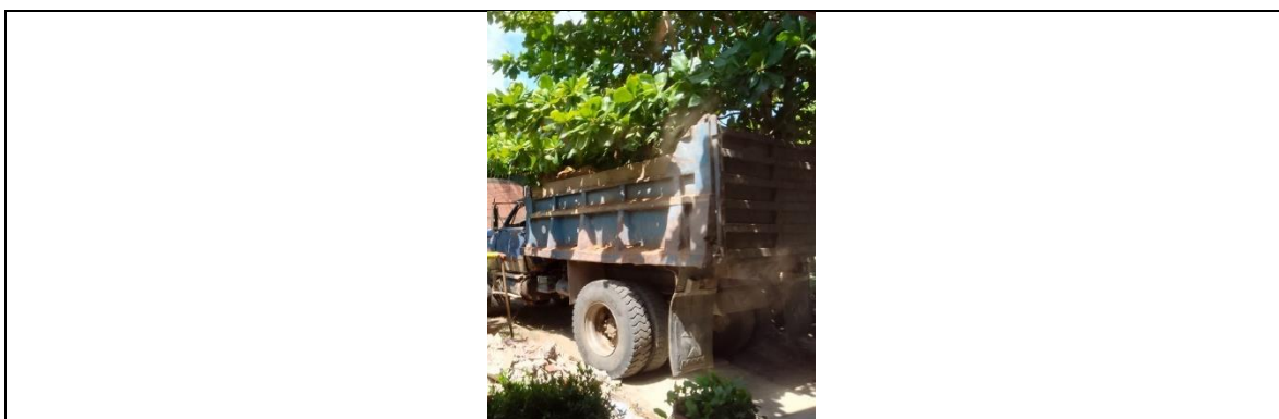
Reg. Fot. No. 11. Retiro de sobrantes, cargue, transporte y disposición final de escombros a sitio autorizado
