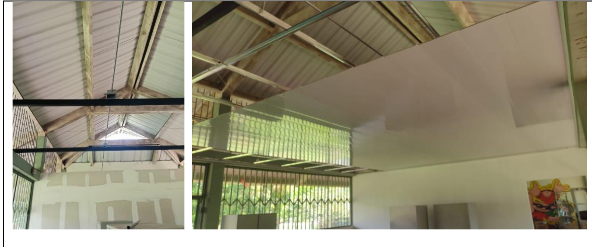
Reg. Fot. No. 04, instalación de cielo raso en pvc (incluye estructura y accesorios de fijación)
