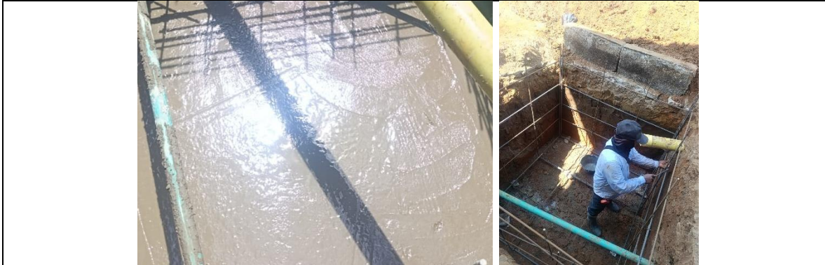
Reg. Fot. No. 05, Concreto 2000 psi
