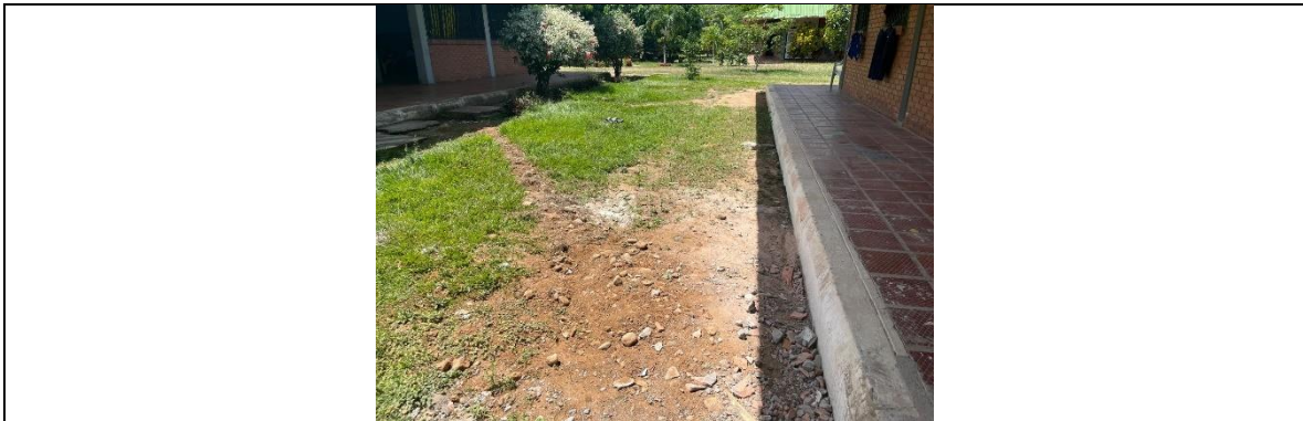
Reg. Fot. No. 19, Relleno con material seleccionado.
