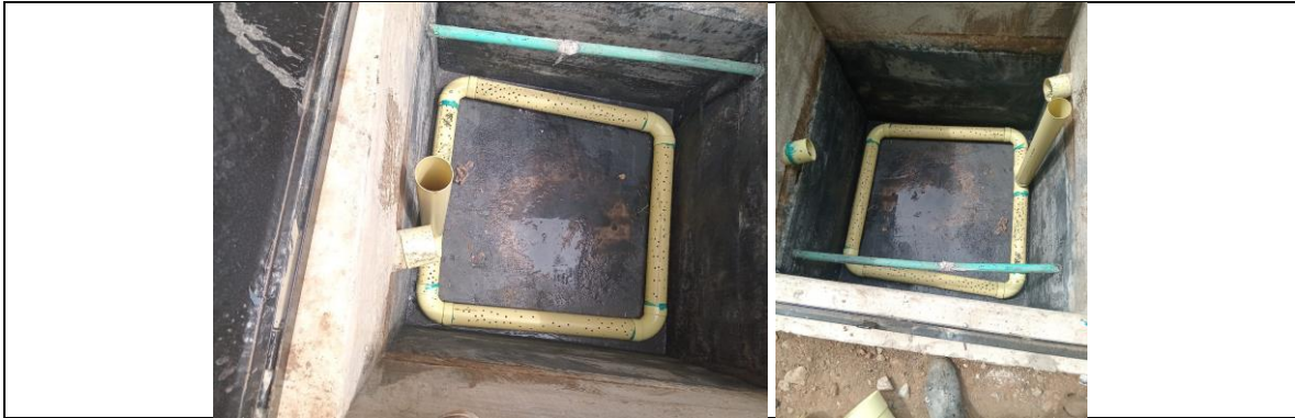
Reg. Fot. No. 3, instalación Red sanitaria pvc-s 4"
