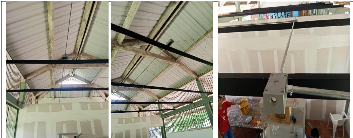
Reg. Fot. No. 06, instalación de Salida para iluminación en tubo conduit emt de 1/2"-3/4" y conductores.
