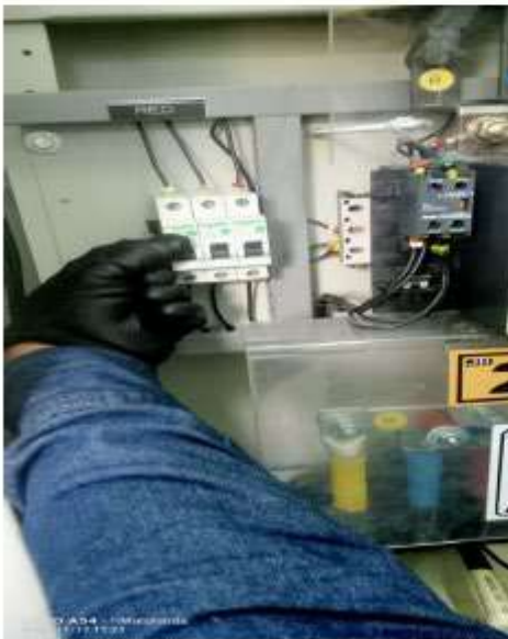
Pruebas de transferencia automática
