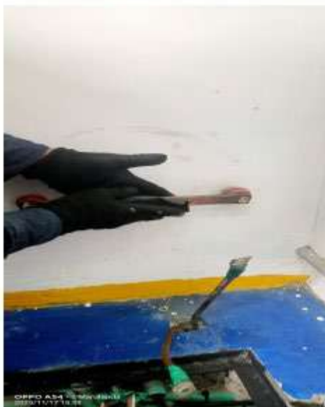
Suministro e instalación de línea a tierra para panel y chasis de tablero
