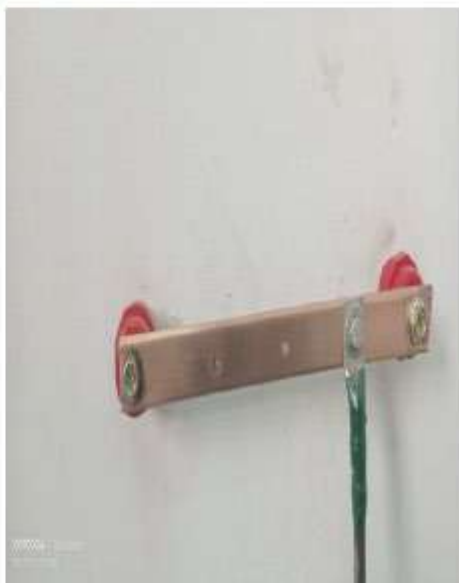
Suministro e instalación de línea a tierra para panel y chasis de tablero
