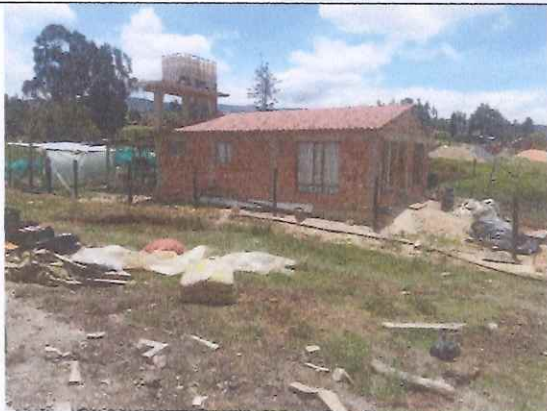
Se realizó visita de inspección ocular a las construcciones ubicadas en la vereda Centro, verificando que contaran con la respectiva licencia de construcción
