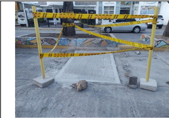
Fotografía 2. IMPLMETACION DEBIDAMENTE DE LA SEÑALIZACION
