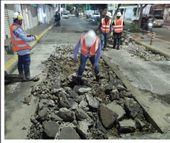
Fotografía 4. RECOLECCION DE ESCOMBROS
