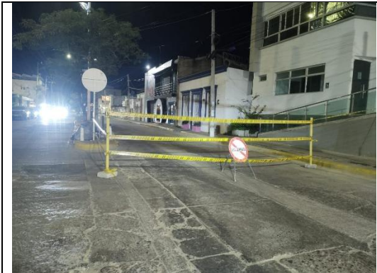
Fotografía 1. IMPLMETACION DEBIDAMENTE DE LA SEÑALIZACION
