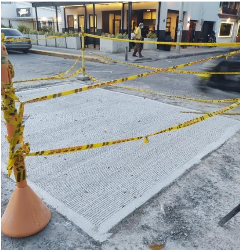
Fotografía 10. PLACA EN PROCESO DE FRAGUADA A 3 DIAS
