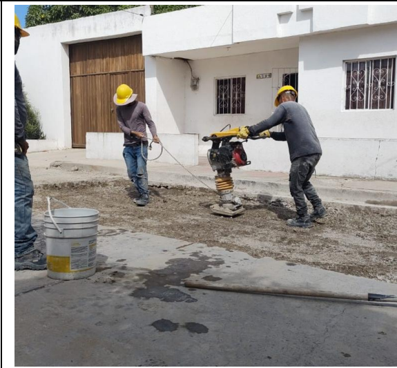
Fotografía 6. RELLENO Y COMPACTACION CON SUBBASE
