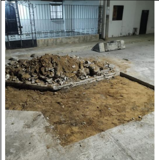
Fotografía 5. PREPARACION DEL TERRENO PARA APLICACIÓN DE SUBBASE
