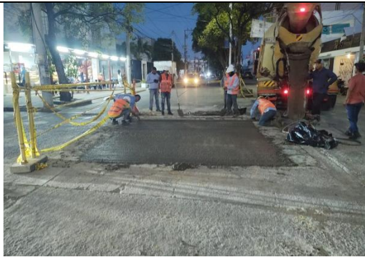
Fotografía 8. FUNDIDA DE PLACA
