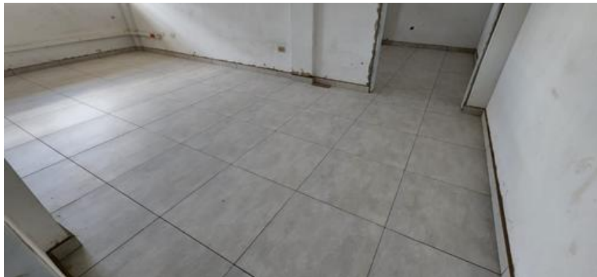
Ilustración 10. Reposición de cerámica de piso 60 x 60 cms
