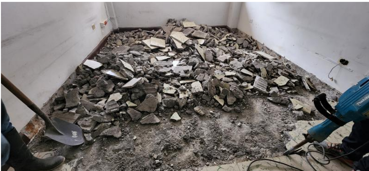
Ilustración 6. Demolición de Pisos en mal estado
