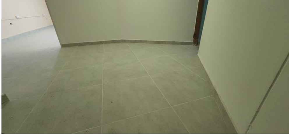
Ilustración 11. Reposición de estuco y vinilo
