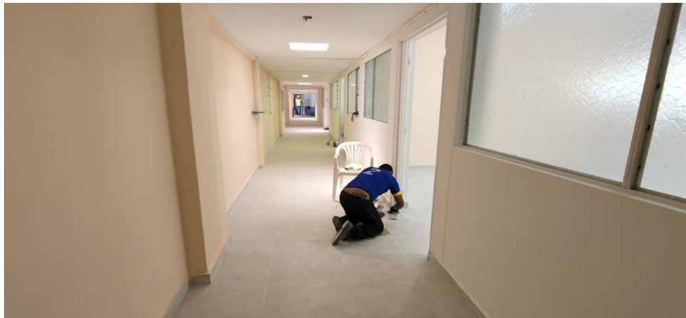
Ilustración 12. Reposición de estuco y vinilo
