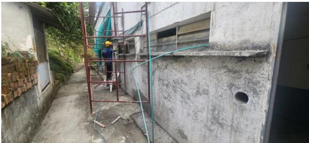
Ilustración 8. Rasqueteo y lijada de pintura en mal estado
