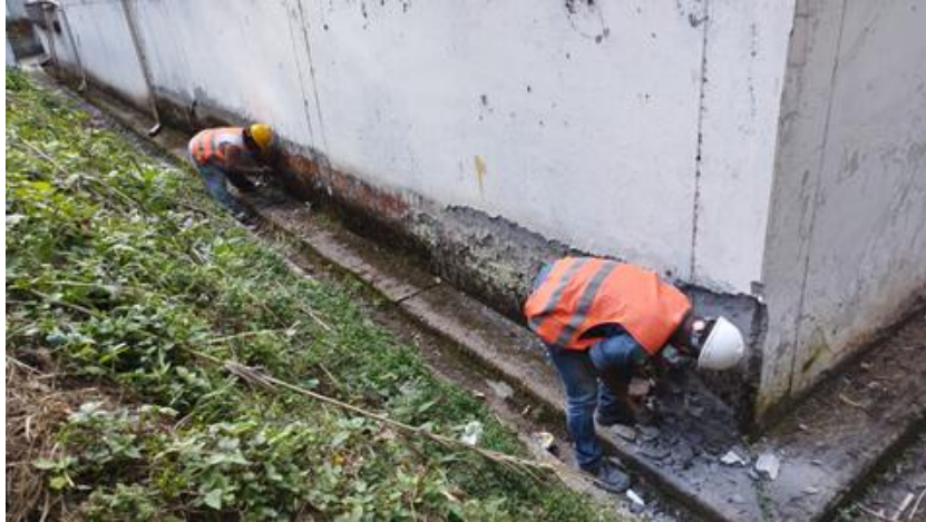
Ilustración 6. Demolición de repellos en mal estado
