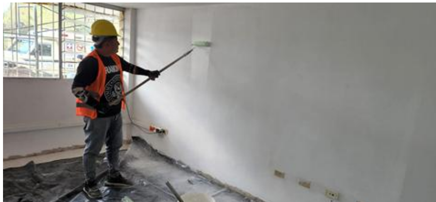
Ilustración 8. Pintura de muros interiores
