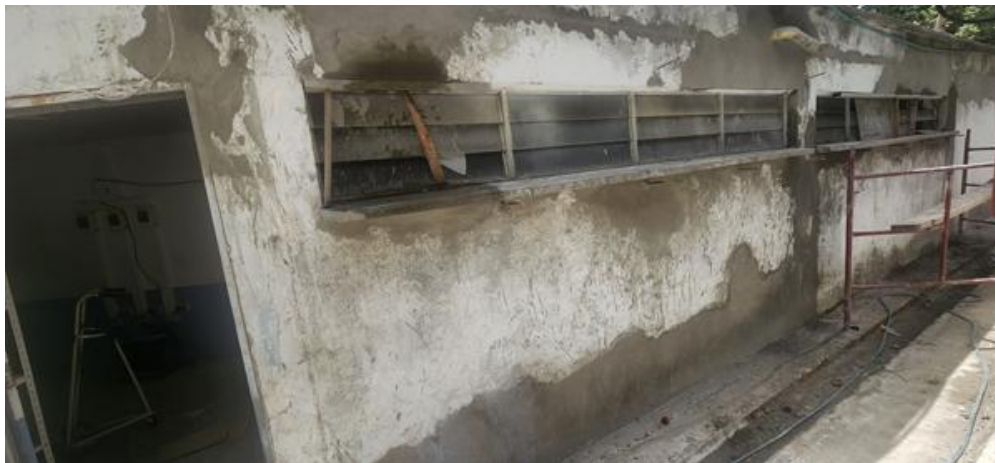
Ilustración 8. Rasqueteo y lijada de pintura en mal estado
