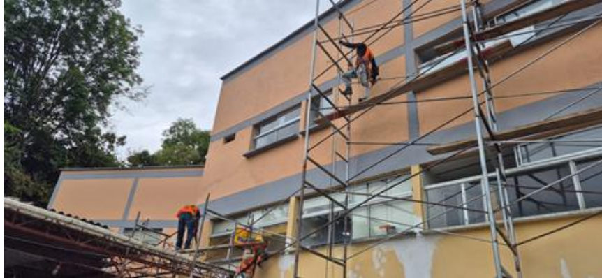
Ilustración 9. Pintura de fachadas exteriores
