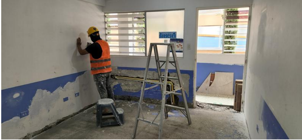
Ilustración 8. Reparación de alisado
