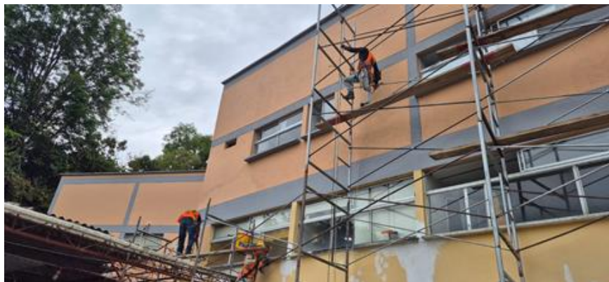
Ilustración 9. Pintura de fachadas exteriores
