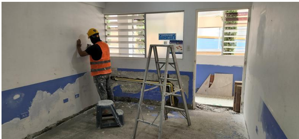
Ilustración 8. Reparación de alisado
