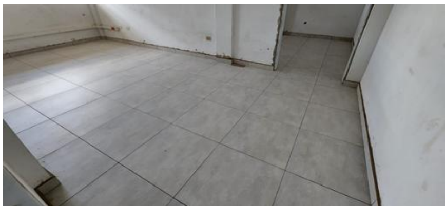
Ilustración 10. Reposición de cerámica de piso 60 x 60 cms
