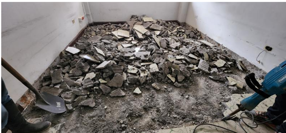
Ilustración 6. Demolición de Pisos en mal estado
