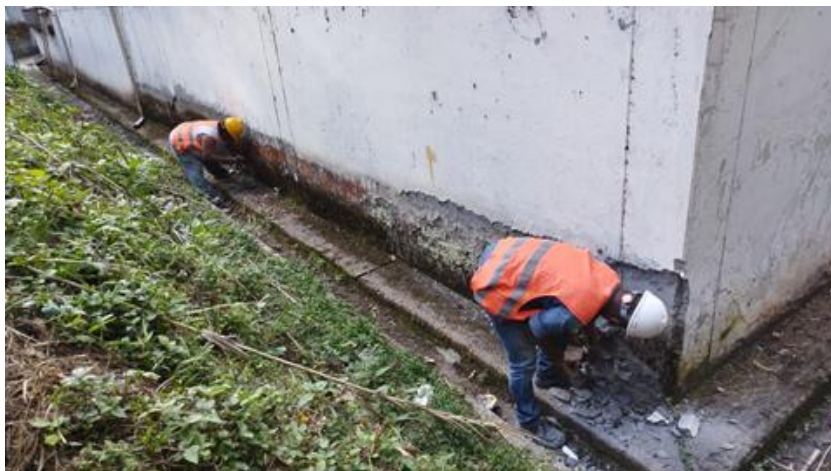
Ilustración 6. Demolición de repellos en mal estado
