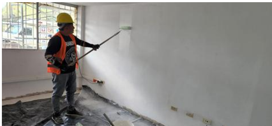
Ilustración 8. Pintura de muros interiores
