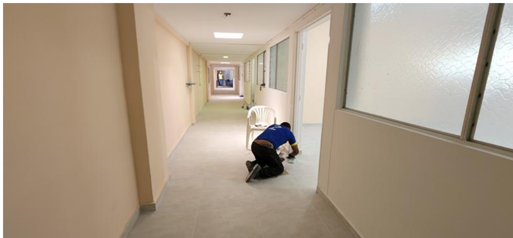
Ilustración 12. Reposición de estuco y vinilo
