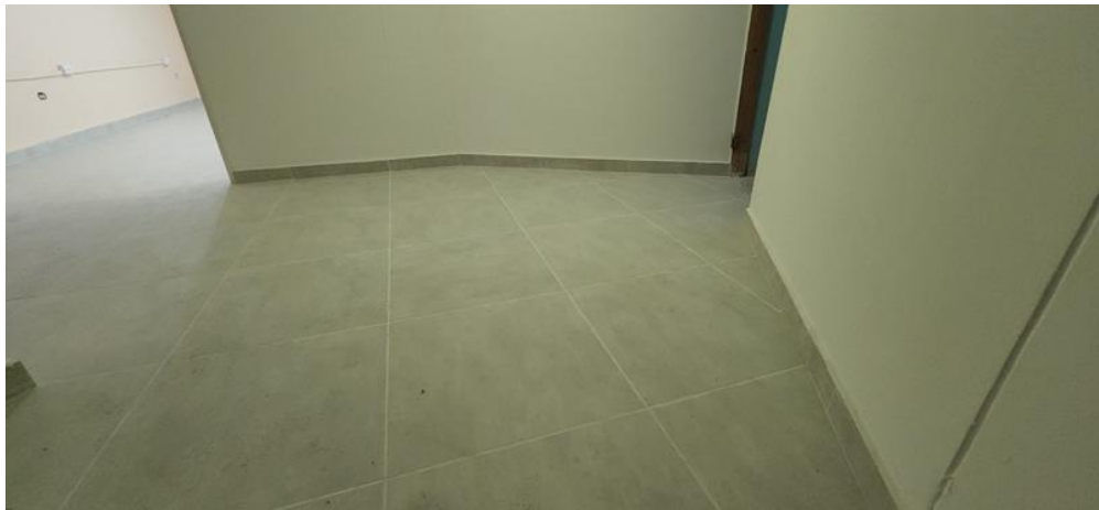
Ilustración 11. Reposición de estuco y vinilo
