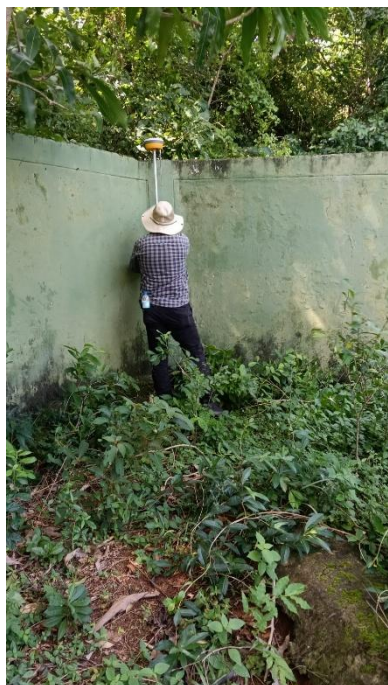
Ilustración 8-9 Levantamiento topográfico de referencias y detalles muros perimetrales predio Orange Hill.
