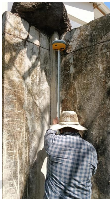
Ilustración 8-9 Levantamiento topográfico de referencias y detalles muros perimetrales predio Orange Hill.
