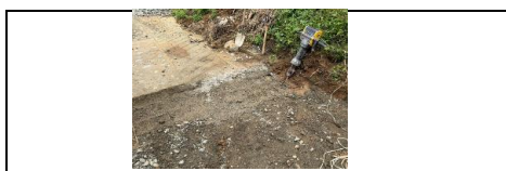
DEMOLICION DE RAMPA PARA ACCESO A PLACAHUELLA
