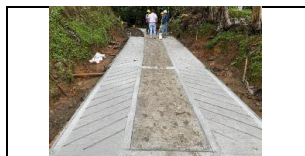
CONSTRUCCION FRANJAS CENTRALES
