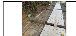
CICLOPEO Y REFUERZO DE VIGAS Y CUNETAS
