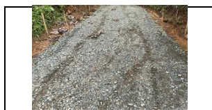
INSTALACION DE SUBBASE
