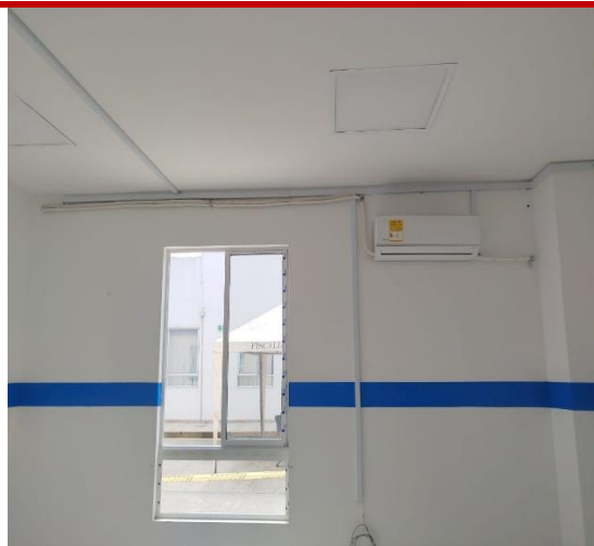
8,3: SUMINISTRO E INSTALACIÓN PANEL LED SQ CUADRADO 60x60 40w
