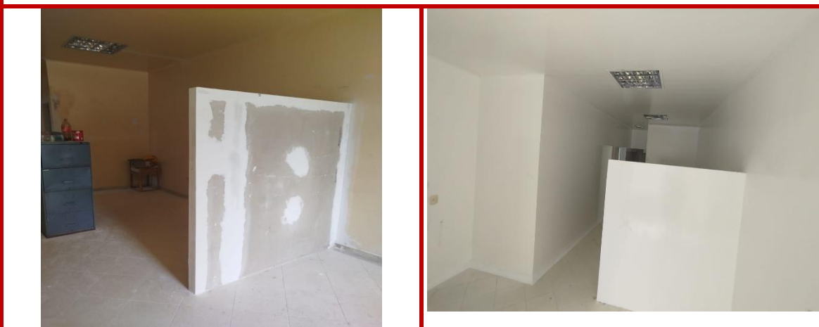
NP 5: SUMINISTRO E INSTALACIÓN FLANCHE EN LÁMINA E=0.25M
