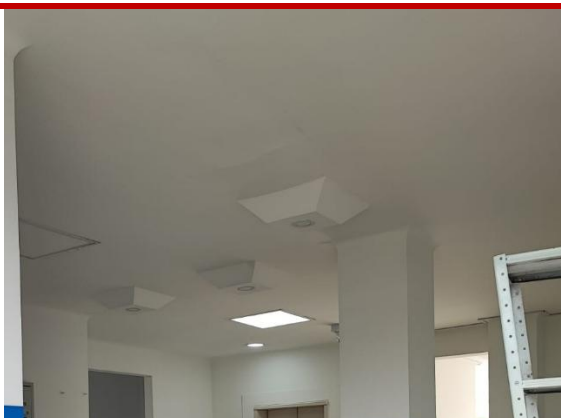
NP 19: SUMINISTRO E INSTALACIÓN PANEL LED SQ CUADRADO 60x30 40w
