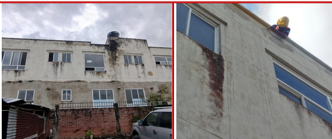
NP 21: LAVADA DE FACHADA CON ÁCIDO MURIÁTICO Y/O NÍTRICO
