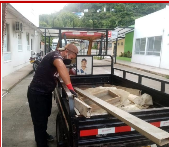
1.5: DESMONTE DE APARATO SANITARIO, LAVAMANOS Y/O LAVAPLATOS INC. CARGUE TRANSPORTE
