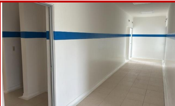
NP 11: SUMINISTRO E INSTALACIÓN DE PINTURA EPÓXICA PARA MUROS A DOS MANOS
