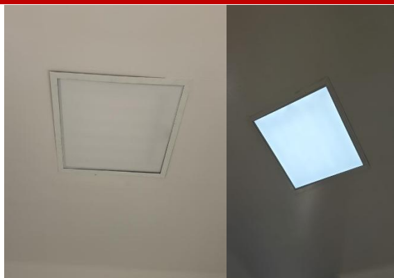
8,3: SUMINISTRO E INSTALACIÓN PANEL LED SQ CUADRADO 60x60 40w
