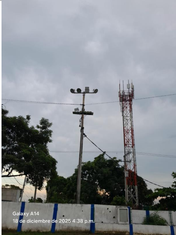
Foto 1. Vista general de poste y conjunto de luminarias: Reflector 1. (18/12/2025).
