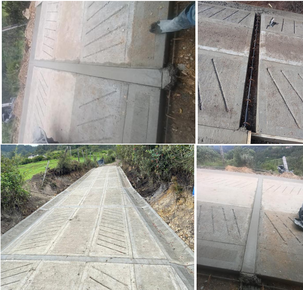
Ilustración No. 7 – Fundida de concreto clase D ( f'_c = 3000 psi) para vigas de amarre Fuente: elaboración Propia
