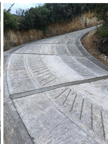
Ilustración No. 6 – Fundida de concreto clase D f'c = 3000 psi (bases)
