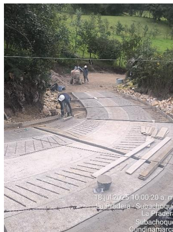
Ilustración No. 6 – Fundida de concreto clase D f'c = 3000 psi (bases)
