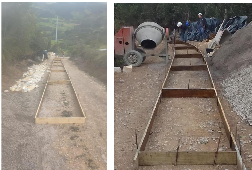
Ilustración No. 2 – Instalación de formaletas Fuente: elaboración Propia
