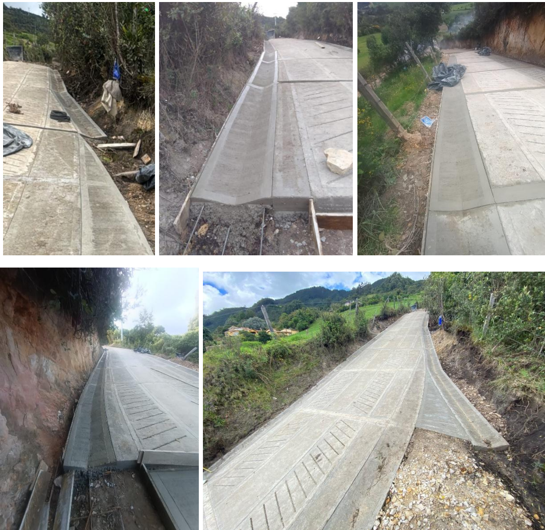
Ilustración No. 8 –Construcción de cunetas laterales y descoles Fuente: elaboración Propia
