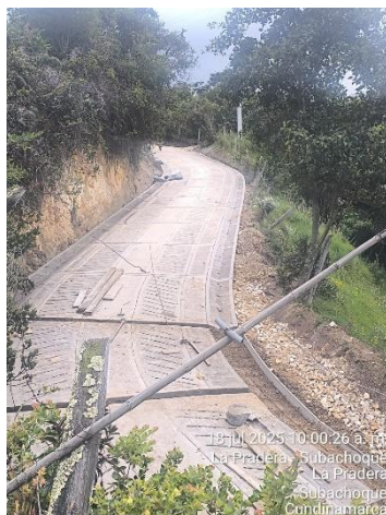
Ilustración No. 6 – Fundida de concreto clase D f'c = 3000 psi (bases)
