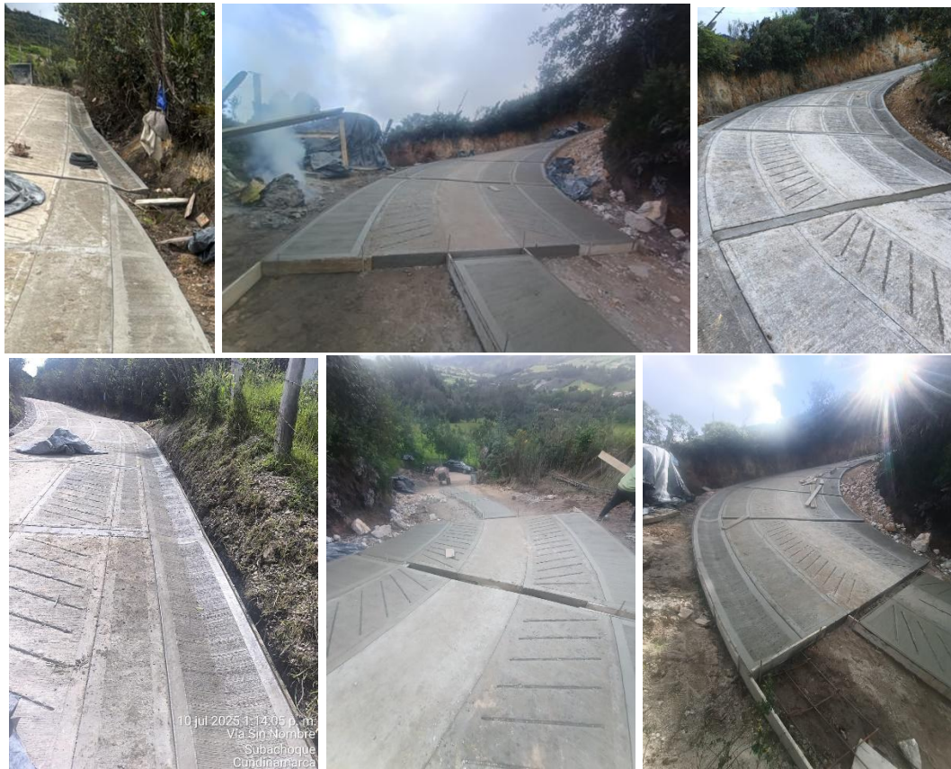
Ilustración No. 4 – Conformación de sobreanchos
