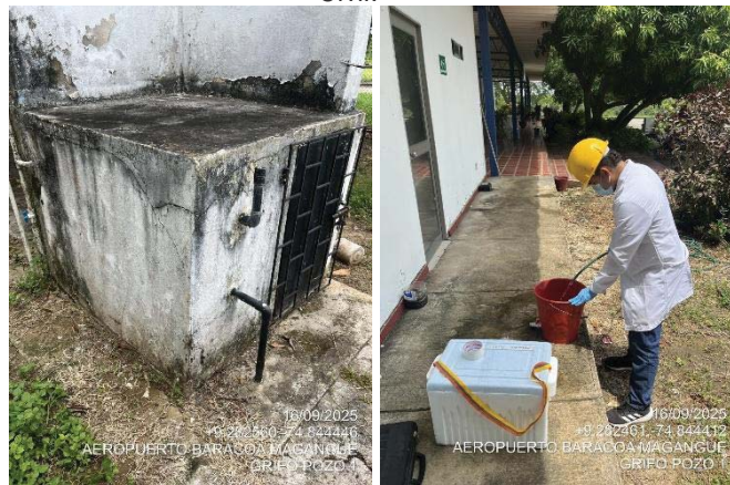
Imagen 2. Pozo 1 del Aeropuerto Baracoa de Magangué - Unidad Administrativa Especial de Aeronáutica Civil.
