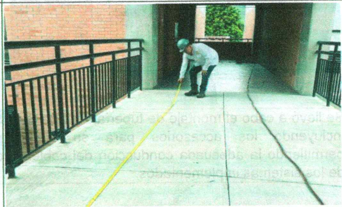
Se realiza demarcación de tubería EMT para la instalación redes.
