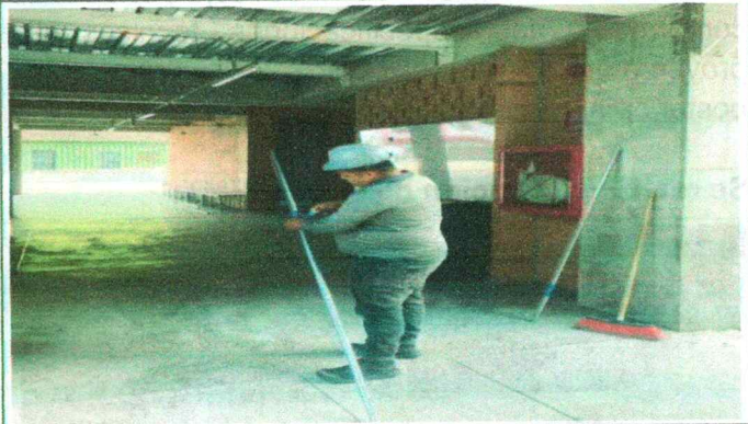
Se realiza demarcación de tubería EMT para la instalación redes.
