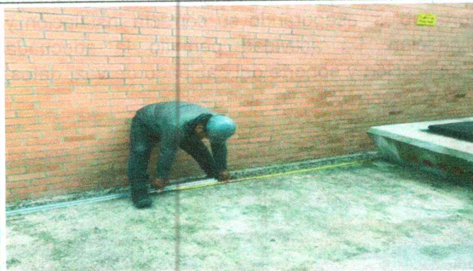
Se continua con el replanteo de metros lineales de tubería emt a instalar.
