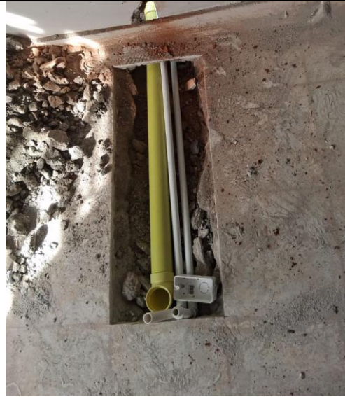
Instalación de tubería 2"
