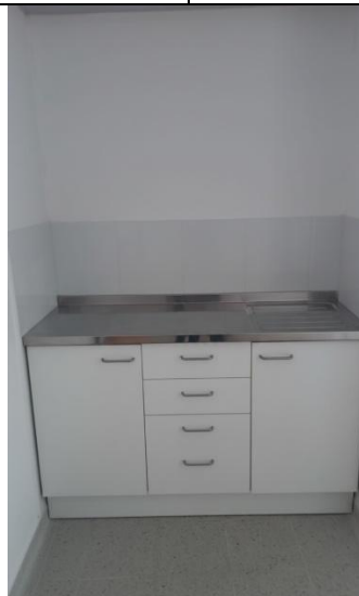
Instalación de mueble en rh sobre meson
