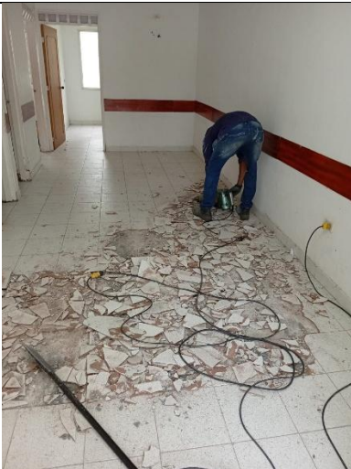
Demolición de enchape
