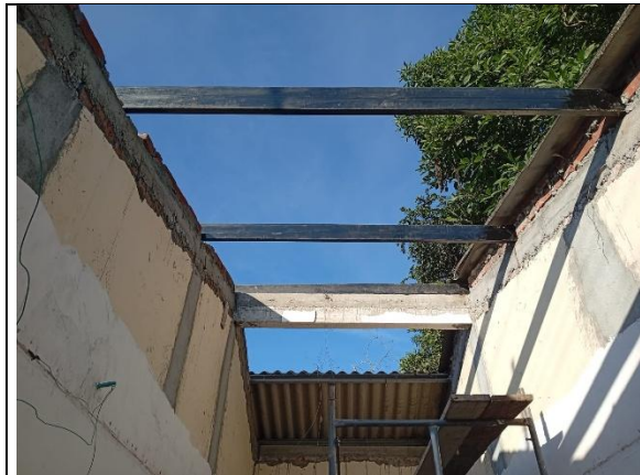
Instalación de estructura metálica para cubierta
