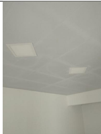
Instalación de cielo falso
