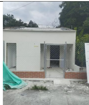
Cerramiento completo en malla eslabonada
