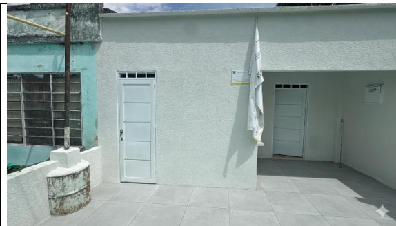
Instalación de porcelanato
