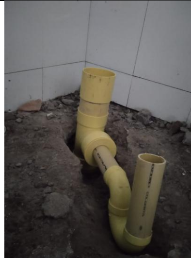
Instalación de tubería 4"
