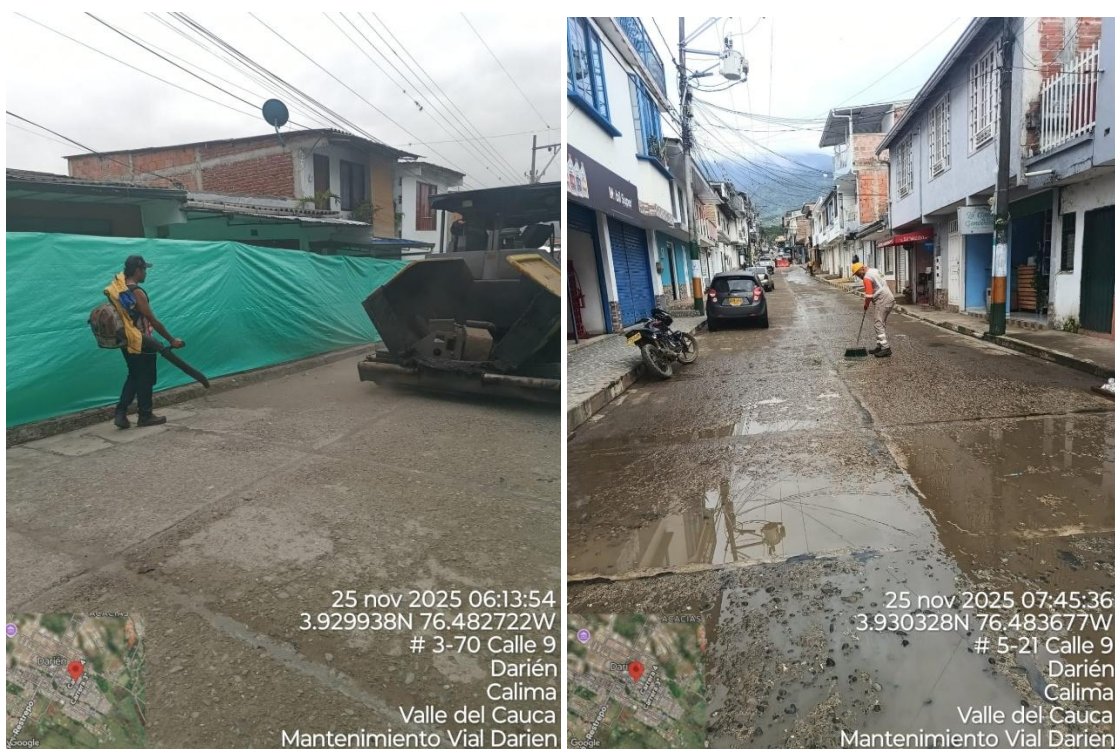
Ilustración 15 Limpieza de vías con sopleteo y manuales - Tramo 1 Calle 9 entre K3 y K6
