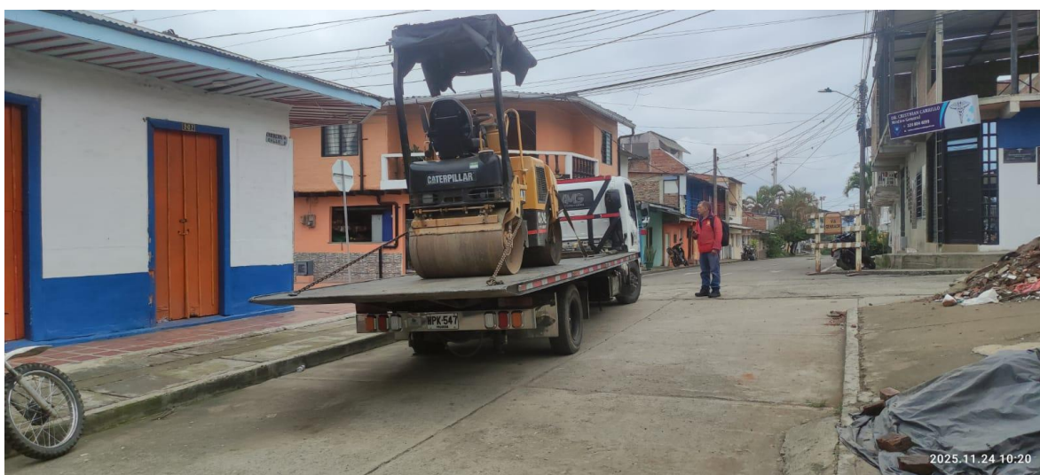
Ilustración 14 Transporte de equipos y maquinaria para la instalación de asfalto
