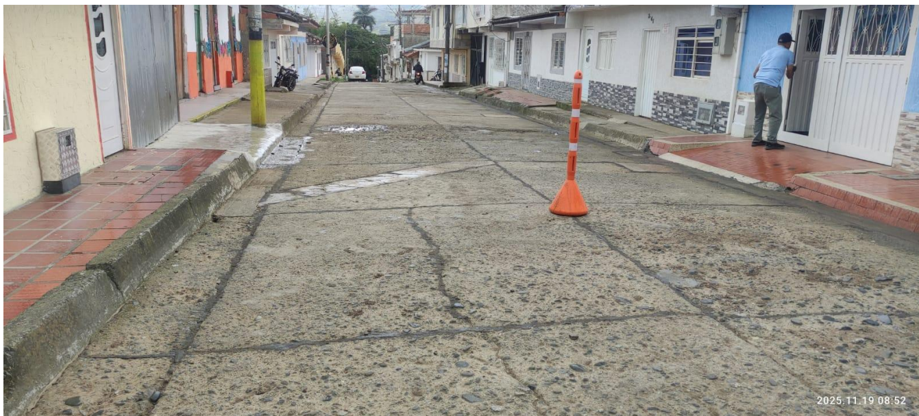
Ilustración 9 Limpieza con sopladora y sello de grietas en pavimento de concreto rígido con emulsión asfáltica bituminosa + arena – Tramo 2 Calle 10 entre K3 y K6
