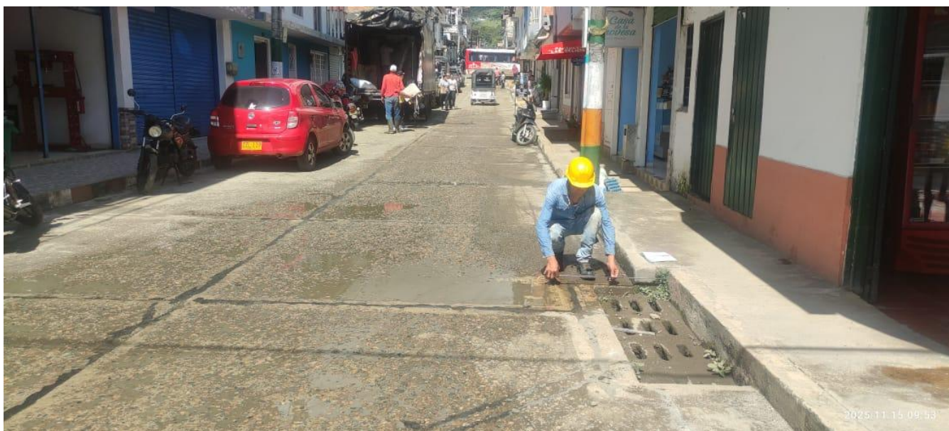
Ilustración 4 Inventario y toma de medidas de sumideros para formaleta de elaboración de tapas – Tramo 1 Calle 9 entre K3 y K6
