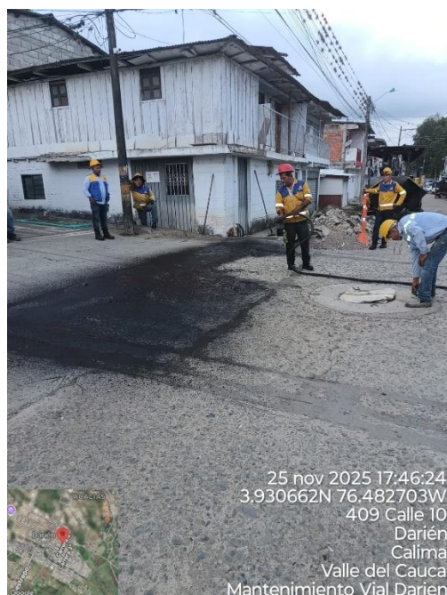
Ilustración 20 Riego y compactación de liga y mezcla asfáltica para renivelación previa, imprimación con emulsión e instalación de geomalla - tramo 2 calle 10 entre K3 y K6
