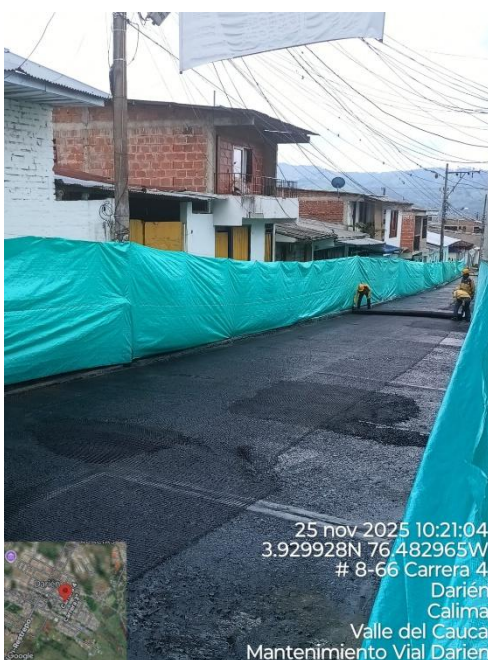
Ilustración 17 Imprimación con emulsión e instalación de geomalla - tramo 1 calle 9 entre K3 y K6
