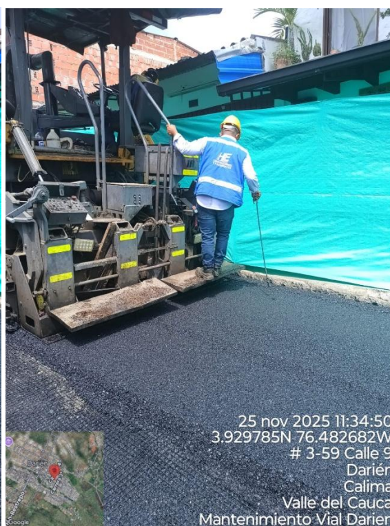
Ilustración 18 Instalación de carpeta asfáltica - tramo 1 Calle 9 entre K3 y K6
