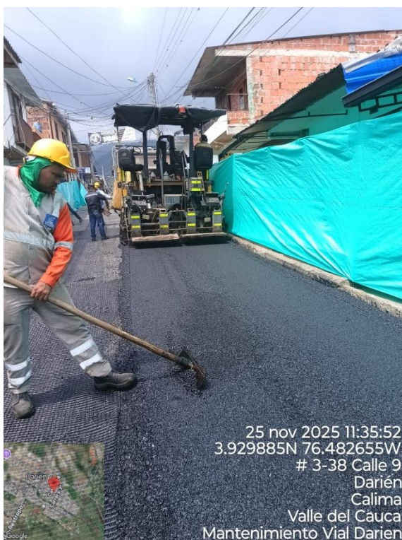
Ilustración 18 Instalación de carpeta asfáltica - tramo 1 Calle 9 entre K3 y K6
