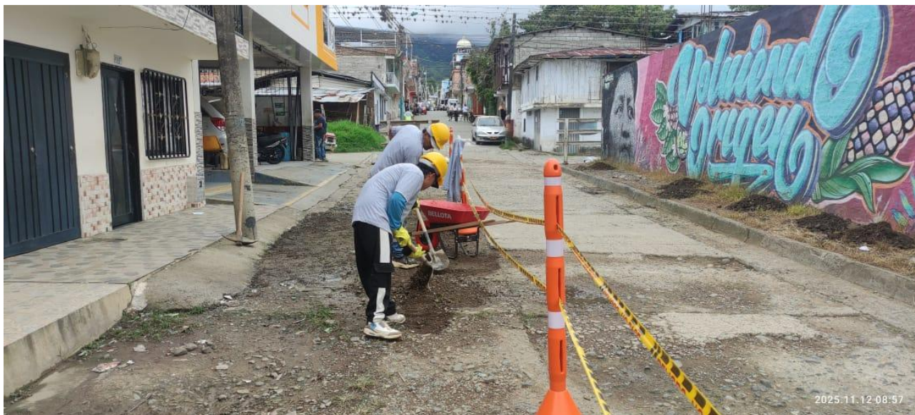
Ilustración 5 Excavaciones manuales retirando escombros, rellenos y material no deseado – Tramo 2 Calle 10 entre K3 y K6
