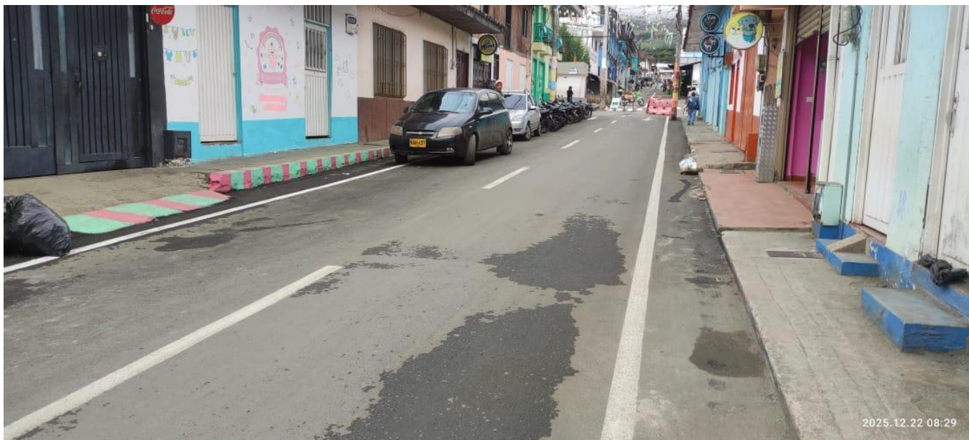
Ilustración 29 Vías repavimentadas y en pleno funcionamiento y puesta en servicio a la comunidad
