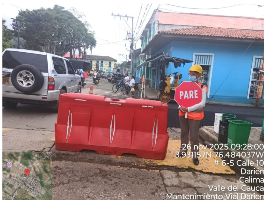
Ilustración 23 Control de tráfico con paletero - Tramo 2 Calle 10 entre K3 y K6
