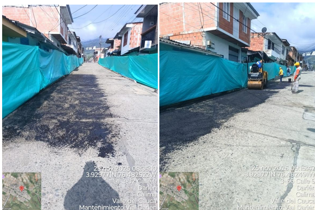
Ilustración 16 Riego y compactación de liga y mezcla asfáltica para renivelación previa – tramo 1 calle 9 entre K3 y K6
