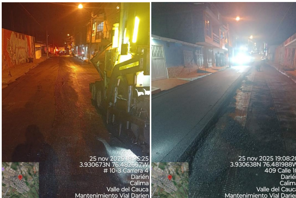
Ilustración 21 Instalación de carpeta asfáltica - tramo 2 Calle 10 entre K3 y K6
