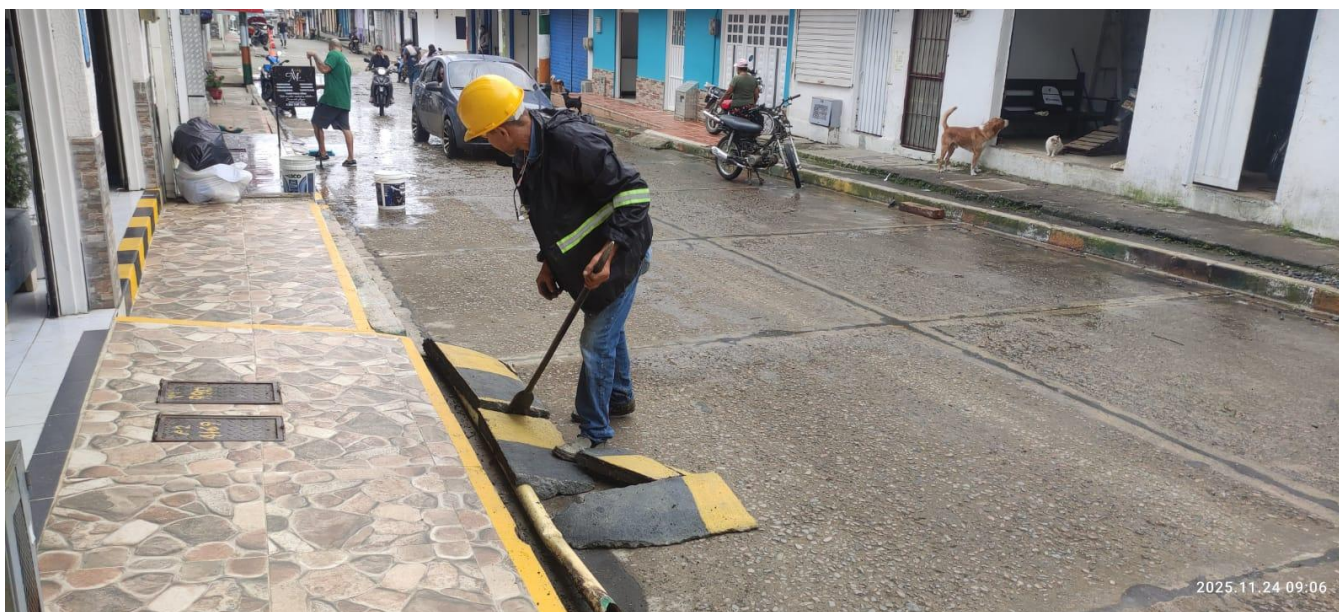
Ilustración 12 Retiro de rampas de concreto existentes en locales y viviendas vecinas
