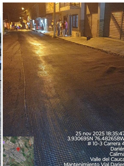
Ilustración 20 Riego y compactación de liga y mezcla asfáltica para renivelación previa, imprimación con emulsión e instalación de geomalla - tramo 2 calle 10 entre K3 y K6
