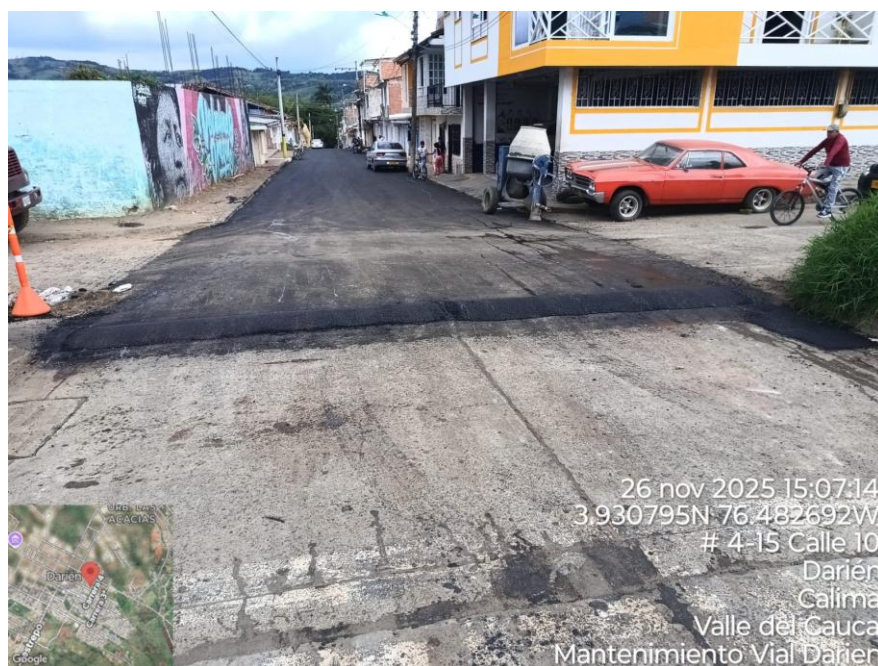
Ilustración 26 Construcción reductor de velocidad – Tramo 2 Calle 10 entre K3 y K4
