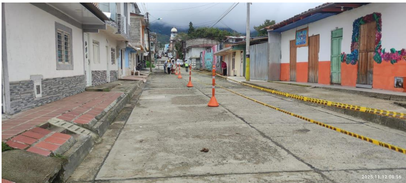
Ilustración 1 Señalización y demarcaciones de zonas de trabajo - Tramo 2 Calle 10 entre K3 y K6
