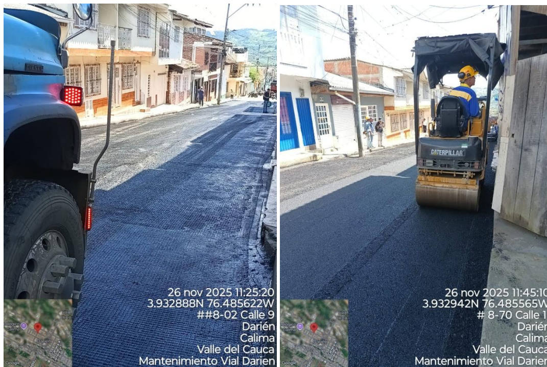
Ilustración 22 Instalación de geomalla, imprimación e instalación de carpeta - Tramo 3 Calle 11 entre K8 y K9
