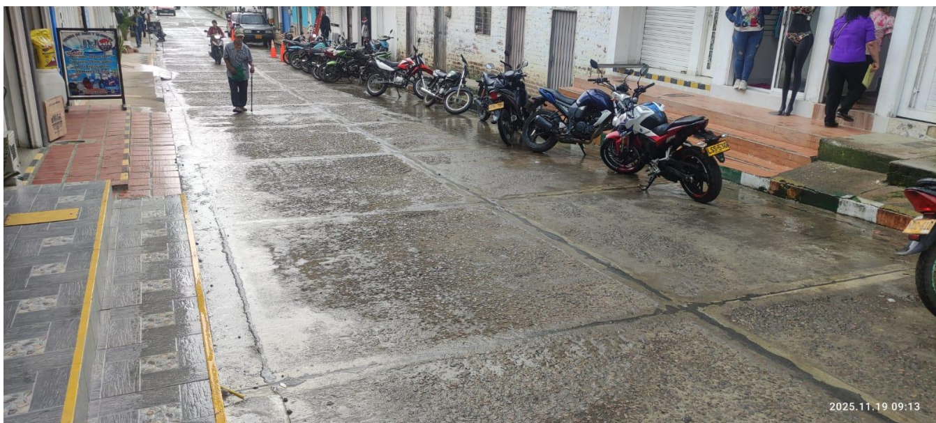
Ilustración 10 Limpieza con sopladora y sello de grietas en pavimento de concreto rígido con emulsión asfáltica bituminosa + arena – Tramo 3 Calle 11 entre K8 y K9
