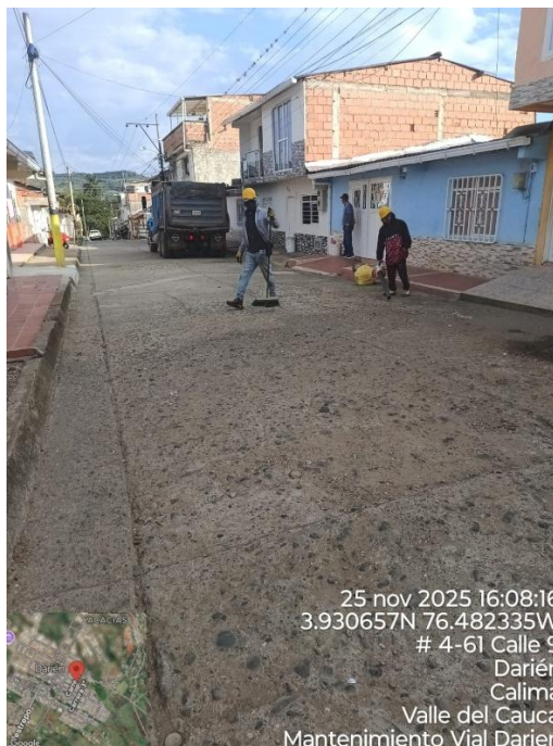
Ilustración 19 Transporte de mezcla y limpieza de vías con sopleteo y manuales - Tramo 2 Calle 10 entre K3 y K6
