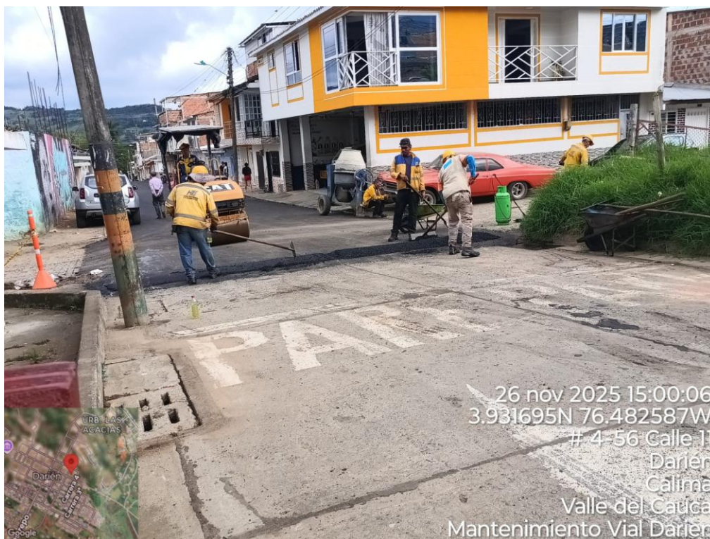
Ilustración 25 Construcción reductor de velocidad – Tramo 2 Calle 10 entre K3 y K4
