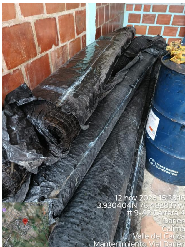
Ilustración 13 Geomalla en fibra de vidrio tipo fortgrid asphalt. En almacén de obra.
