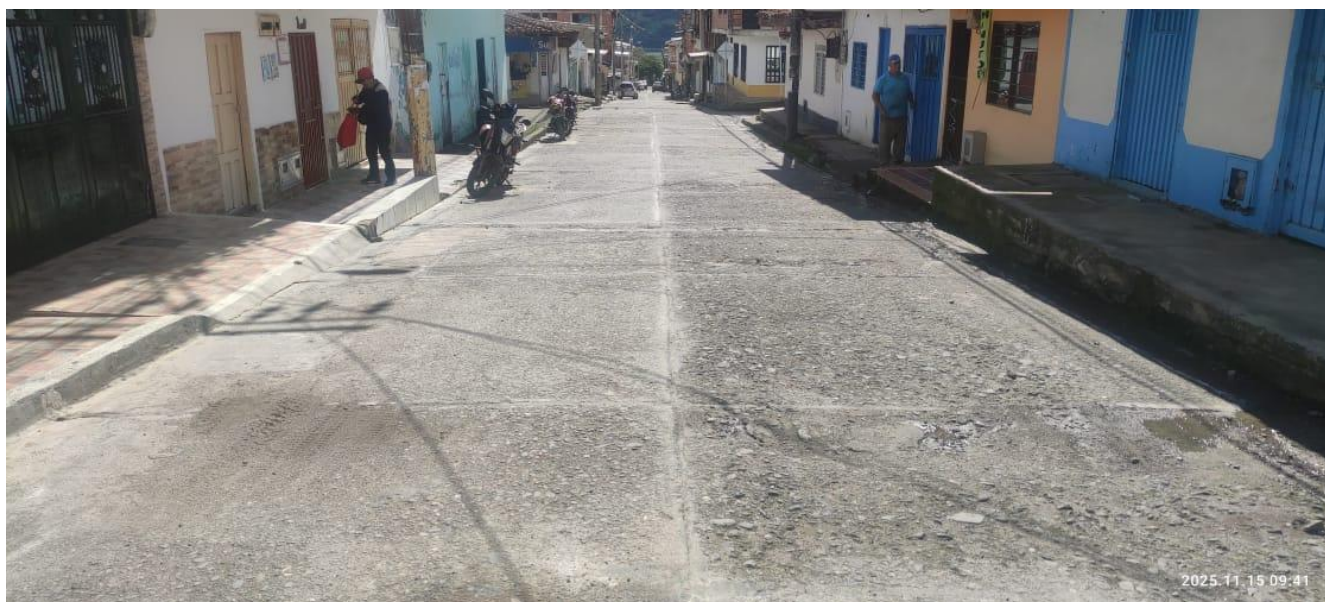
Ilustración 8 Limpieza con sopladora y sello de grietas en pavimento de concreto rígido con emulsión asfáltica bituminosa + arena – Tramo 1 Calle 9 entre K3 y K6
