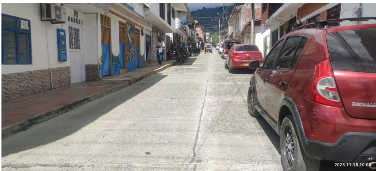
Ilustración 6 Limpieza con sopladora y sello de grietas en pavimento de concreto rígido con emulsión asfáltica bituminosa + arena – Tramo 3 Calle 11 entre K8 y K9
