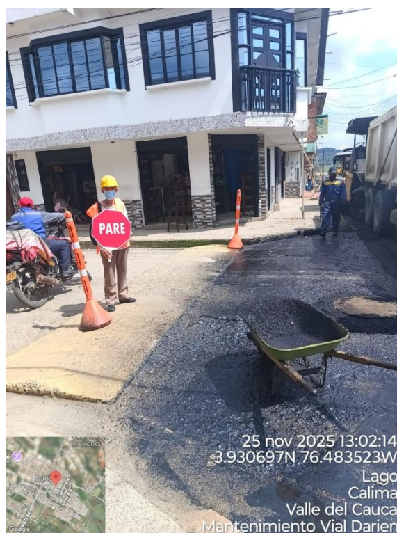
Ilustración 24 Control de tráfico con paletero - Tramo 2 Calle 10 entre K3 y K6
