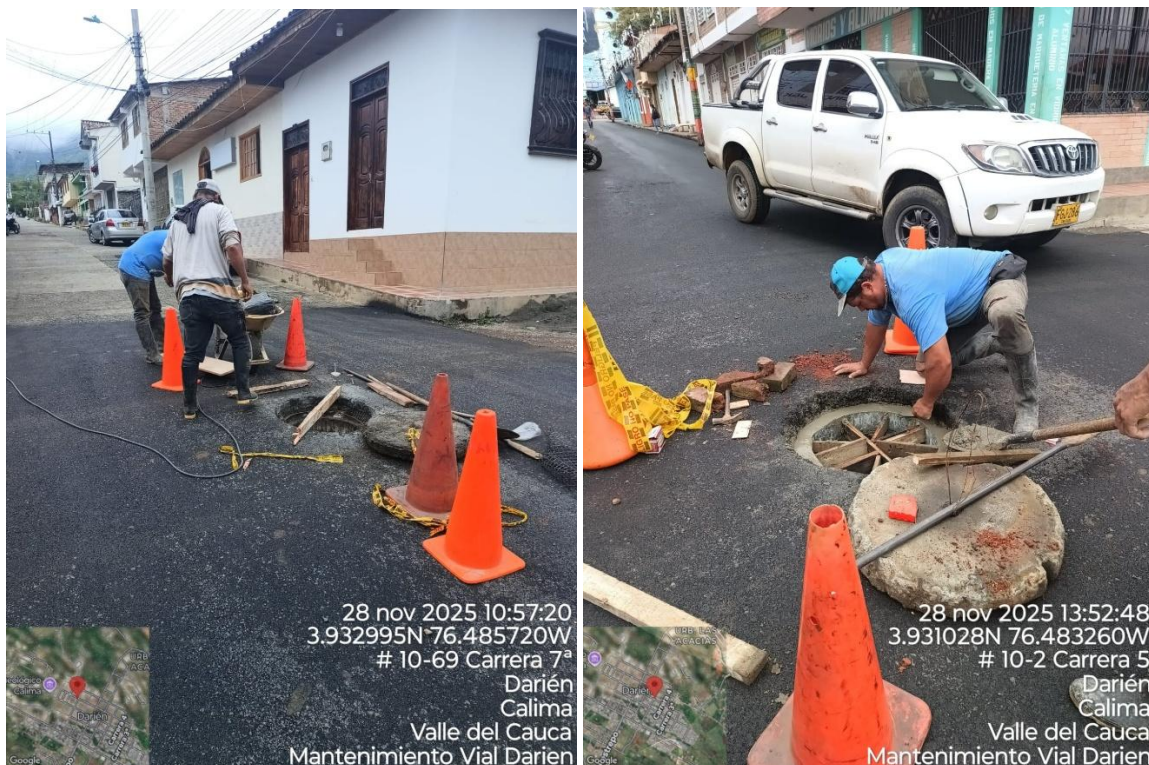
Ilustración 27 Construcción realces de cámaras de inspección – Tramo 3 Calle 11 entre K8 y K9
