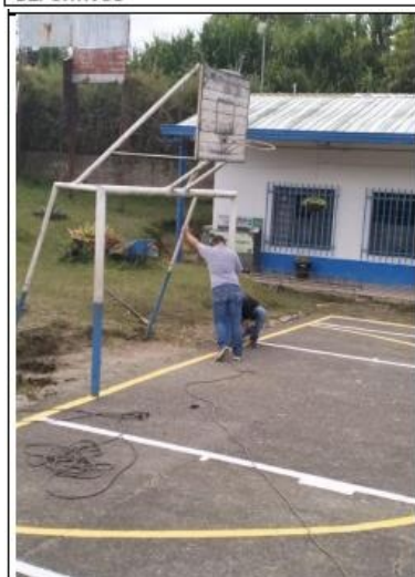
FIGURA 13. RETIRO DE PORTERIAS INTEGRADAS EXISTENTES
