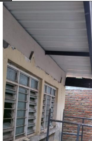
Instalación de PANEL BOARD
