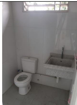
Instalación de sanitario y lavatraperero
