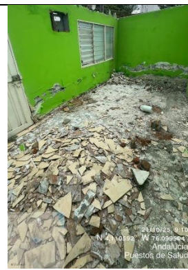
Demolición de baldosa existente
