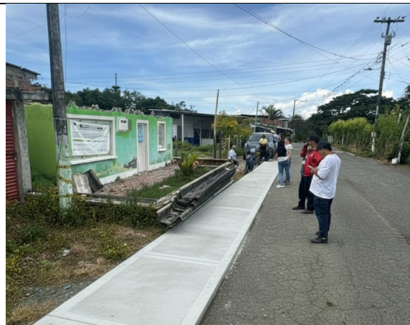
Anden en concreto
