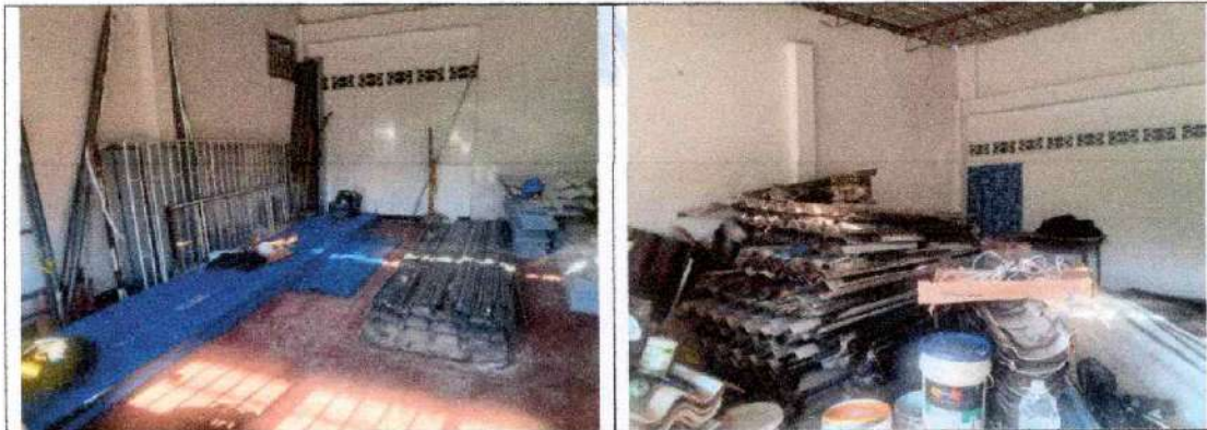
Ilustración 8. Acopio de material y bodega de obra
