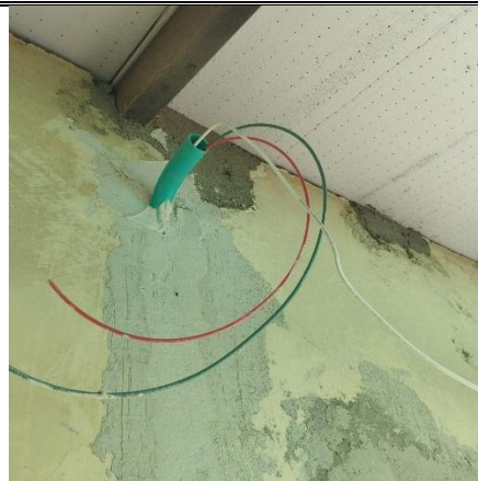
Cableado, tuberías, regatas y resanes
