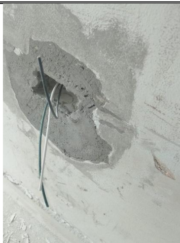
Cableado, tuberías, regatas y resanes
