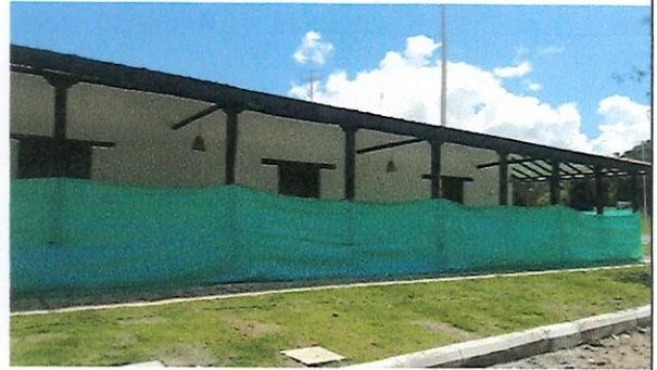
Fotografía 6: Instalación de señalización
