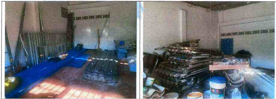
Ilustración 8. Acopio de material y bodega de obra
