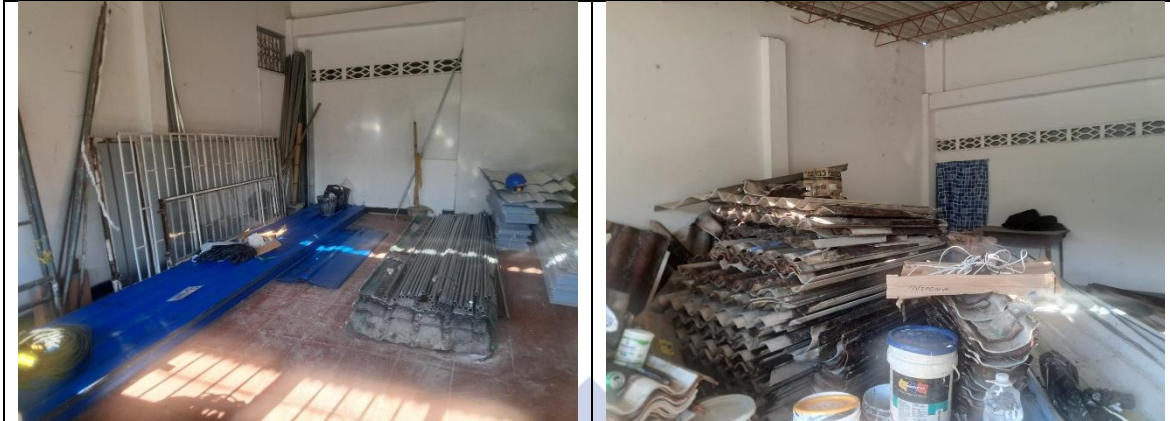
Ilustración 8. Acopio de material y bodega de obra
