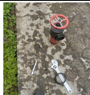
RETIRO DE VÁLVULAS ANGULARES DE CABEZAL
