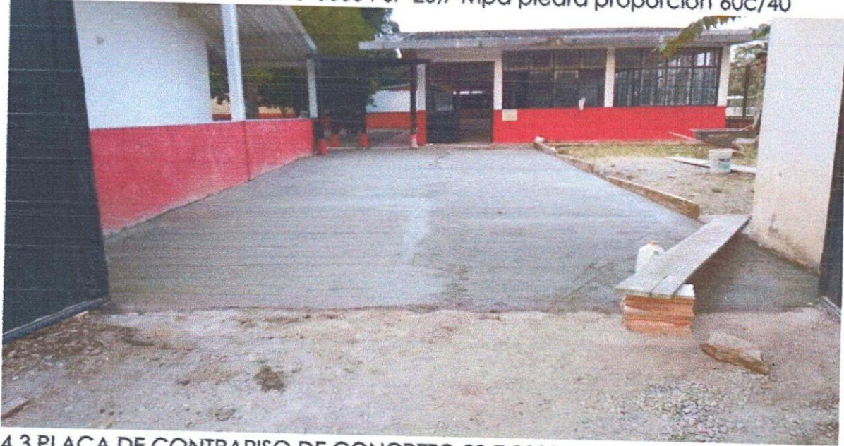
4,3 PLACA DE CONTRAPISO DE CONCRETO 20,7 3000 PSI MEZCLA EN OBRA
