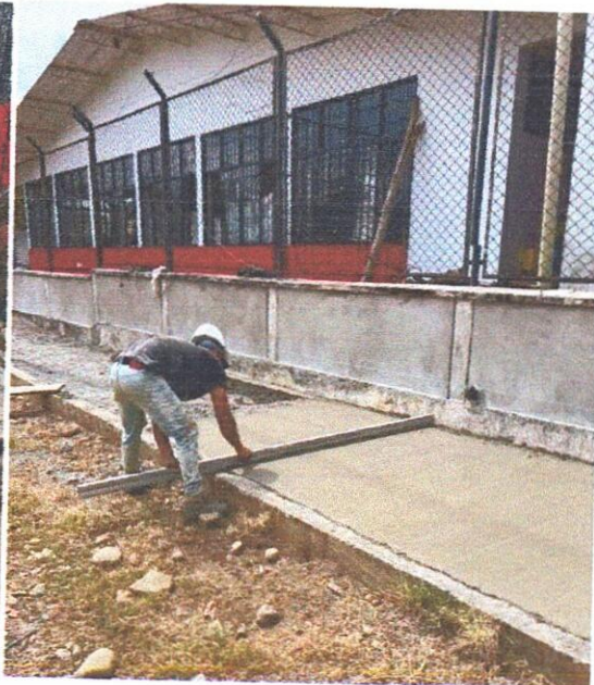
4,3 PLACA DE CONTRAPISO DE CONCRETO 20,7 3000 PSI MEZCLA EN OBRA
