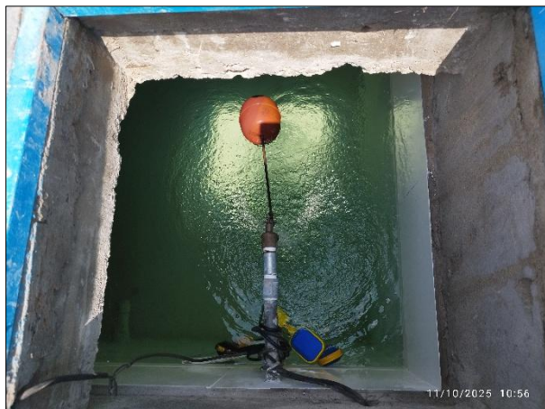
Imagen 3. Lamina de agua, tanque de almacenamiento de agua con sensor de nivel
