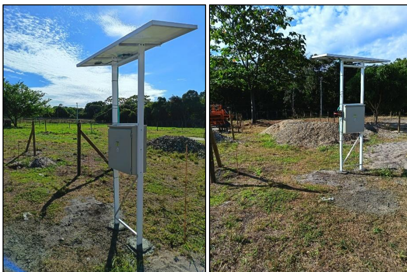
Figura 3. Evidencia fotográfica de la instalación del sistema solar
