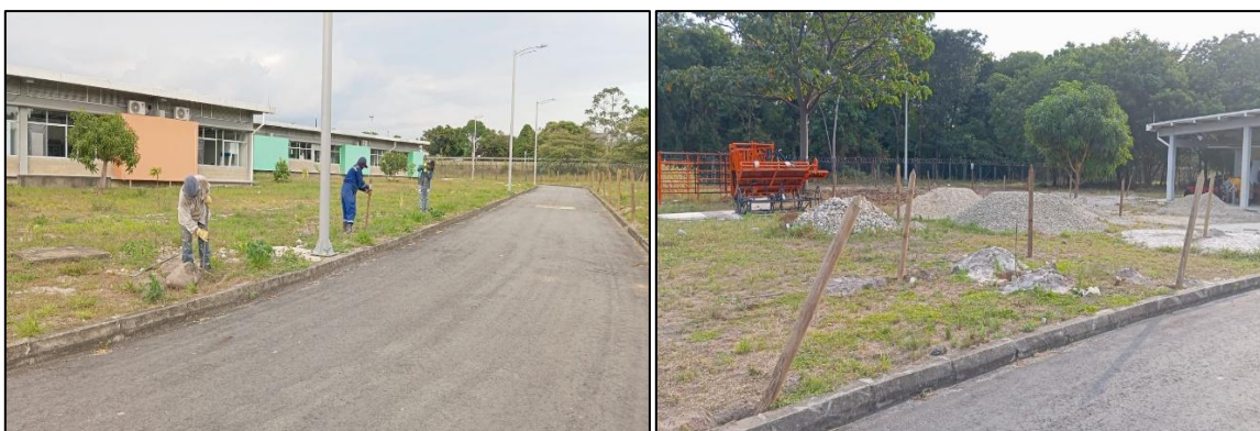
Figura 2. Evidencia fotográfica de la instalación del beneficio
