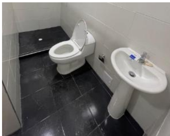
A4-8.25. Suministro e instalación de piso cerámico tráfico moderado
