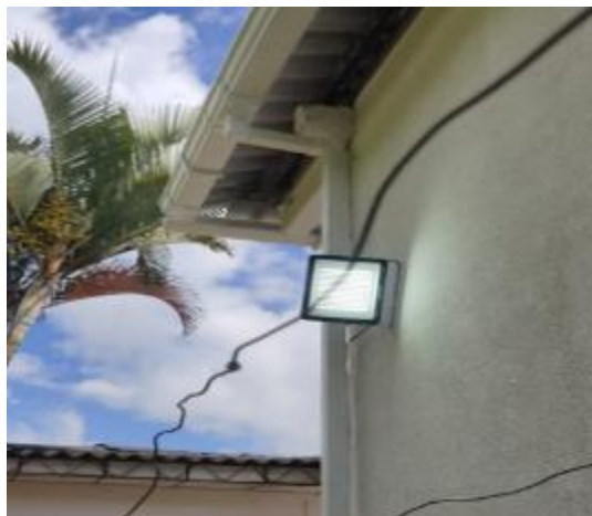
Suministro e instalación de lámpara reflector LED 200W
