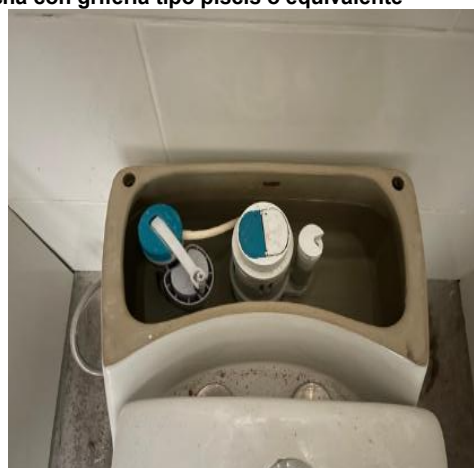
A4-3.78. Suministro e instalación de Grifería sanitaria hidrostática doble descarga
