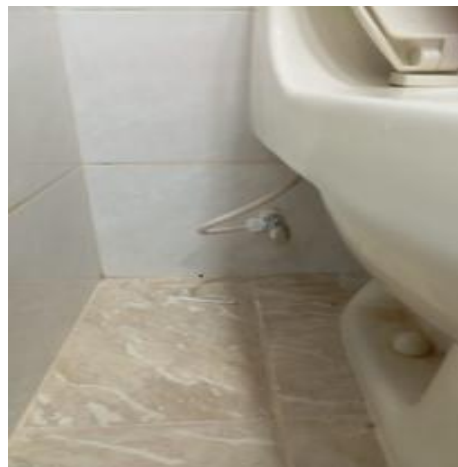
Reposición e instalación de Válvula regulación 1/2 sanitario cromo
