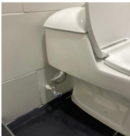
A4-3.81. Reposición e instalación de Válvula regulación 1/2 sanitario cromo
