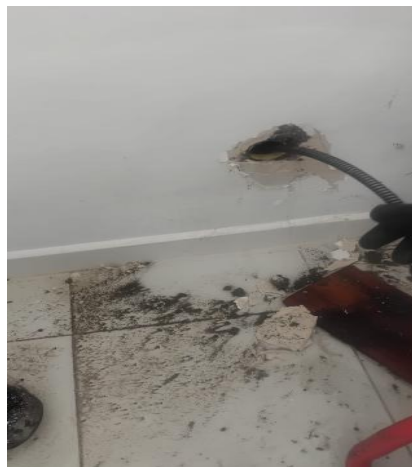
A2-3.93. Mantenimiento y limpieza interna de red sanitaria con sonda barrenadora metálica eléctrica para aparatos sanitarios
