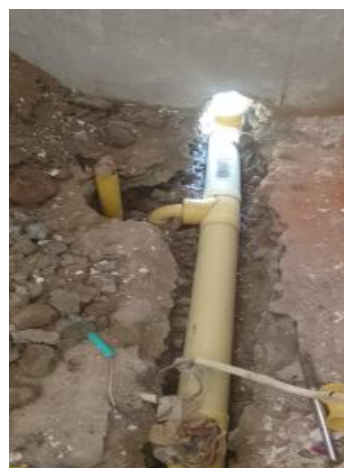
Desmante Alistado de Piso
