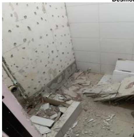
Desmante de Enchape de Pared y/o Piso
