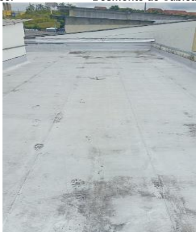
A2-2.01. Recorrido de cubierta, ajuste, limpieza, sellamiento y suministro de secciones que falten para su normal funcionamiento
