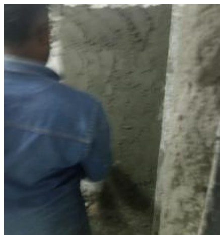
Suministro e instalación de pañete impermeabilizado muros 1:3
