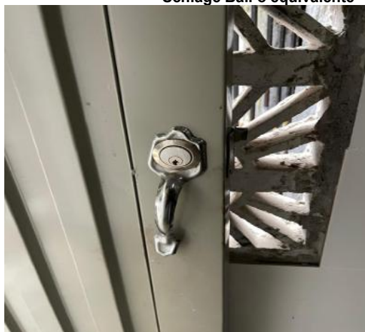
A4-14.13. Suministro, cambio e instalación Conjunto Cerradura Entrada tipo Schlage Antique Elegance para entrada principal
