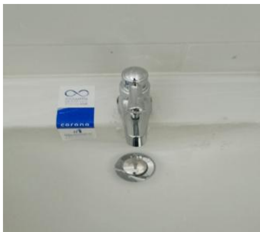
A4-3.56. Suministro e instalación de grifería monocontrol para lavamanos
