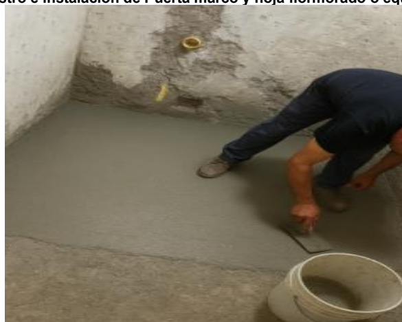
Suministro e instalación de mortero 1:3 impermeabilizado
