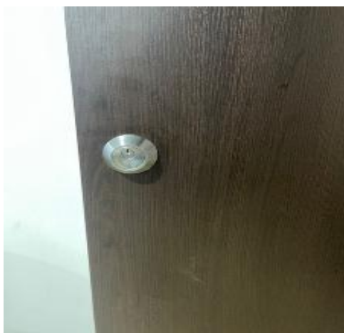
A2-14.03. Suministro, cambio e instalación Cerrojo de Seguridad de Cilindro y Volteador tipo Schlage b360 o equivalente
