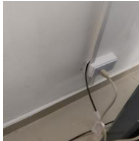
Mantenimiento y/o reposición e instalación de toma doble americana
