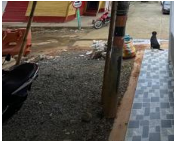
Suministro, transporte e instalación afirmado para estructuras
