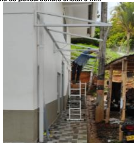
Suministro e Instalación de Estructura Metálica en perfil tipo rectangular para cubierta
