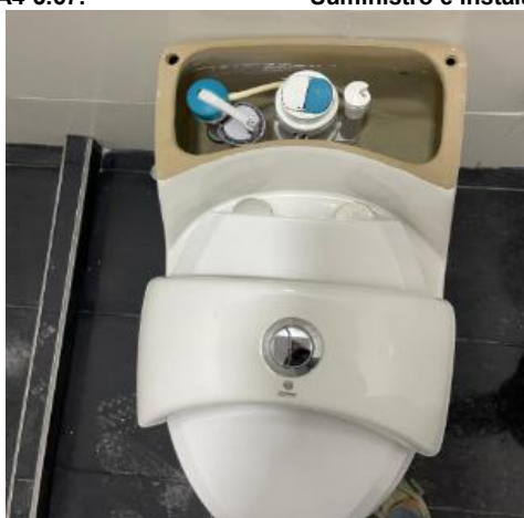
A4-3.78. Suministro e instalación de Grifería sanitaria hidrostática doble descarga
