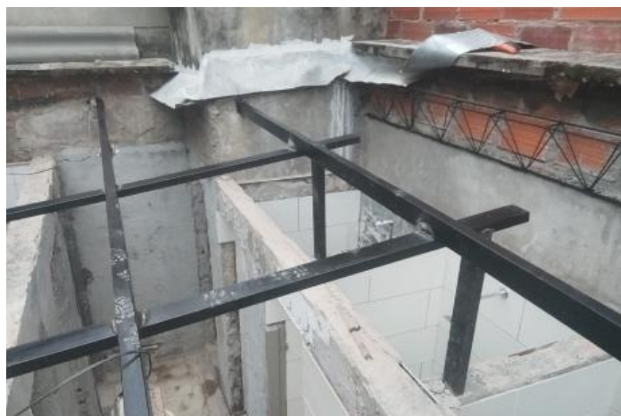
A4-2.32. Suministro e Instalación de Estructura Metálica en perfil tipo rectangular para cubierta
