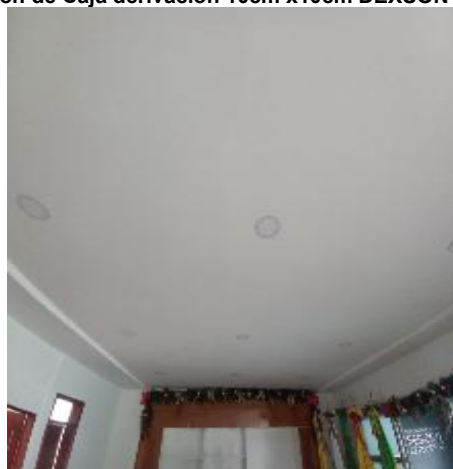
A2-4.50. Suministro e instalación de Panel Led redondo 12w
