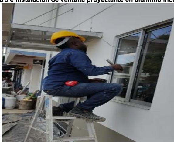
Recorrido de fachada, Ajuste, Adecuación, lavado, Sellamiento e impermeabilización para su Normal Funcionamiento.
