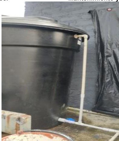
A4-9.37. Mantenimiento y reposición e instalación de TANQUE PLÁSTICO 1000 LT.
