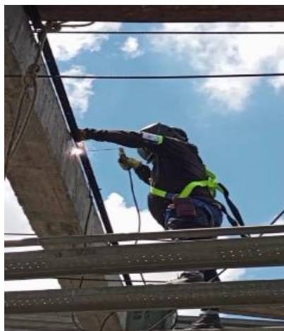
A2-2.32. Suministro e Instalación de Estructura Metálica en perfil tipo rectangular para cubierta
