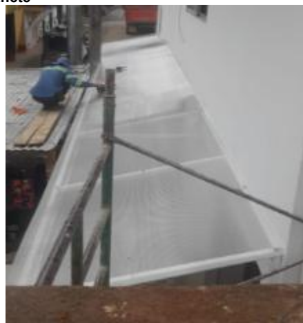
Suministro e Instalación de Cubierta en lámina de policarbonato cristal 8 mm
