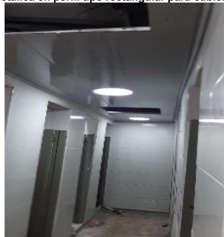
A4-2.44. Suministro e Instalación de cielo raso con tablilla en PVC. Incluye estructura metálica.
