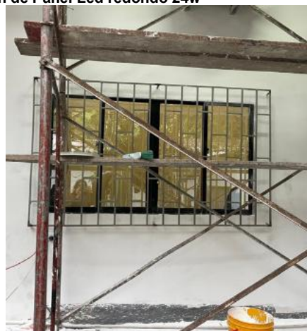
A4-7.06. Mantenimiento y reposición e instalación de esmalte sobre lámina lineal
