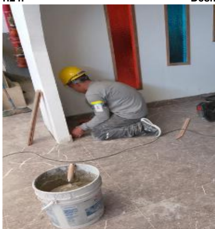
A2-8.31. Suministro e instalación de guardaescoba en cerámica.
