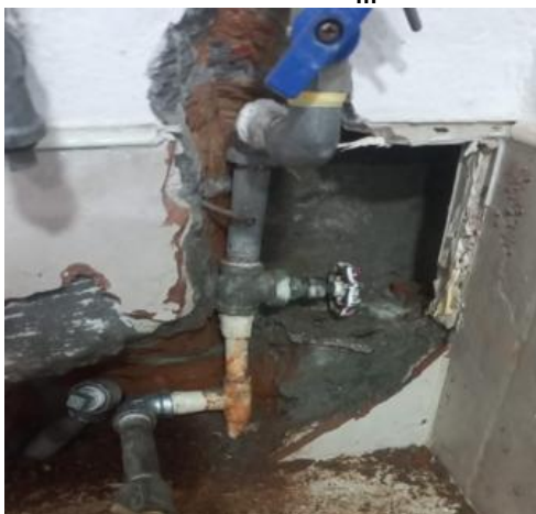
A2-1.36. Desmonte de pañete
