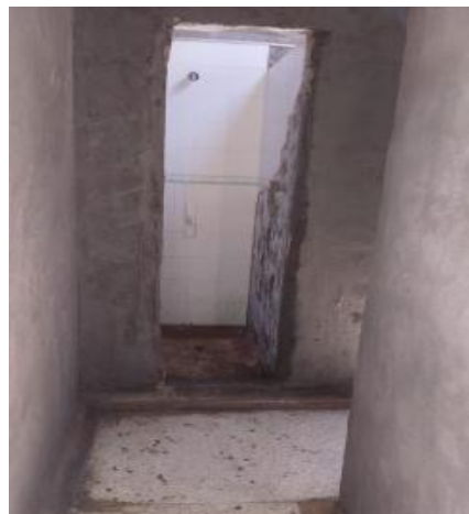
Desmante Puertas y Marcos
