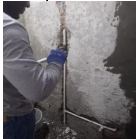
Ajuste, acondicionamiento y suministro de elementos faltantes en la red hidráulica de la edificación de 1/2" o mayor, necesarios para dejar estas redes en óptimas condiciones de funcionamiento y que cumpla con las especificaciones técnicas.
