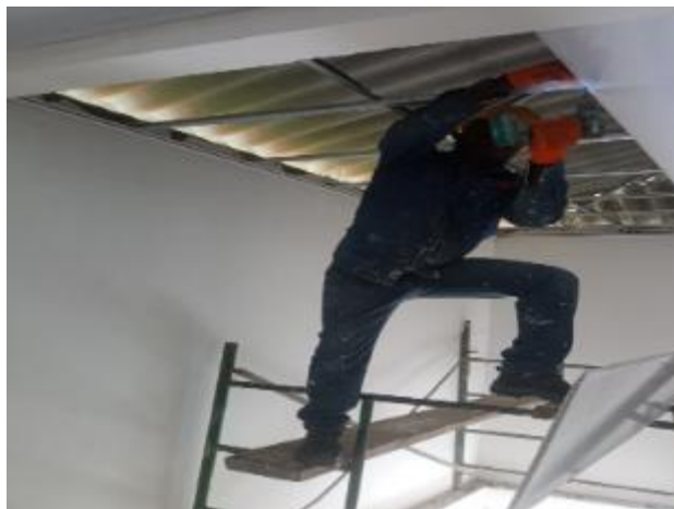
Desmante de cielo raso en cualquier material y estructura portante
