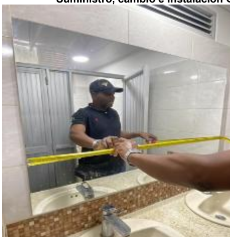
Suministro e Instalación de Espejo incoloro 3mm
