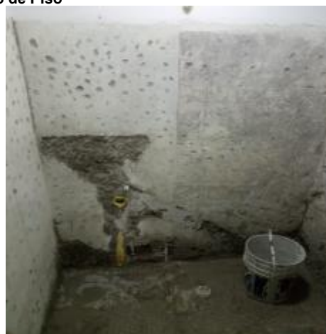
Desmante de Enchape de Pared y/o Piso
