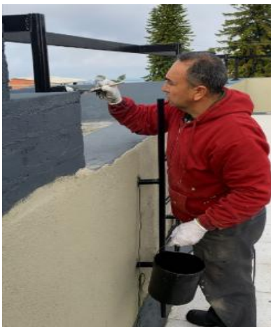
A4-7.06. Mantenimiento y reposición e instalación de esmalte sobre lámina lineal
