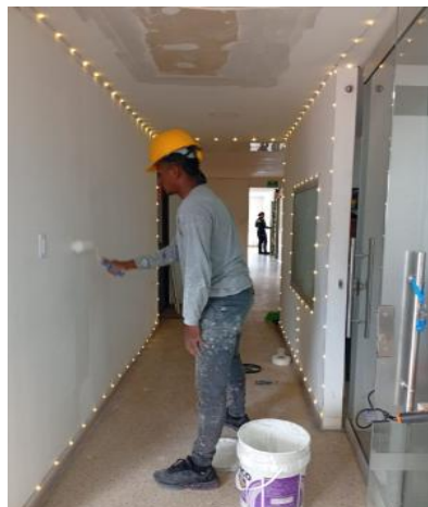
A2-7.19. Mantenimiento y reposición e instalación de vinilo sobre pañete o sobre estuco 3 manos
