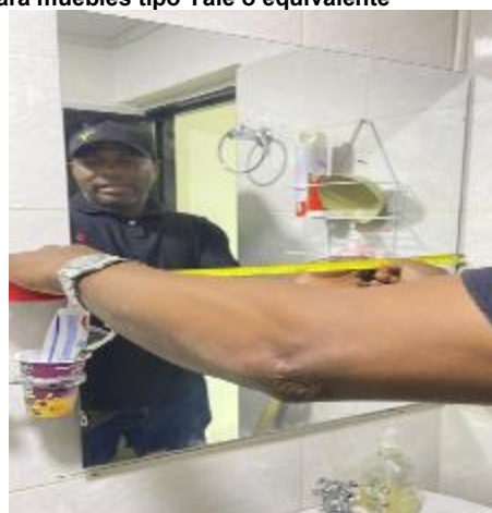
Suministro e Instalación de Espejo incoloro 3mm
