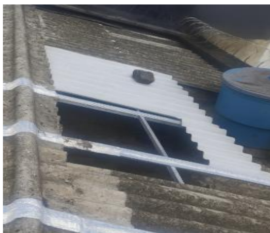
A2-1.16. Desmonte Cubierta en cualquier material
