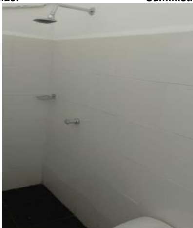
A4-9.05. Suministro e instalación enchape pared cerámica, color por definir
