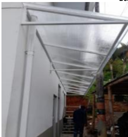
Suministro e Instalación de Cubierta en lámina de policarbonato cristal 8 mm
