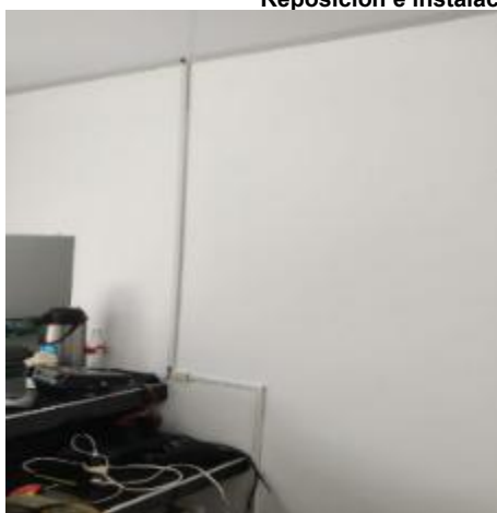
Reposición e instalación de Canaleta Plástica portacables con división para la instalación de salidas de voz, datos y energía regulada
