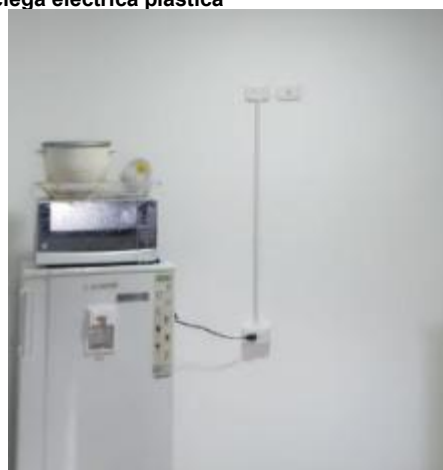
Reposición e instalación de Canaleta Plástica portacables con división para la instalación de salidas de voz, datos y energía regulada
