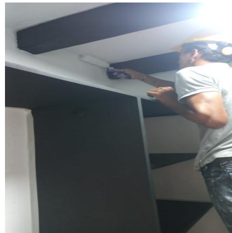
A2-7.19. Mantenimiento y reposición e instalación de vinilo sobre pañete o sobre estuco 3 manos
