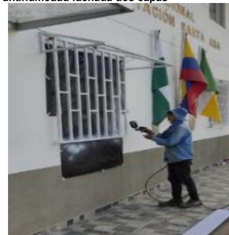
Mantenimiento y reposición e instalación de esmalte sobre lámina lineal
