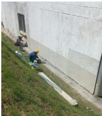
A2-7.14. Mantenimiento y reposición e instalación de revestimiento plástico de acabado texturizado estilo rayado tipo graniplast esgrafiado o equivalente
