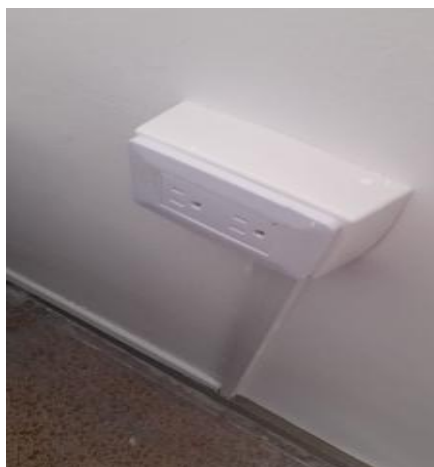
A2-4.36. Mantenimiento y/o reposición e instalación de Caja derivación 10cm x10cm DEXSON
