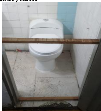
Desmante Aparatos Sanitarios
