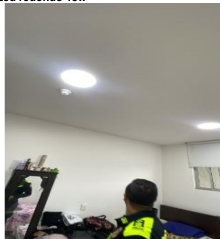
A2-4.52. Suministro e instalación de Panel Led redondo 24w
