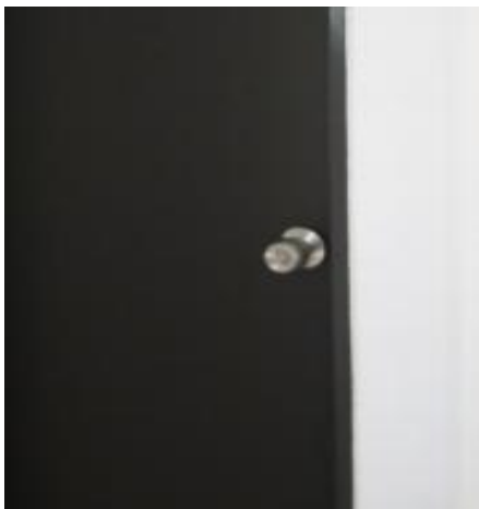
A2-14.02. Suministro, cambio e instalación Cerraduras Cilíndricas de Pomo en aluminio lacado tipo Schlage Ball o equivalente
