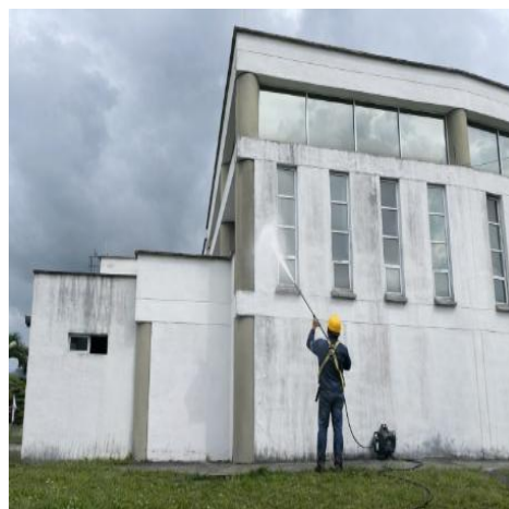
A2-13.12. Recorrido de fachada, Ajuste, Adecuación, lavado, Sellamiento e impermeabilización para su Normal Funcionamiento.
