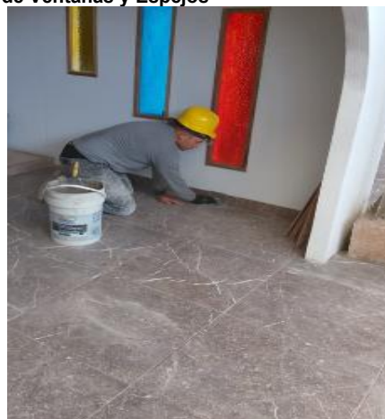
A2-8.31. Suministro e instalación de guardaescoba en cerámica.
