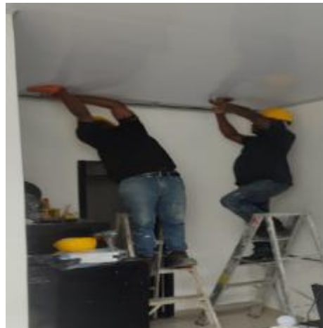
Suministro e Instalación de cielo raso con tablilla en PVC. Incluye estructura metálica.
