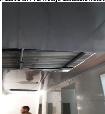
A4-2.62. Reposición e instalación de marcos para inspección cielo raso 60x 60 en aluminio color por definir
