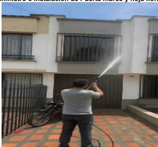
A2-13.12. Recorrido de fachada, Ajuste, Adecuación, lavado, Sellamiento e impermeabilización para su Normal Funcionamiento.
