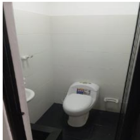
Suministro e instalación enchape pared cerámica, color por definir
