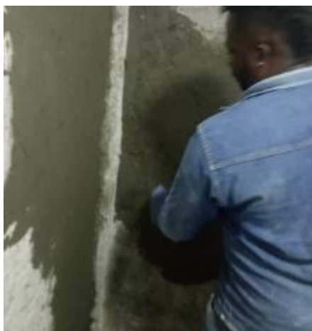
Suministro e instalación de pañete impermeabilizado muros 1:3
