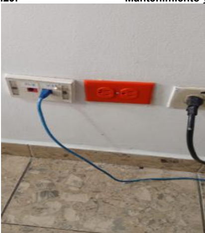
A2-4.31. Mantenimiento y/o reposición e instalación de toma doble P.T.A. 15A 125V Naranja
