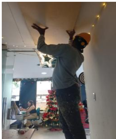
A2-2.43. Suministro e Instalación de Cielo Raso Plano en Dry Wall Incluye Estructura Metálica
