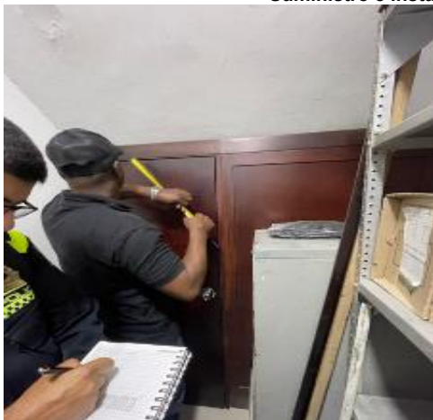
Suministro e instalación de Puerta marco y hoja flormorado o equivalente
