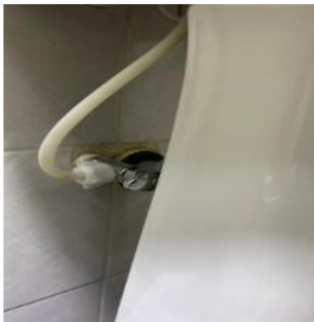
Reposición e instalación de Válvula regulación 1/2 sanitario cromo
