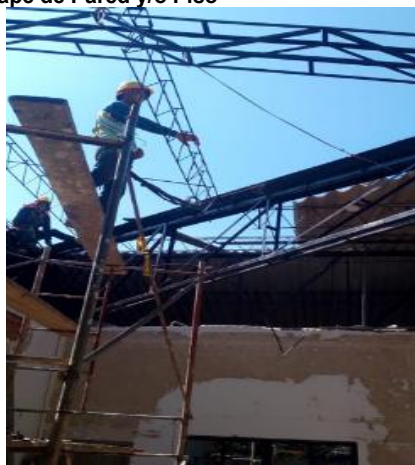
Desmante Cubierta en cualquier material
