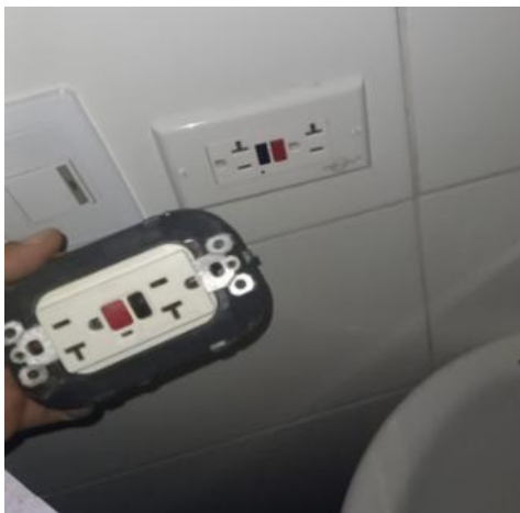
A2-4.30. Mantenimiento y/o reposición e instalación de toma doble GFCI
