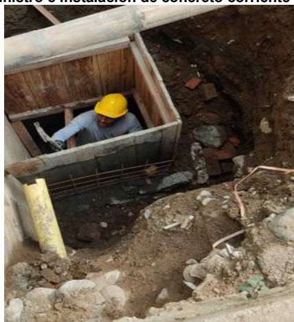
A4-12.36. Suministro e instalación de malla electrosoldada separación de 15x15 cm
