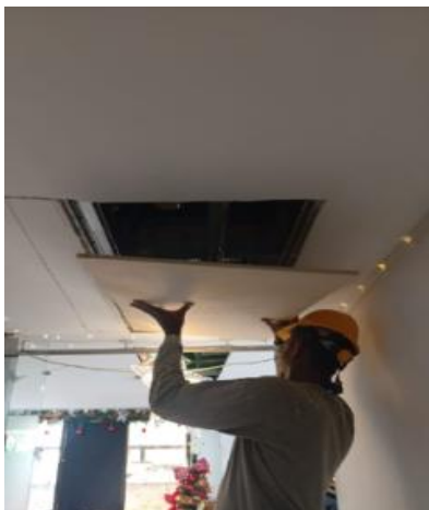
A2-2.43. Suministro e Instalación de Cielo Raso Plano en Dry Wall Incluye Estructura Metálica
