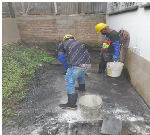
A4-3.93. Mantenimiento y limpieza interna de red sanitaria con sonda barrenadora metálica eléctrica para aparatos sanitarios
