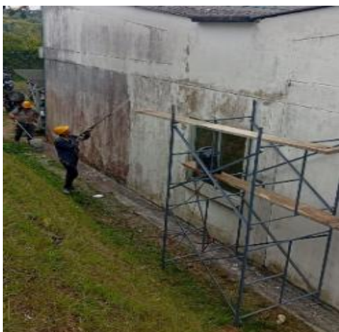
A2-13.12. Recorrido de fachada, Ajuste, Adecuación, lavado, Sellamiento e impermeabilización para su Normal Funcionamiento.
