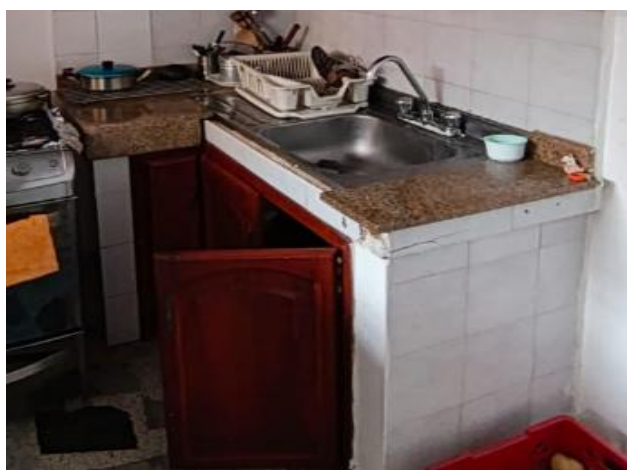
A2-1.12. Desmonte Placas Macizas
