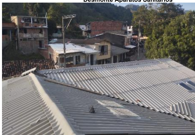
Suministro e Instalación de Cubierta en Fibrocemento Ondulada N° 8
