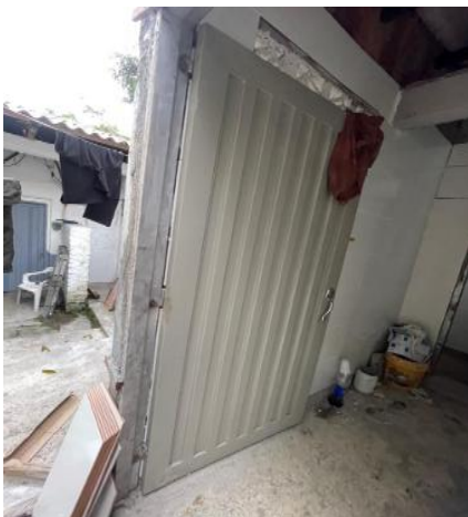
A4-7.07. Mantenimiento y reposición e instalación de esmalte sobre lámina llena
