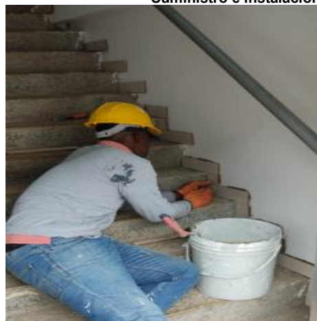
Suministro e instalación de guardaescoba en cerámica.
