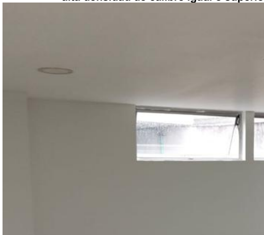
A2-2.41. Suministro e Instalación de Cielorraso en Dry Wall, Adecuando Estructura Metálica Existente
