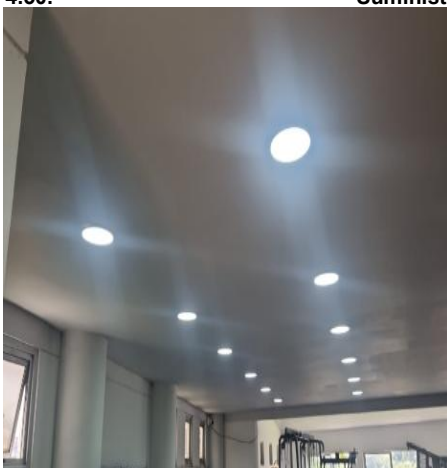
A2-4.51. Suministro e instalación de Panel Led redondo 18w
