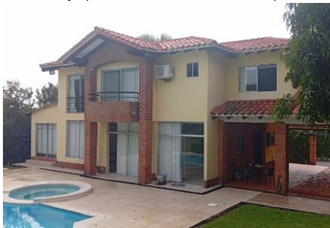
A2-7.20. Mantenimiento, reposición y aplicación pintura tipo vinilo 3 manos para exteriores de alta resistencia y máxima protección tres manos color a definir en obra. Incluye alistamiento superficie.
