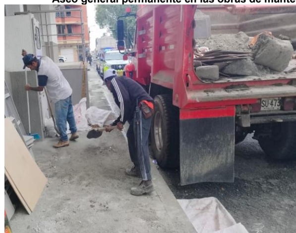
A2-17.02. Retiro de escombros a lugar autorizado por autoridades ambientales
