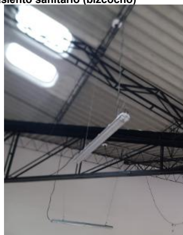
A4-4.11. Suministro e instalación de lámpara dos tubos LED hermética sobreponer
