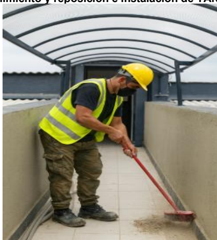
A4-17.01. Aseo general permanente en las obras de mantenimiento
