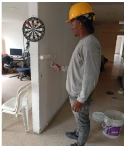
A2-7.19. Mantenimiento y reposición e instalación de vinilo sobre pañete o sobre estuco 3 manos
