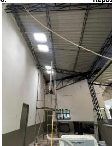
A4-4.11. Suministro e instalación de lámpara dos tubos LED hermética sobreponer
