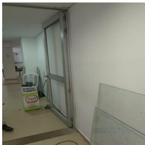
A2-1.24. Desmonte de Vidrios de Ventanas y Espejos
