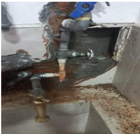
A2-1.30. Desmonte de puntos hidrosanitarios. Incluye retiro de red hidrosanitaria en una longitud hasta 1,5 m
