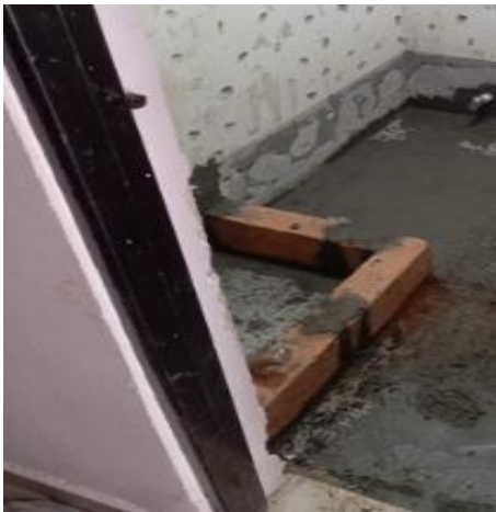
Remates en muros en ladrillo macizo prensado
