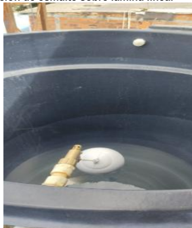
A4-9.37. Mantenimiento y reposición e instalación de TANQUE PLÁSTICO 1000 LT.
