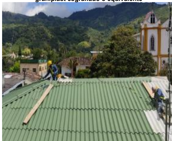
Mantenimiento, reposición y aplicación pintura tipo vinilo 3 manos para exteriores de alta resistencia y máxima protección tres manos color a definir en obra. Incluye alistamiento superficie.
