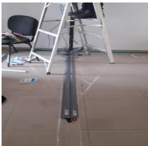
A2-1.38. Desmante de Cableado Eléctrico. Incluye tubería y demás accesorios eléctricos
