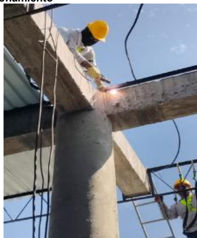
A2-2.32. Suministro e Instalación de Estructura Metálica en perfil tipo rectangular para cubierta
