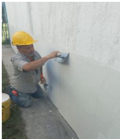
A2-7.14. Mantenimiento y reposición e instalación de revestimiento plástico de acabado texturizado estilo rayado tipo graniplast esgrafiado o equivalente
