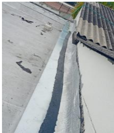
A2-2.33. Suministro e Instalación de manto autoprotegido con foil aluminio y alma central de polietileno de alta densidad de calibre igual o superior 3mm
