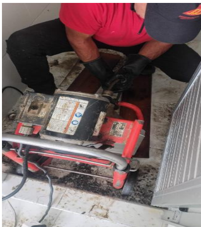
A2-3.93. Mantenimiento y limpieza interna de red sanitaria con sonda barrenadora metálica eléctrica para aparatos sanitarios
