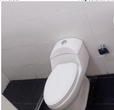
A4-3.42. Suministro e instalación de inodoro de dos piezas en porcelana y con descarga sencilla con botón superior.
