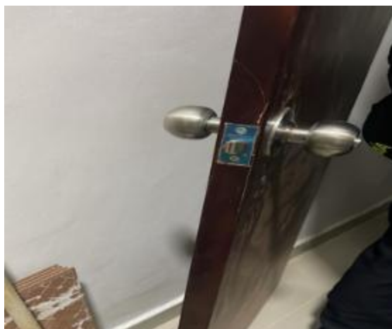
Suministro, cambio e instalación Cerraduras Cilíndricas de Pomo en aluminio lacado tipo Schlage Ball o equivalente
