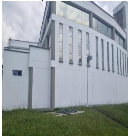
A2-7.20. Mantenimiento, reposición y aplicación pintura tipo vinilo 3 manos para exteriores de alta resistencia y máxima protección tres manos color a definir en obra. Incluye alistamiento superficie.
