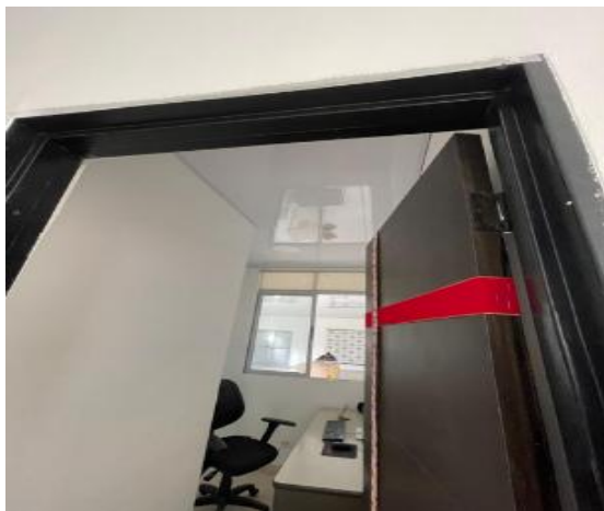
A2-7.19. Mantenimiento y reposición e instalación de vinilo sobre pañete o sobre estuco 3 manos
