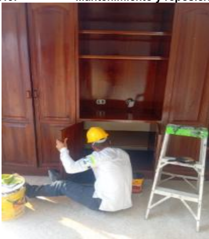
A2-10.13. Mantenimiento y reparación de muebles en madera, incluye limpieza, ajuste y reemplazo de piezas defectuosas o en mal estado del mueble existente en el mismo o mejor material
