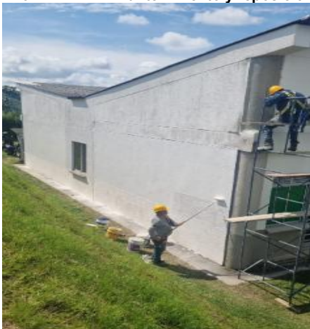
A2-7.20. Mantenimiento, reposición y aplicación pintura tipo vinilo 3 manos para exteriores de alta resistencia y máxima protección tres manos color a definir en obra. Incluye alistamiento superficie.
