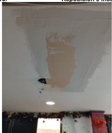
A2-7.11. Mantenimiento y reposición e instalación de estuco
