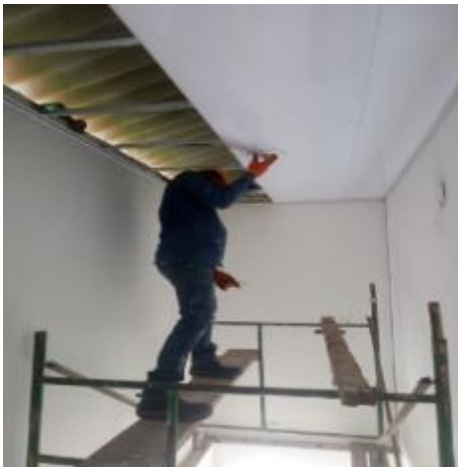
Suministro e Instalación de cielo raso con tablilla en PVC. Incluye estructura metálica.
