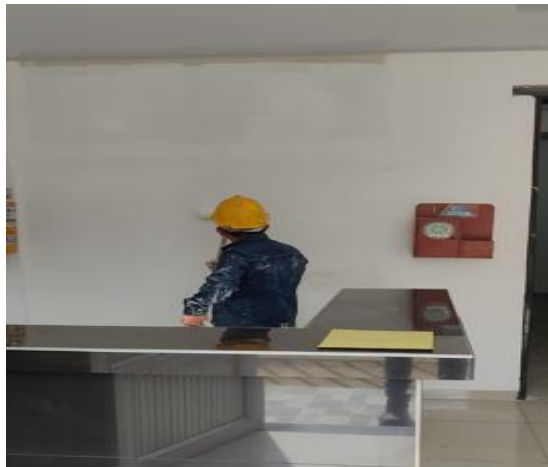
Mantenimiento y reposición e instalación de estuco y vinilo 3 manos
