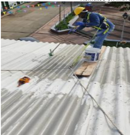
Mantenimiento y/o reposición e instalación antihumedad fachada dos capas
