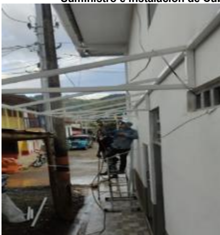
Suministro e Instalación de Estructura Metálica en perfil tipo rectangular para cubierta
