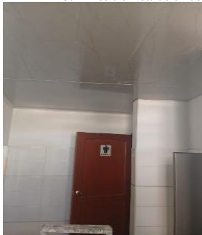
A2-2.44. Suministro e Instalación de cielo raso con tablilla en PVC. Incluye estructura metálica.
