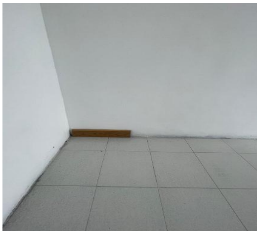
A2-8.37. Suministro e instalación de guardaescoba PVC rígido 7.5 cm
