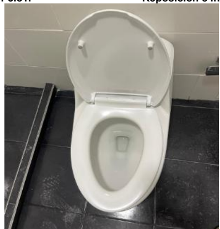
A4-3.90. Reposición e instalación de asiento sanitario (bizcocho)
