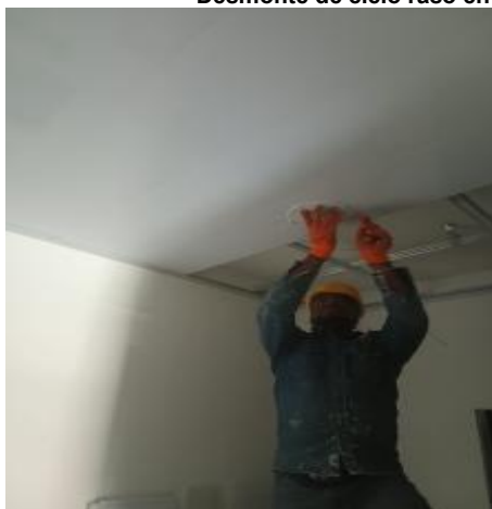
Desmante de lámparas Iluminación largas, Cuadradas, Redondas, Reflectores
