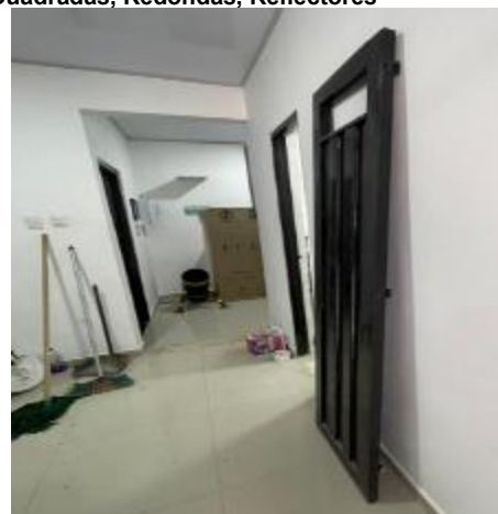
Desmante Puertas y Marcos
