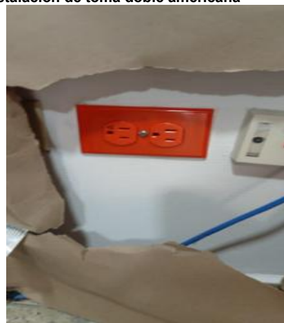
A2-4.31. Mantenimiento y/o reposición e instalación de toma doble P.T.A. 15A 125V Naranja
