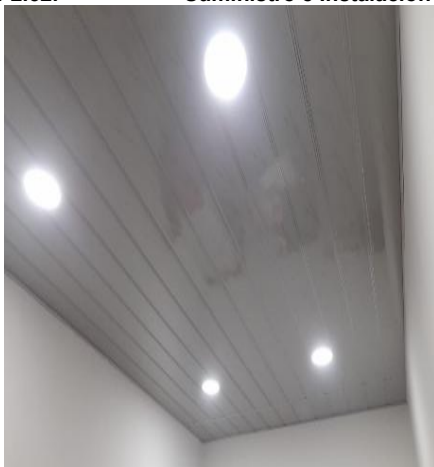
A4-2.44. Suministro e Instalación de cielo raso con tablilla en PVC. Incluye estructura metálica.
