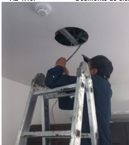
A2-1.21. Desmonte de lámparas Iluminación largas, Cuadradas, Redondas, Reflectores
