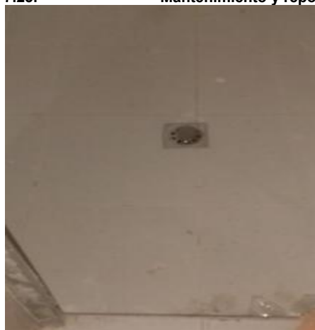
A2-9.30. Mantenimiento y reposición e instalación de REJILLA ANTICUCARACHA 3"x2"
