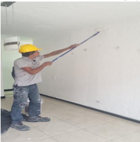
A2-7.19. Mantenimiento y reposición e instalación de vinilo sobre pañete o sobre estuco 3 manos
