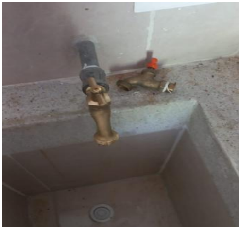
A2-3.40. Reposición e instalación de llave manguera
