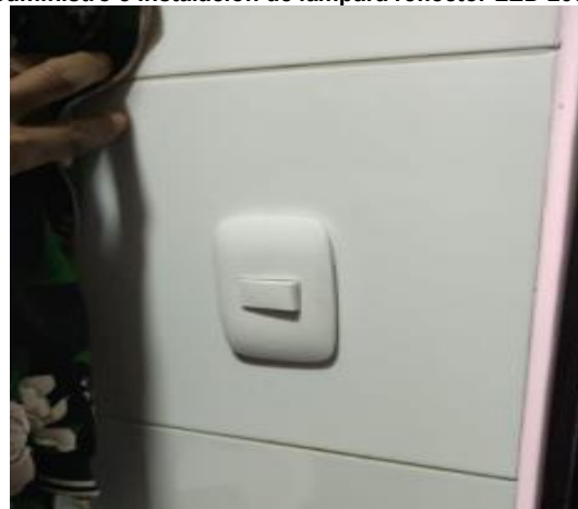
Reposición e instalación interruptor sencillo
