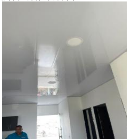
A2-4.51. Suministro e instalación de Panel Led redondo 18w
