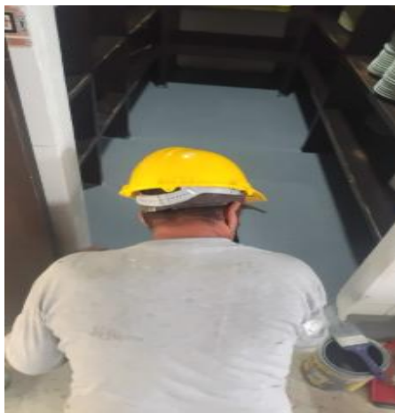
A2-7.23. Mantenimiento y reposición e instalación de Pintura epóxica tipo 1 poliamida
