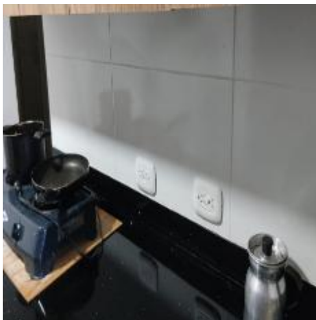
Suministro e instalación enchape pared cerámica, color por definir
