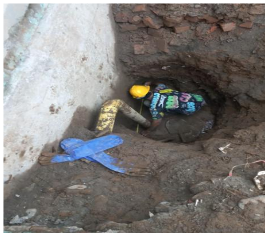
Reposición e Instalación de Tubería sanitaria PVC 4" (incluye accesorios)
