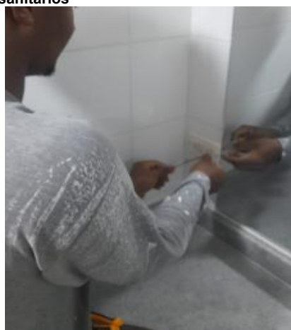
A2-4.29. Mantenimiento y/o reposición e instalación de toma doble americana
