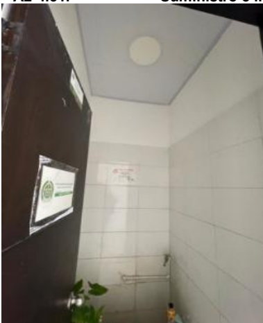
A2-4.52. Suministro e instalación de Panel Led redondo 24w
