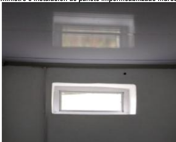
Suministro e instalación de ventana proyectante en aluminio incluye vidrio
