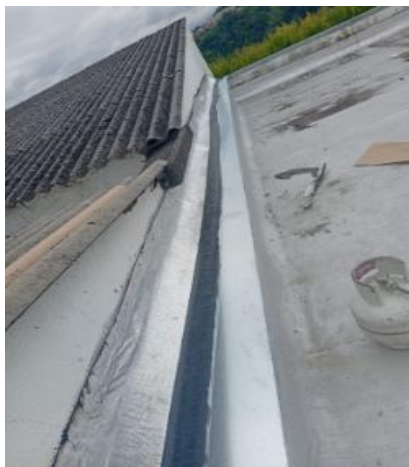
A2-2.33. Suministro e Instalación de manto autoprotegido con foil aluminio y alma central de polietileno de alta densidad de calibre igual o superior 3mm
