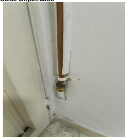
Reposición e Instalación de Tubería de Polietileno 1"
