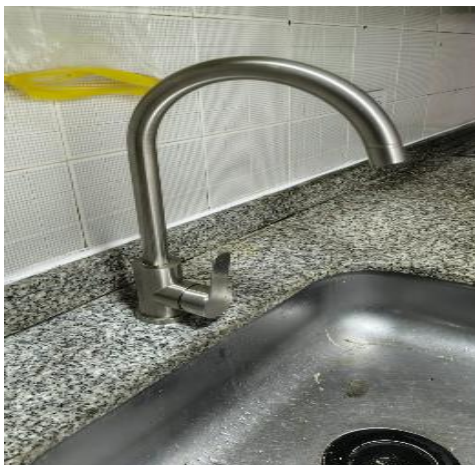
A2-3.68. Suministro e instalación de Grifería lavaplatos sencillo tipo athenea o equivalente
