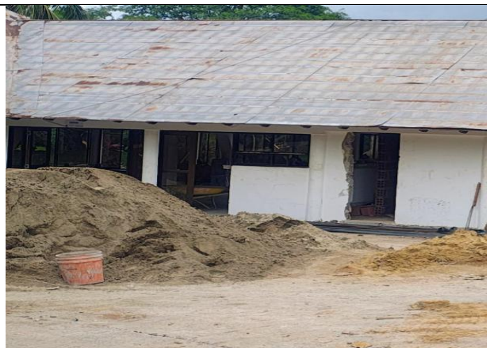
Fuente: Equipo Supervisión Foto No.1: Frente CAMOF BRIM1 Descripción: Retiro cubierta existente cocina CAMOF.
