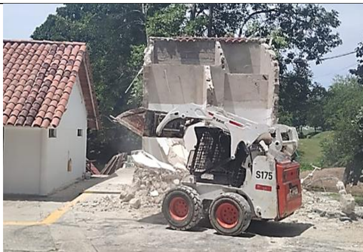
Fuente: Equipo Supervisión Foto No.2: Frente CAMOF BRIM1 Descripción: Demolición cocina CAMOF y alistado de la superficie.
