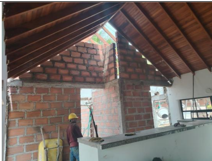
Fuente: Equipo Supervisión Foto No.28: Frente CAMOF BRIM1. Descripción: Construcción de culata cubierta
