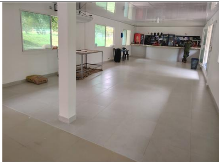
Fuente: Equipo Supervisión Foto No.27: Frente Bar cámara de infantes BFLIM17 Descripción: Suministro e instalación enchape piso
