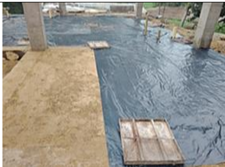
Fuente: Equipo Supervisión Foto No.26: Frente CAMOF BRIM1. Descripción: Suministro impermeabilización con plástico placa cocina
