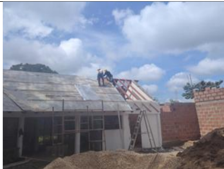
Fuente: Equipo Supervisión Foto No.27: Frente CAMOF BRIM1. Descripción: Desmonte teja CAMOF
