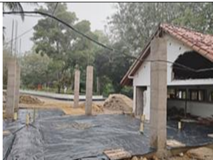
Fuente: Equipo Supervisión Foto No.25: Frente CAMOF BRIM1. Descripción: Construcción columnas cocina
