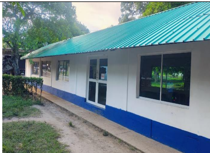
Fuente: Equipo Supervisión Foto No.28: Frente Bar cámara de infantes BFLIM17 Descripción: Suministro e instalación ventanas y puerta en aluminio
