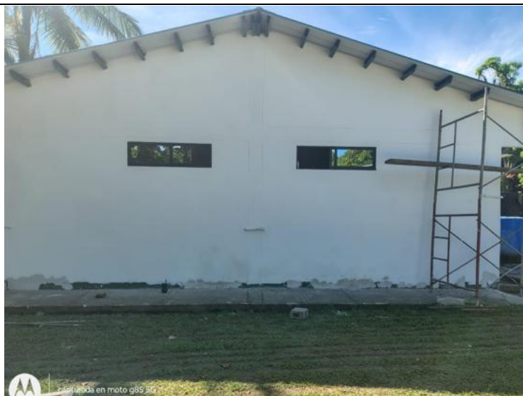
Fuente: Equipo Supervisión Foto No.25: Alojamiento CIA CUF BFLIM16 Descripción: Aplicación de estuco
