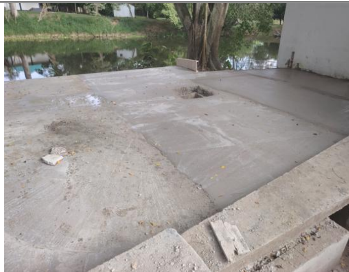
Fuente: Equipo Supervisión Foto No.13: Frente CAMOF – BRIM1 Descripción: Construcción y ampliación zona BBQ
