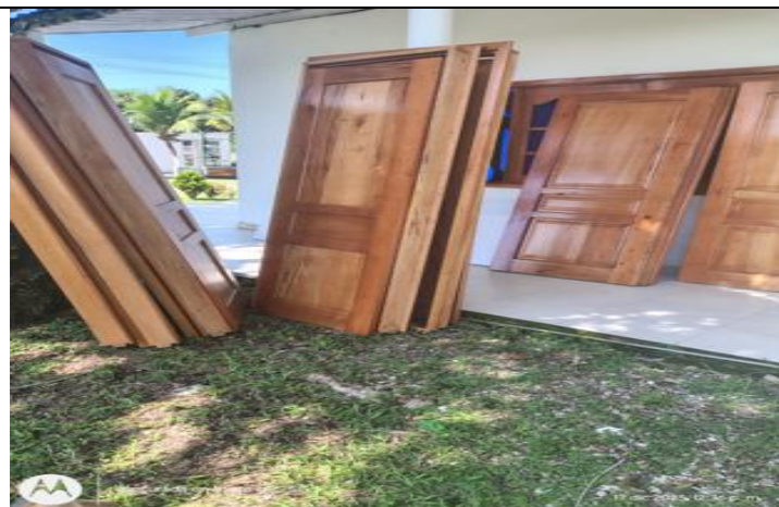
Fuente: Equipo Supervisión Foto No.26: Alojamiento CIA CUF BFLIM16 Descripción: Construcción e instalación de puertas macizas en madera.
