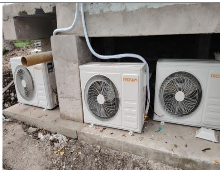
Fuente: Equipo Supervisión Foto No.15: Frente CAMOF – BRIM1 Descripción: Instalación de aireas acondicionados
