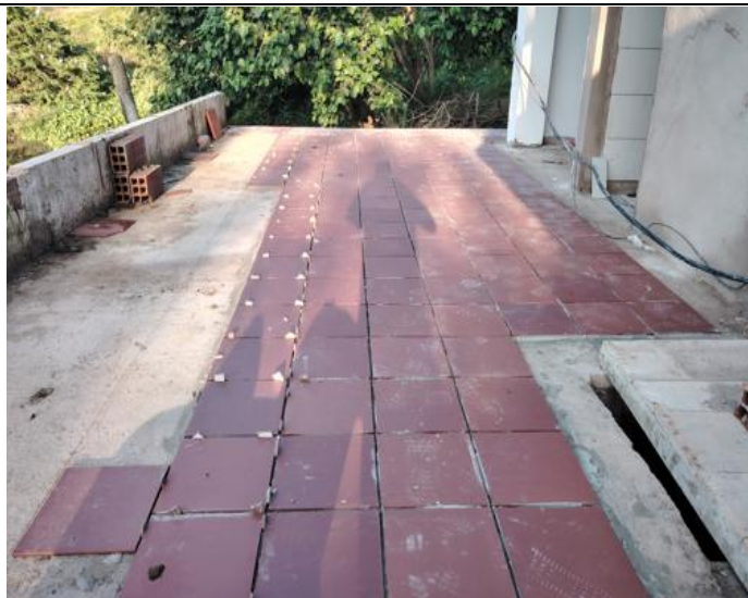
Fuente: Equipo Supervisión Foto No.14: Frente CAMOF – BRIM1 Descripción: Enchape tablón gres rojo.
