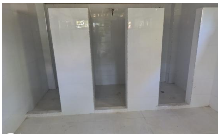
Fuente: Equipo Supervisión Foto No.25: Alojamiento CIA CUF BFLIM16 Descripción: Enchape muros y pisos zona de duchas.
