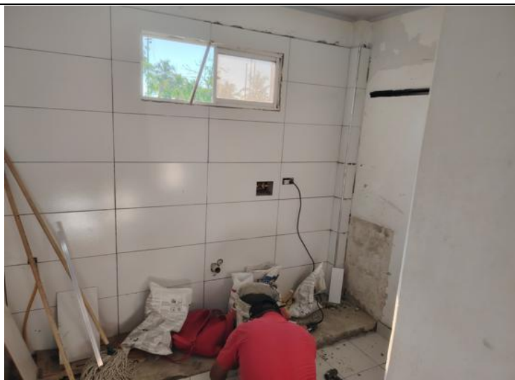
Fuente: Equipo Supervisión Foto No.47: Viviendas fiscales BRIM1- vivienda No.14 Descripción: Instalación de enchape, zona cocina.
