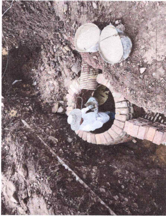
10 pozo de inspección
