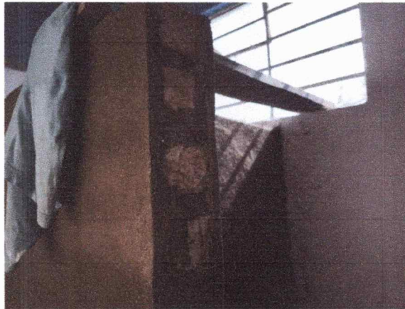
7. Mampostería en ladrillo.
