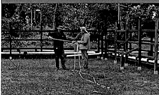
VERIFICACIÓN DE CABLEADO PARA
