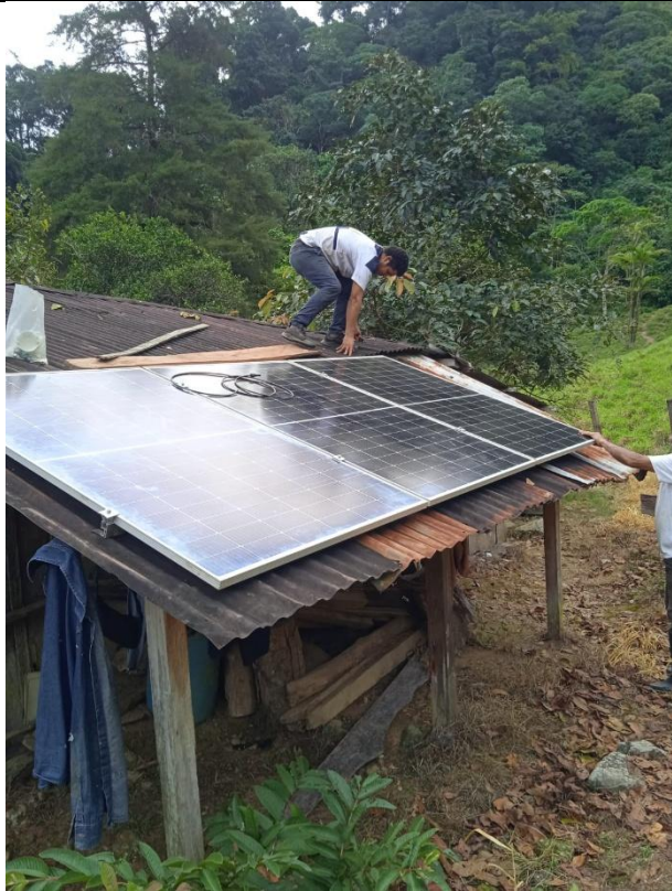
Ilustración 2. Instalación de sistemas fotovoltaicos
