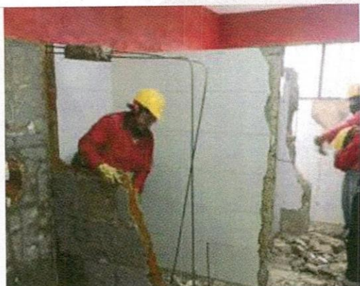
Inicio demolición baños
