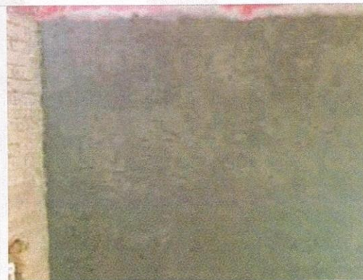
Pañetes sobre muros
