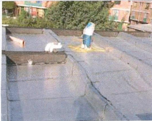
Instalación de manto
