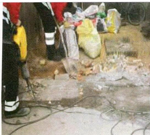
Demolición de muros
