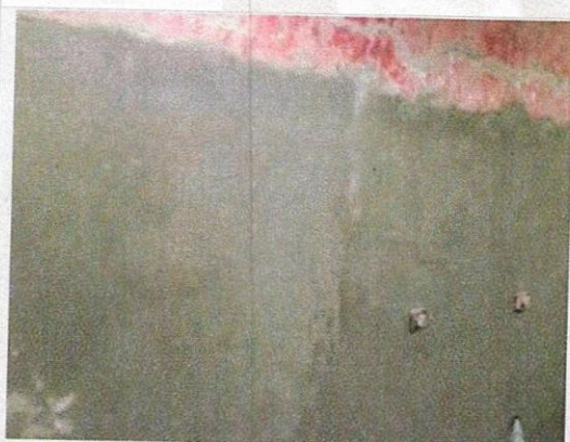
Pañete sobre muros de baño
