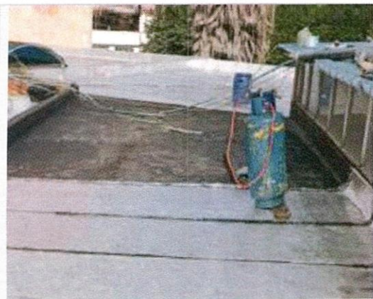
Instalación de manto
