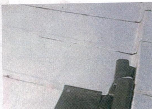
Instalación de manto
