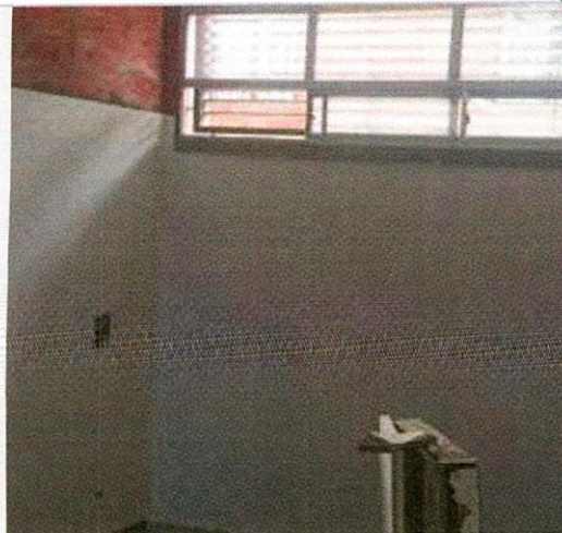
Finalización enchapes muro
