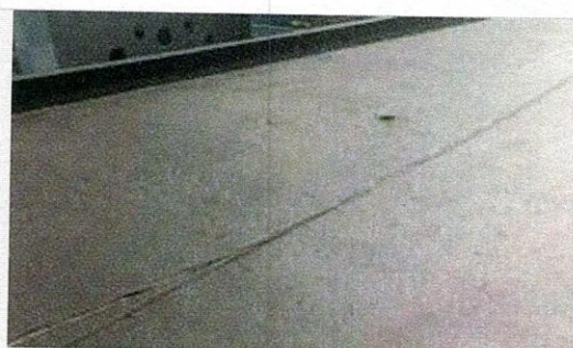
Imprimación de cubierta
