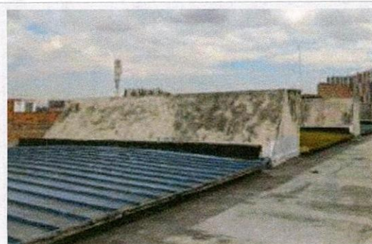
Estado inicial de cubiertas
