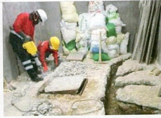
Cambio de red sanitaria
