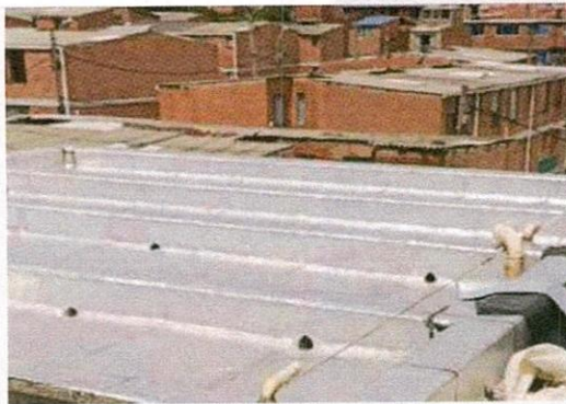
Instalación de manto
