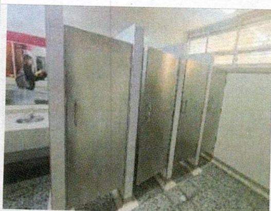
Registro inicial puertas para desmonte
