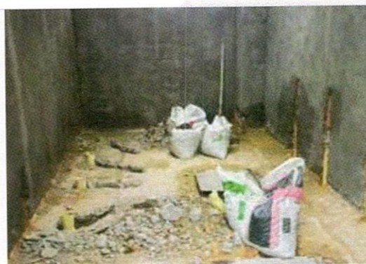
Cambio de red sanitaria
