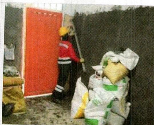
Pañete de muros
