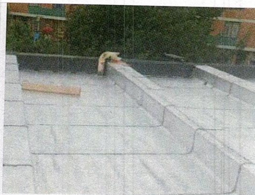
Instalación de manto
