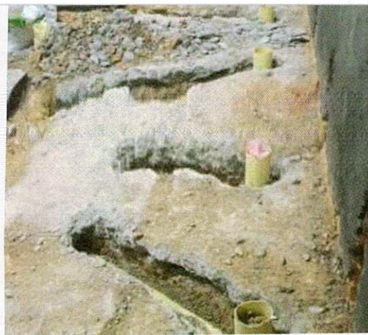
Cambio de red sanitaria
