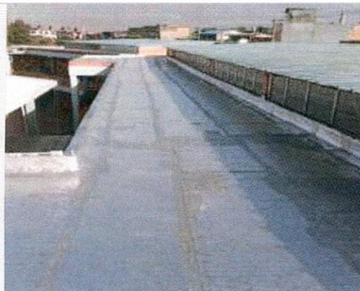
Finalización de manto de cubierta
