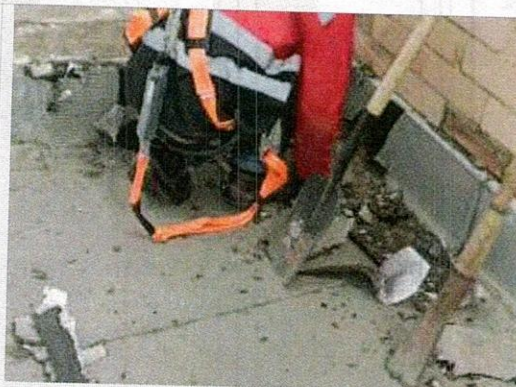
Desmonte de manto
