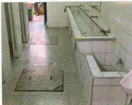
Estado inicial baño
