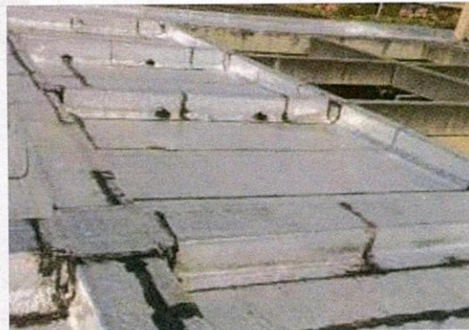
Instalación de manto
