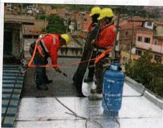
Instalación de manto
