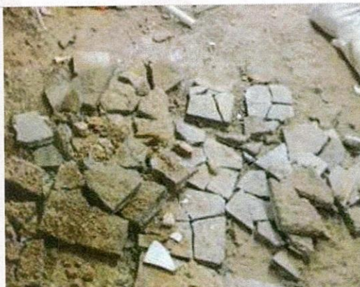
Inicio demolición pisos
