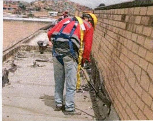
Desmonte de manto
