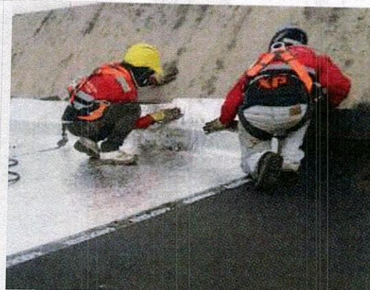
Instalación de manto
