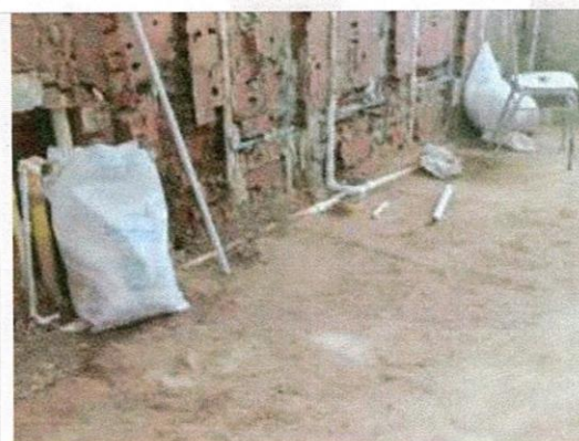
Recolección de escombros
