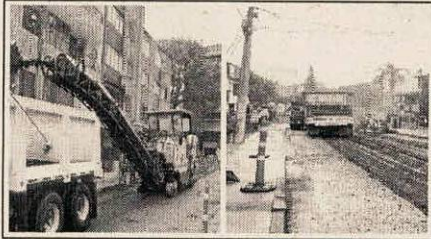
DESCRIPCIÓN: Fresado de la vía Calle 46 D Sur entre Carrera 42 B y Carrera 42 D (Trianon).
