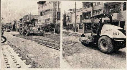
DESCRIPCIÓN: Llenos, compactación y nivelación de base granular Calle 46 D Sur entre Carrera 42 B y Carrera 42 D (Trianon).
