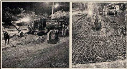
DESCRIPCIÓN: Excavación y botada de material de lleno existente Carrera 49 - Estación del Metro.
