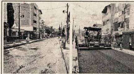
DESCRIPCIÓN: Imprimación y pavimentación de la vía Calle 46 D Sur entre Carrera 42 B y Carrera 42 D (Trianon).
