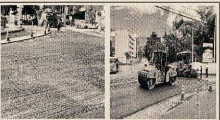
DESCRIPCIÓN: Imprimación y pavimentación de la vía Calle 48 Sur entre Carrera 40 y Carrera 43 A (Loma del Barro).
