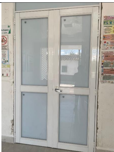
Ilustración 3 Instalación de puertas en aluminio y vidrio templado
