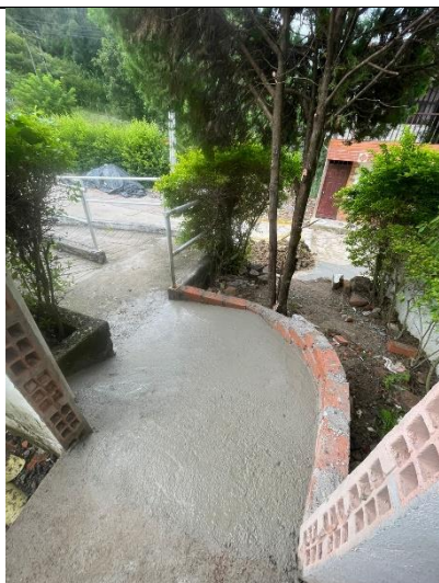
Ilustración 5: Instalación de gravilla lavada
