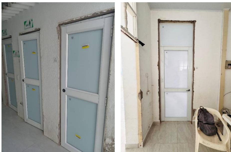
Foto 3. Resanes en la instalación de las puertas
