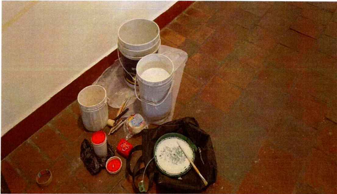
Foto 2: Adecuación de espacios expositivos. – Cúcuta – Norte de Santander, Centro Cultural Torre del Reloj, Fecha: 18 de diciembre de 2025 Evento Cultural “común ∞ silvestre” Fotógrafo: Mauricio SánchezZ
