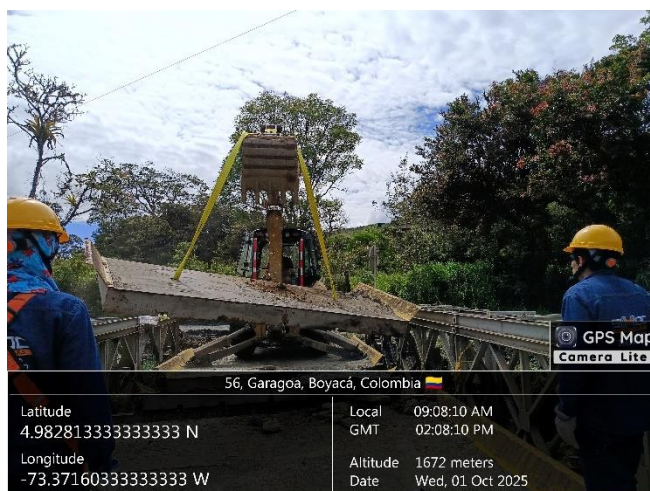
Foto 3 y 4: Maniobra de izaje de sección del tablero metálico con retroexcavadora (pajarita), y disposición en franja aledaña a la vía.
