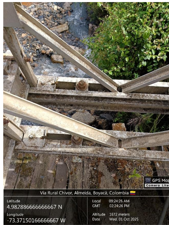
Foto 5, 6, 7 y 8: Evidencia del estado de la estructura del puente al inicio de los trabajos.
