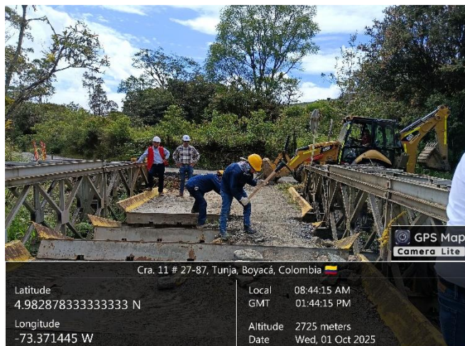
Foto 1: Vista superestructura de puente, se realizan trabajos de retiro de material que se encuentran sobre el tablero metálico.
