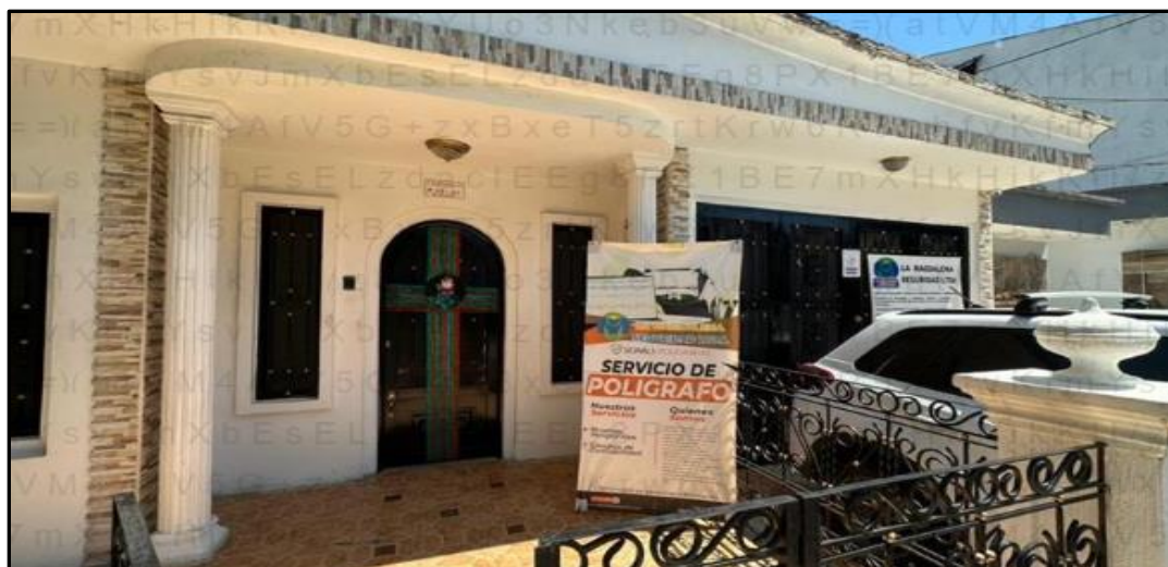
Imagen 12. Registro fotográfico instalaciones ubicada en la ciudad de Florencia
