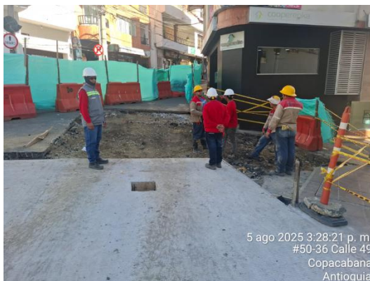
Demolición de pavimento, excavación y llenos en base granular en esquina de calle 49 con carrera 51 (comando de policía)
