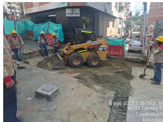
Demolición de pavimento, excavación y llenos en base granular en esquina de calle 49 con carrera 51 (comando de policía)
