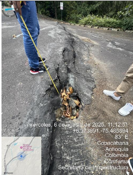
Foto No. 5- Vista del escalonamiento del pavimento o reptación del suelo en zona de parqueaderos.
