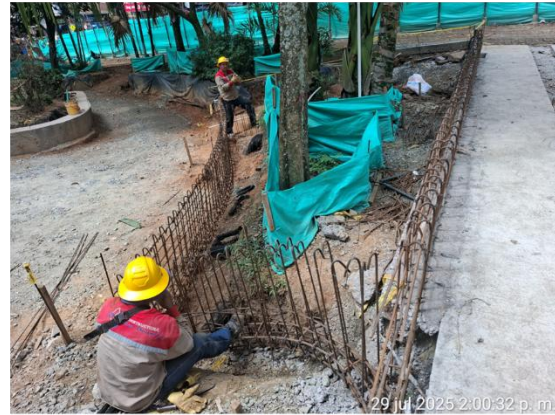
Corte, figuración e instalación de acero de refuerzo para cimentaciones de muros y bancas tipo jardinera al interior del parque
