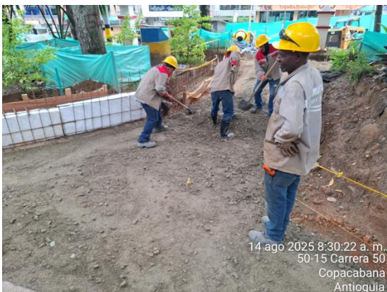
Excavaciones y llenos estructurales para perfilación de terreno en zona peatonal al interior del parque
