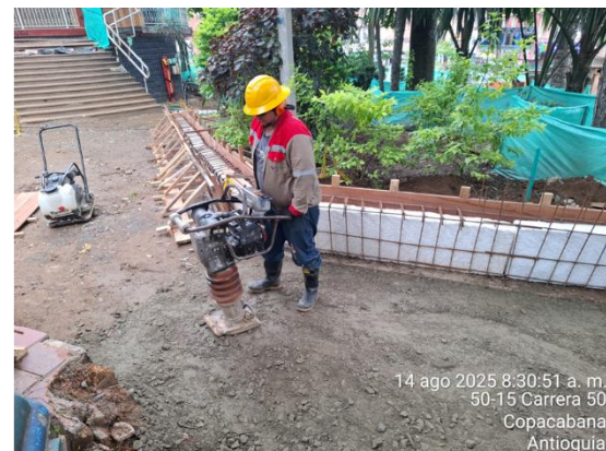
Excavaciones y llenos estructurales para perfilación de terreno en zona peatonal al interior del parque
