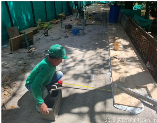
Instalación de enchape tipo royal Beta al interior del parque.
