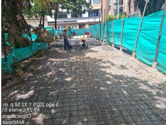
Instalación de malla electrosoldada y vaciado de placas de entripiso en circulaciones peatonales al interior del parque
