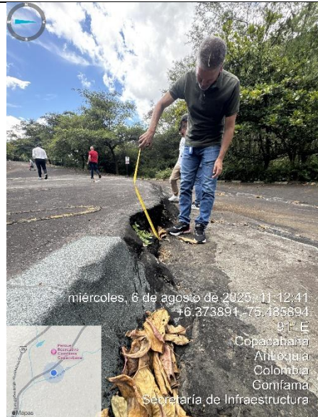
Foto No. 4- Vista del escalonamiento del pavimento o reptación del suelo en zona de parqueaderos.
