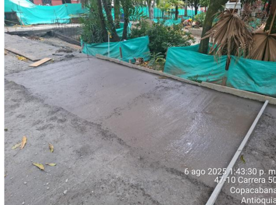
Instalación de malla electrosoldada y vaciado de placas de entripiso en circulaciones peatonales al interior del parque
