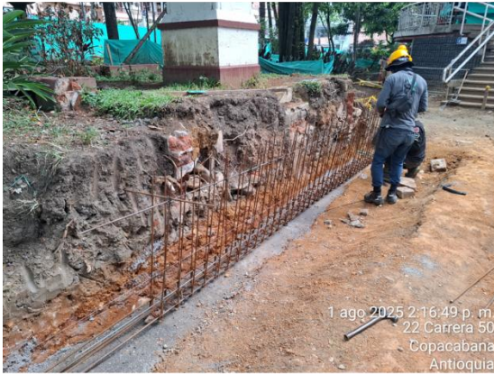
Corte, figuración e instalación de acero de refuerzo para cimentaciones de muros y bancas tipo jardinera al interior del parque
