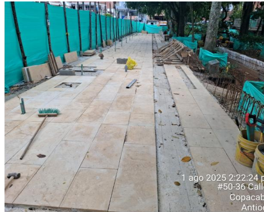
Instalación de enchape tipo royal Beta al interior del parque.
