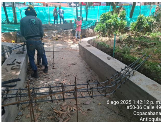
Corte, figuración e instalación de acero de refuerzo para cimentaciones de muros y bancas tipo jardinera al interior del parque
