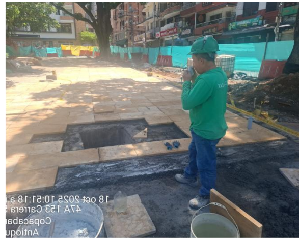
Instalación de dilatación y lechada de enchape tipo royal Beta al interior del parque.
