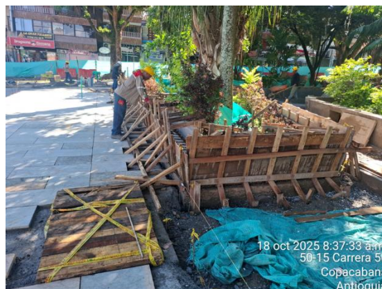
Encofrado de bancas tipo jardinera al interior del parque
