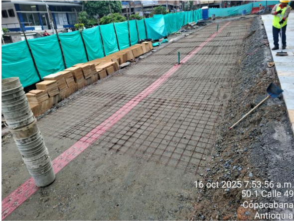
Instalación de malla electrosoldada y vaciado de placas de entrepiso en circulaciones peatonales al interior del parque
