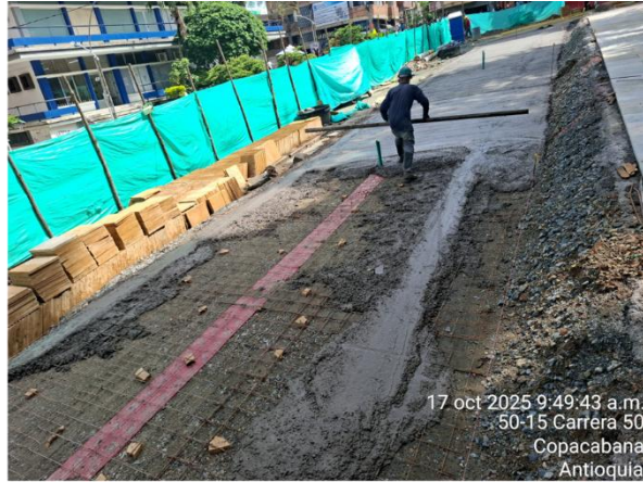
Instalación de malla electrosoldada y vaciado de placas de entrepiso en circulaciones peatonales al interior del parque
