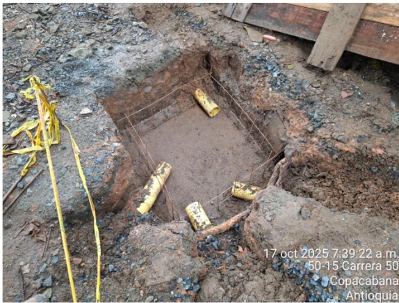
Instalación de redes y construcción de cajas para recolección de aguas lluvias al interior del parque
