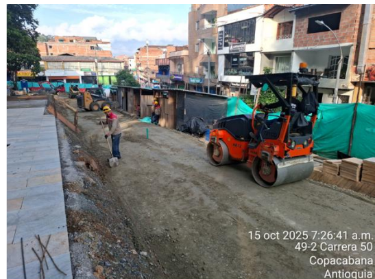
Excavaciones y llenos estructurales para perfilación de terreno en zonas peatonales al interior del parque
