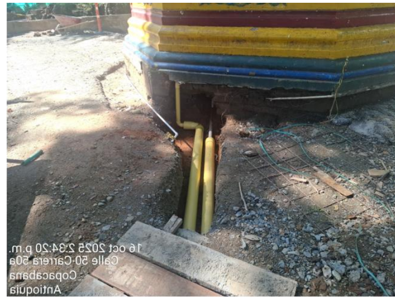
Instalación de redes y construcción de cajas para recolección de aguas lluvias al interior del parque
