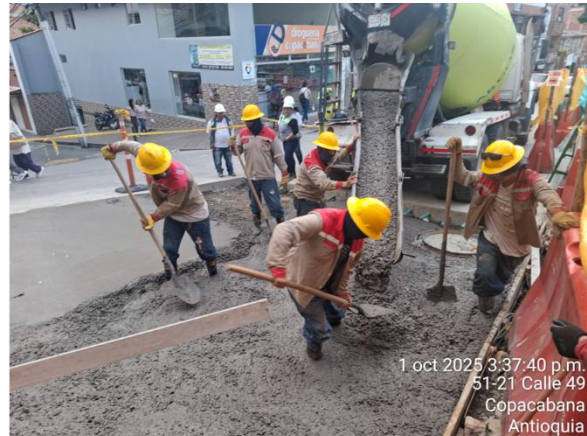
Vaciado de pavimento rígido tipo MR en esquina de carrera 51 con calle 49
