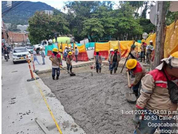
Vaciado de pavimento rígido tipo MR en esquina de carrera 51 con calle 49
