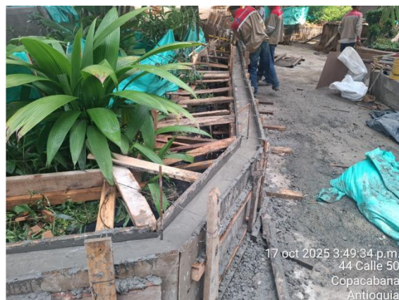
Encofrado y vaciado de muro tipo jardinera al interior del parque
