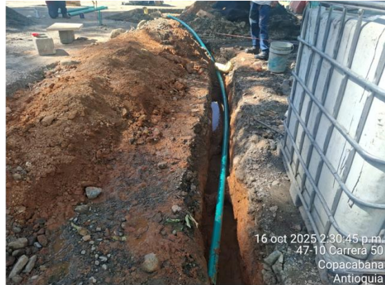
Instalación de redes de energía al interior del parque
