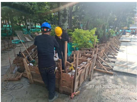
Encofrado de bancas tipo jardinera al interior del parque
