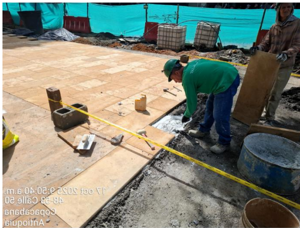
Instalación de dilatación y lechada de enchape tipo royal Beta al interior del parque.
