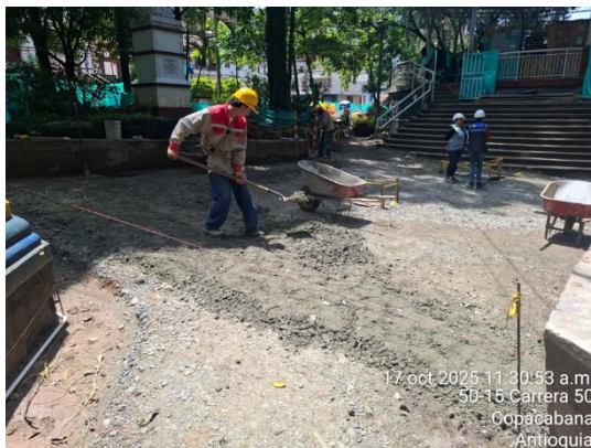
Excavaciones y llenos estructurales para perfilación de terreno en zonas peatonales al interior del parque
