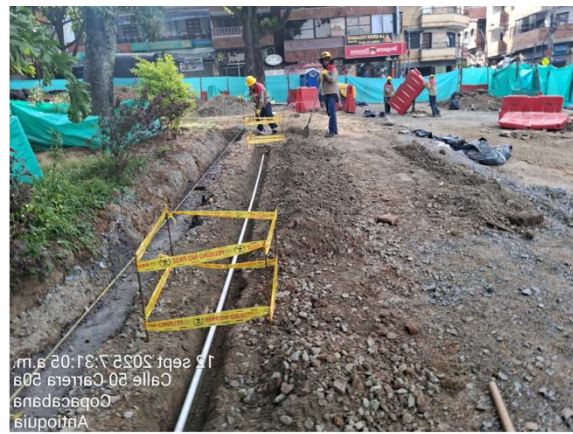
Instalación de redes de acueducto al interior del parque
