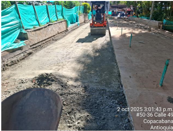
Se terminan excavaciones y se realizan llenos estructurales con base granular en calle 49 entre carrera 50 y carrera 51
