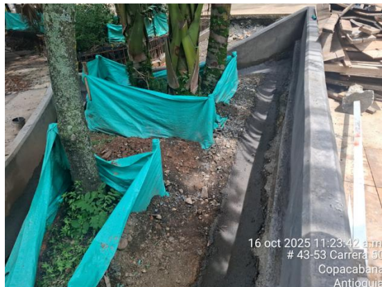
Excavación, vaciado de cañuela, aplicación de igol denso e instalación de tubería microperforada y geodren para sistema de recolección de aguas lluvias en jardineras al interior del parque
