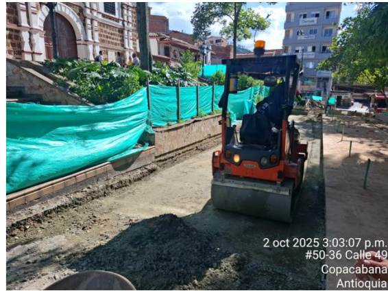
Se terminan excavaciones y se realizan llenos estructurales con base granular en calle 49 entre carrera 50 y carrera 51
