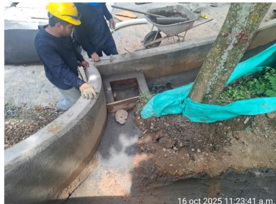
Excavación, vaciado de cañuela, aplicación de igol denso e instalación de tubería microperforada y geodren para sistema de recolección de aguas lluvias en jardineras al interior del parque
