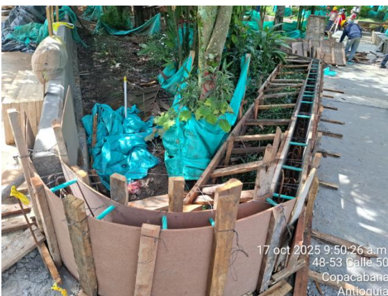
Encofrado y vaciado de muro tipo jardinera al interior del parque
