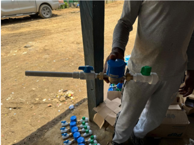
Suministro accesorios domiciliarias
