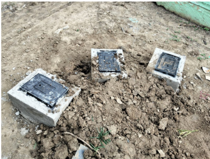
Instalación de domiciliarias
