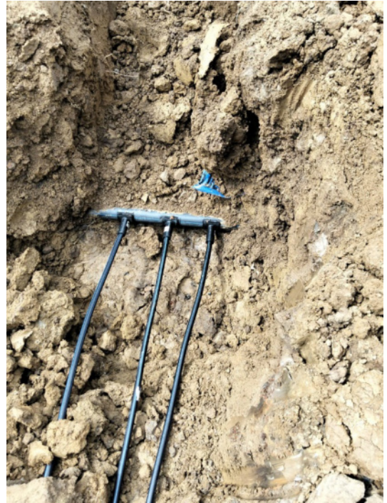
Instalación de domiciliarias
