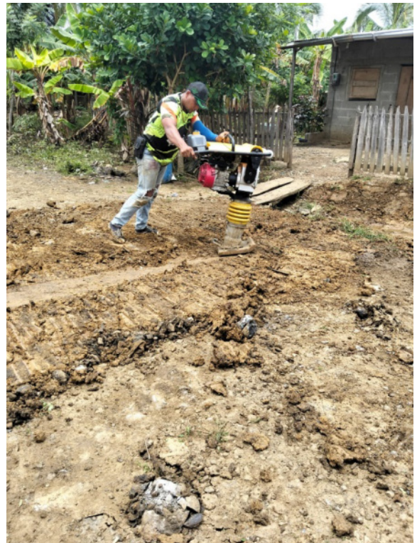
Compactación de capas de relleno
