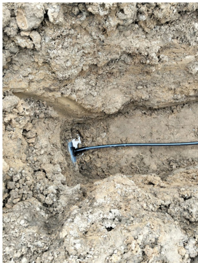
Instalación de domiciliarias
