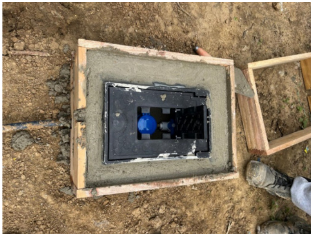
Instalación de domiciliarias
