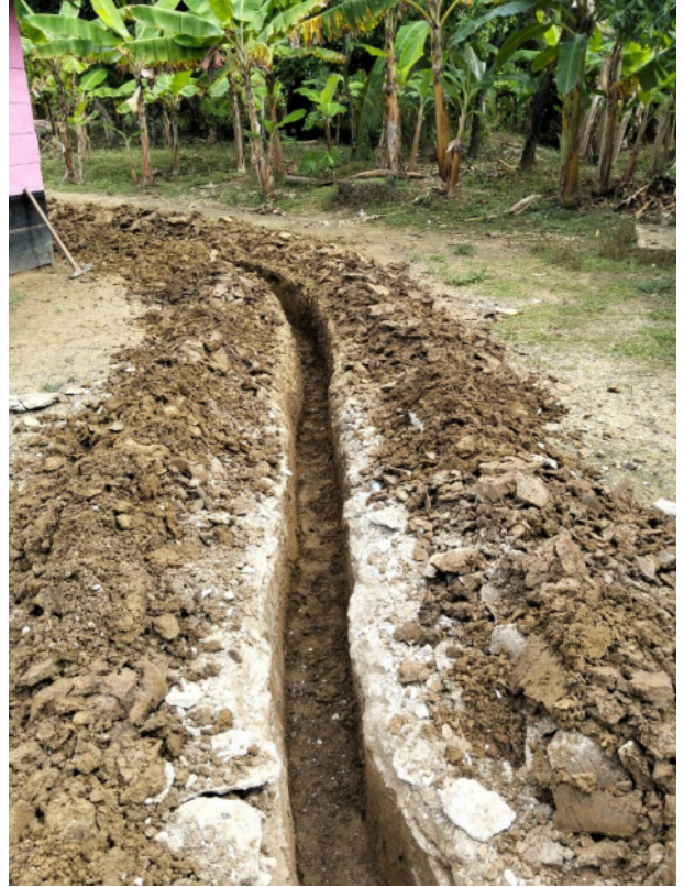
Excavaciones a maquina
