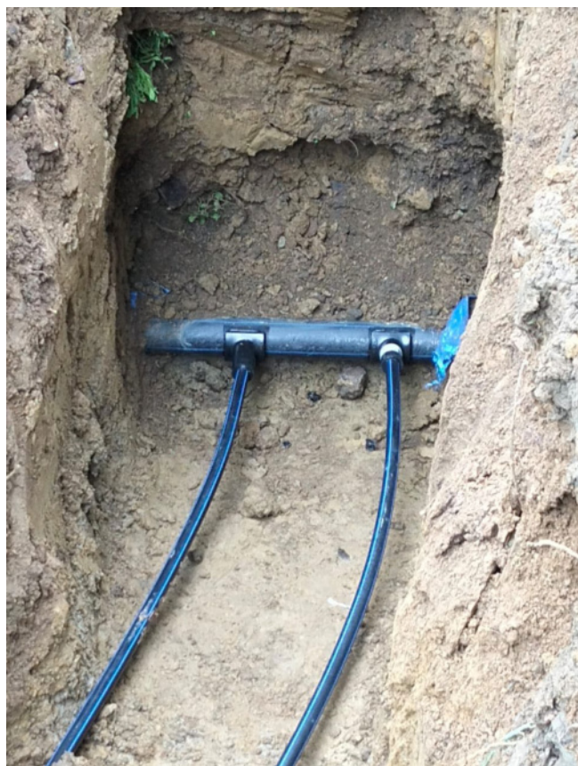
Instalación de domiciliarias
