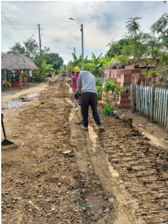
Relleno y compactación de material
