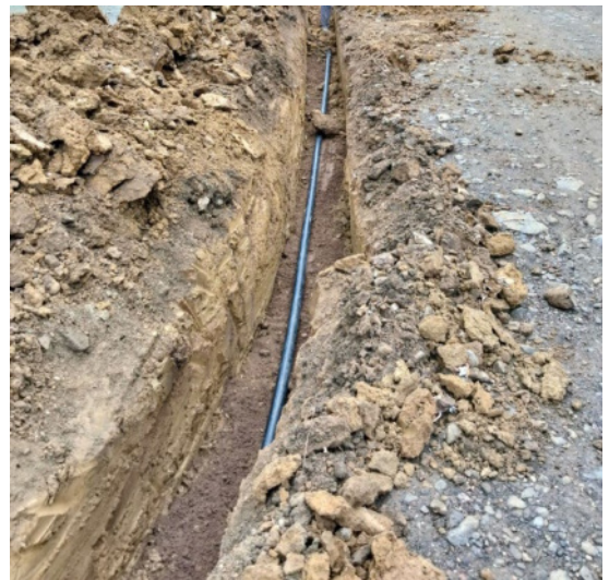
Instalación de tubería de 20 mm
