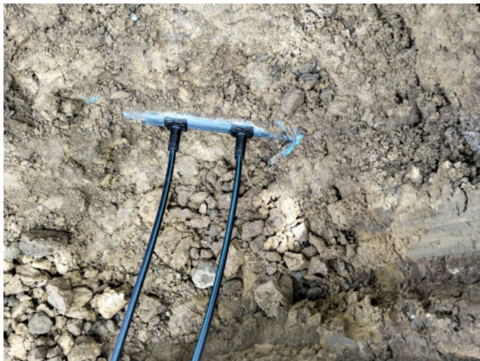
Instalación de domiciliarias
