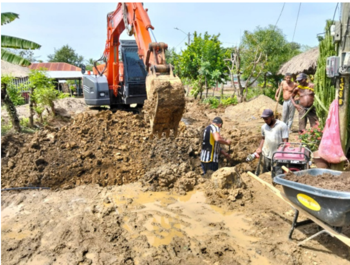
Excavaciones a maquina
