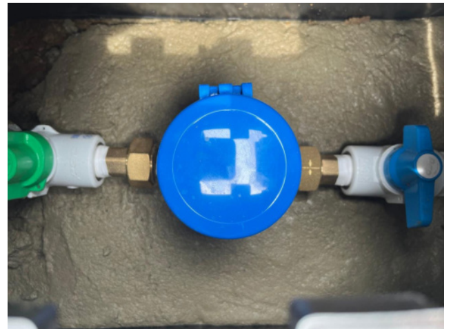
Instalación de domiciliarias
