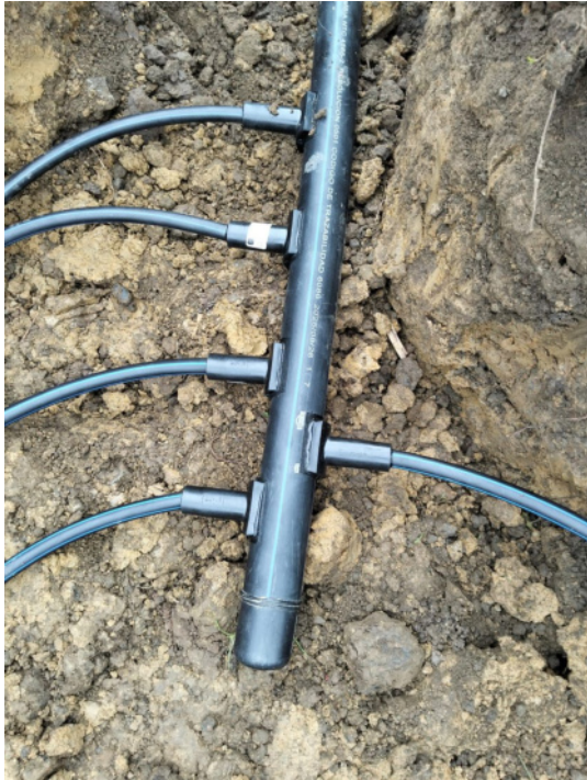
Instalación de domiciliarias
