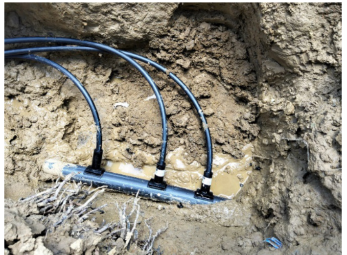
Instalación de domiciliarias
