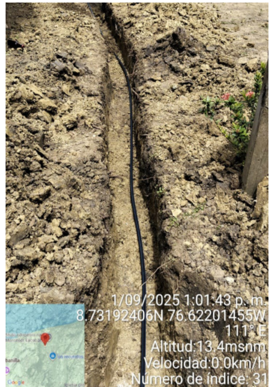
Instalación de tubería de 20 mm
