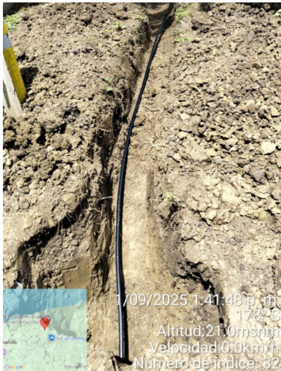
Instalación de tubería de 20 mm
