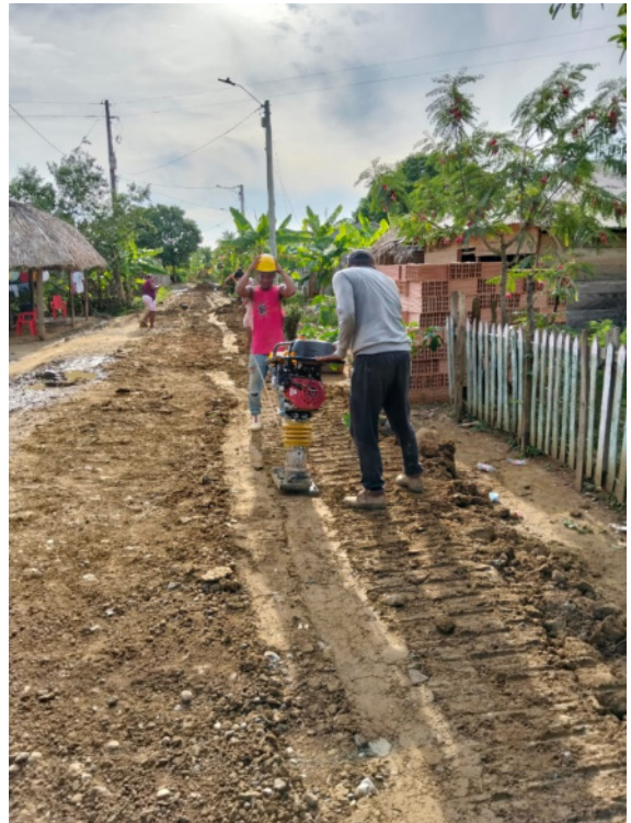
Relleno y compactación de material
