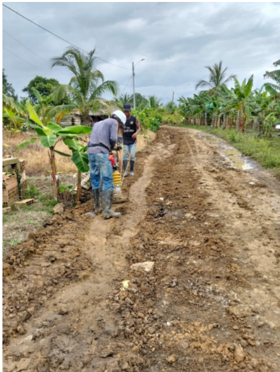
Compactación de capas de relleno
