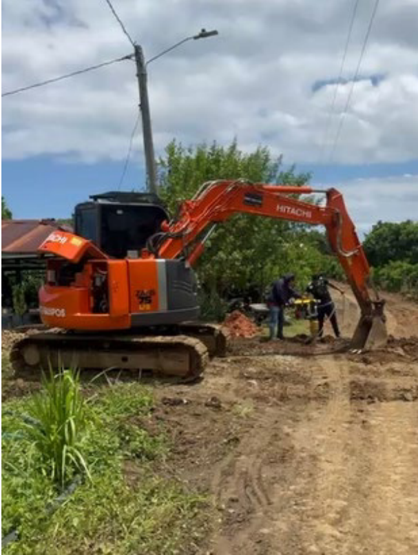
Excavaciones a maquina
