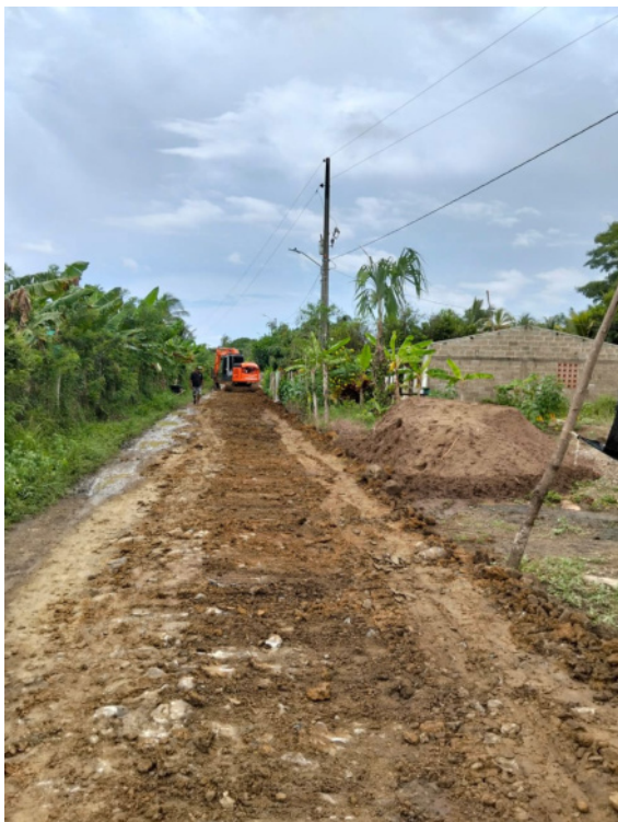
Retiro y adecuación de material
