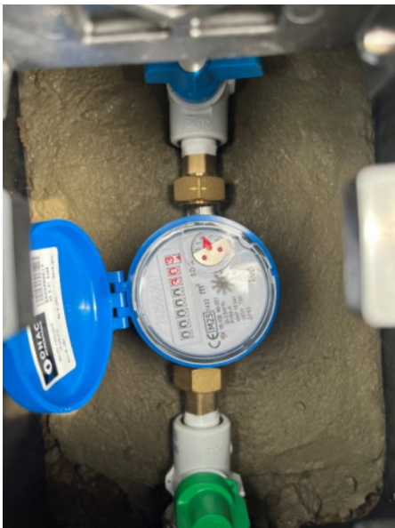
Instalación de domiciliarias
