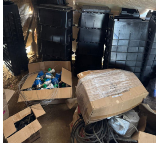
Suministro accesorios domiciliarias
