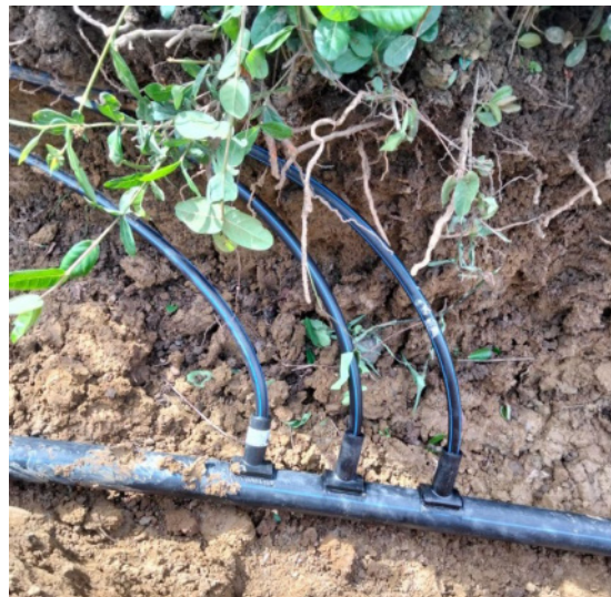
Instalación de domiciliarias
