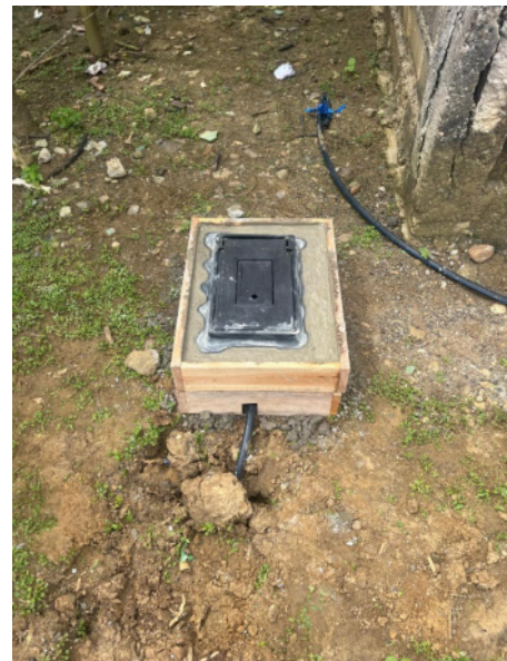
Instalación de domiciliarias
